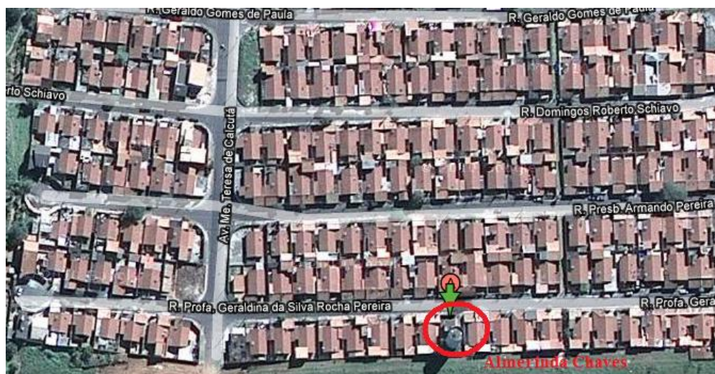
Figura 7.46: Foto aérea da Estação Elevatória Almerinda Chaves (Google Earth, acessado em março de 2010)
