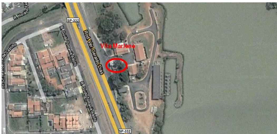
Figura 7.98: Foto aérea da Estação Elevatória Vila Marlene (Google Earth, acessado em março de 2010)
