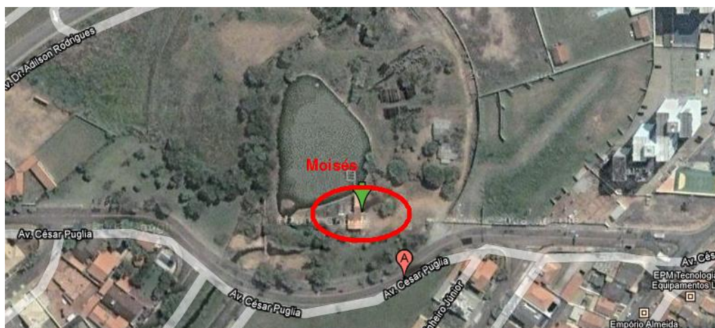
Figura 7.115: Foto aérea da Estação Elevatória Moisés (Google Earth, acessado em março de 2010)
