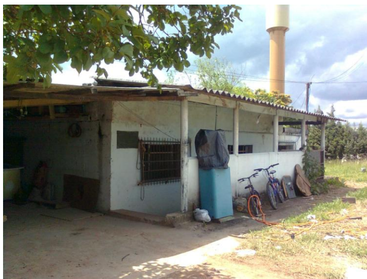
Figura 7.90: Vista externa de Estação Elevatória Cecap (Arquivo Pessoal)
