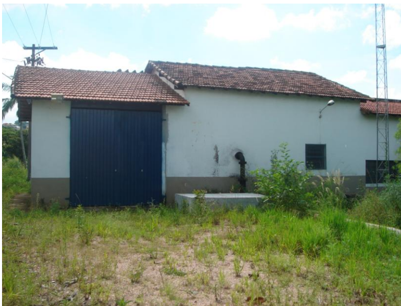
Figura 7.116: Vista externa de Estação Elevatória Moisés (Arquivo Pessoal)
