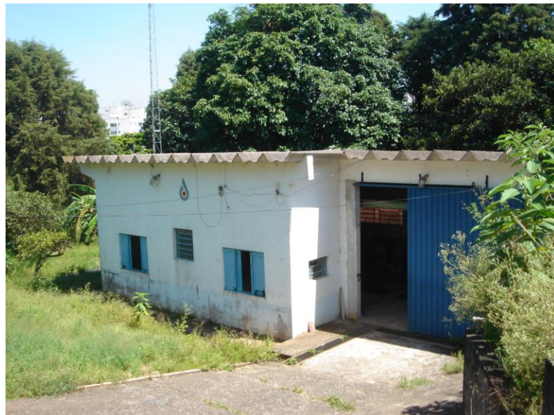
Figura 7.94: Vista externa de Estação Elevatória Vila Jundiainópolis (Arquivo Pessoal)
