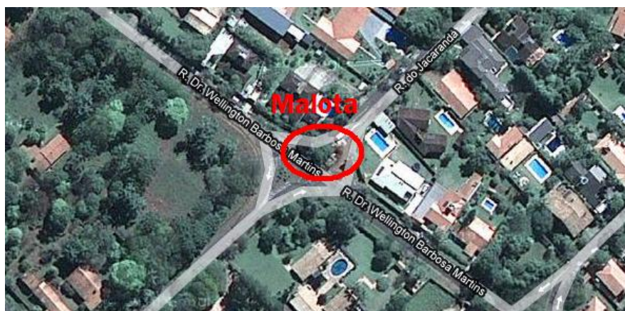
Figura 7.26: Foto aérea da Estação Elevatória Malota (Google Earth, acessado em março de 2010)
