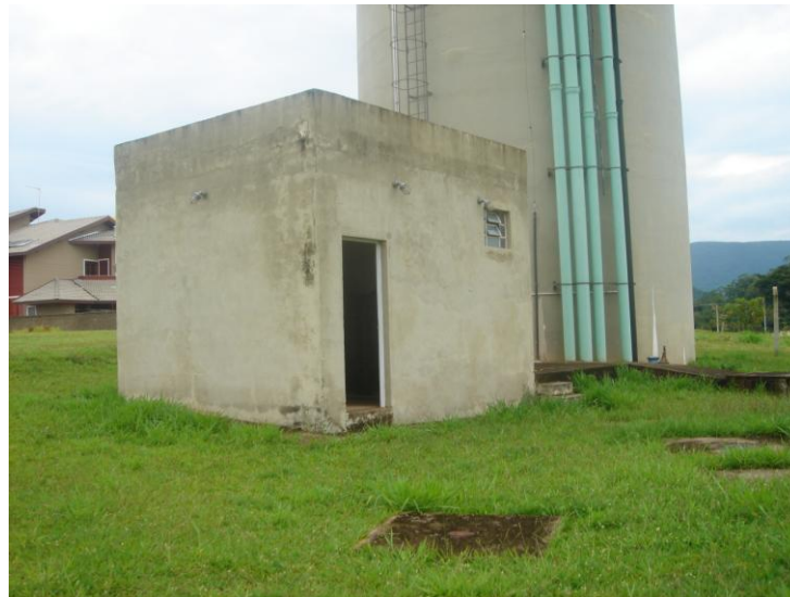
Figura 7.43: Vista externa de Estação Elevatória Reserva da Serra (Arquivo Pessoal)
