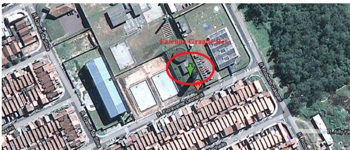
Figura 7.54: Foto aérea da Estação Elevatória Fazenda Grande Residencial (Google Earth, acessado em março de 2010)
