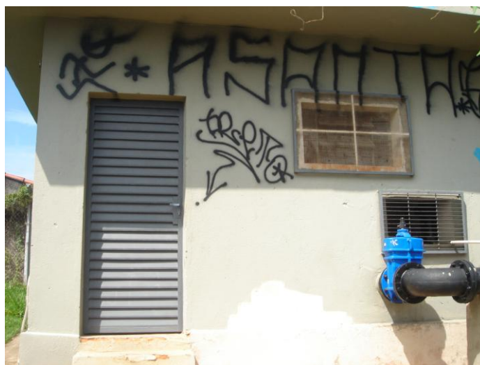
Figura 7.77: Vista externa de Estação Elevatória Santa Gertrudes (Arquivo Pessoal)
