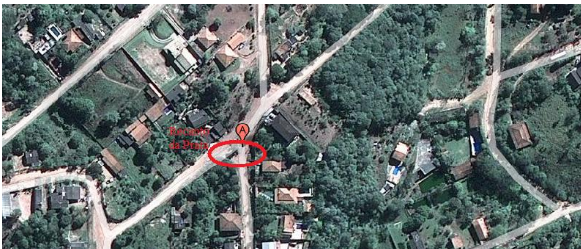
Figura 7.18: Foto aérea da Estação Elevatória Recanto da Prata (Google Earth, acessado em março de 2010)
