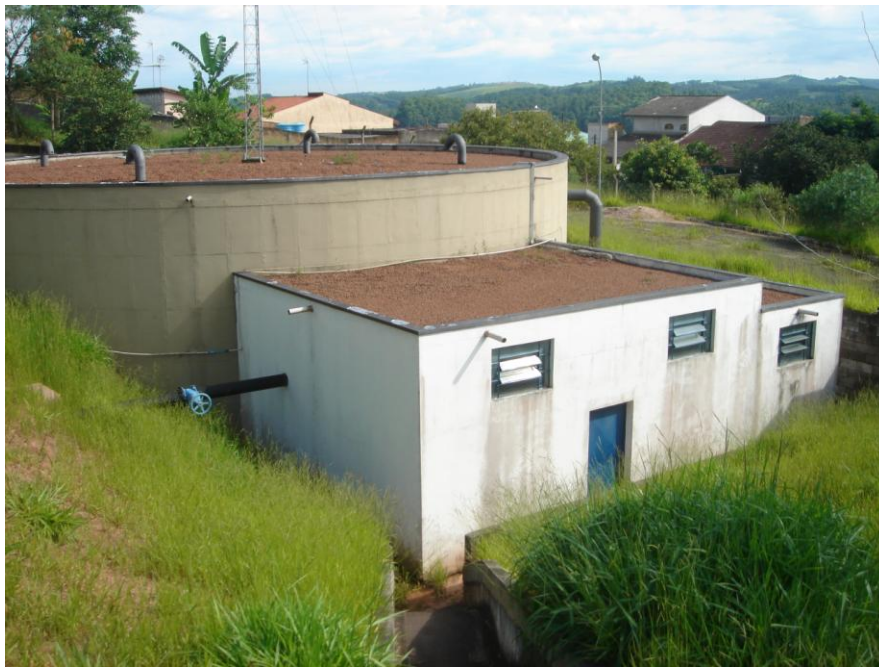
Figura 7.51: Vista externa de Estação Elevatória Araucárias (Arquivo Pessoal)
