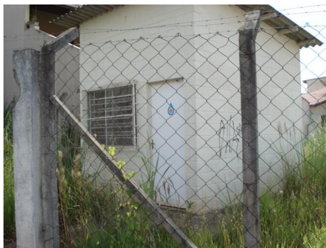
Figura 7.15: Vista externa de Estação Elevatória Cidade Jardim (Arquivo Pessoal)
