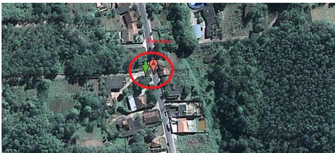
Figura 7.5: Foto aérea da Estação Elevatória Pessoto (Google Earth, acessado em março de 2010)
