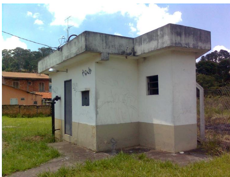
Figura 7.68: Vista externa de Estação Elevatória Tiradentes (Arquivo Pessoal)
