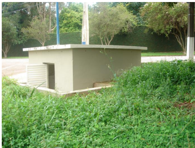
Figura 7.27: Vista externa de Estação Elevatória Malota (Arquivo Pessoal)
