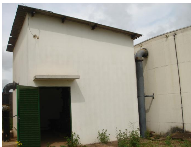
Figura 7.81: Vista externa de Estação Elevatória Fazenda Grande Industrial (Arquivo Pessoal)
