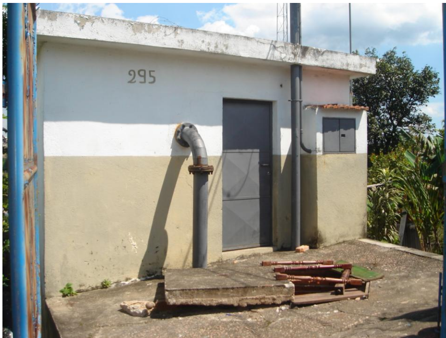
Figura 7.60: Vista externa de Estação Elevatória Josefina (Arquivo Pessoal)
