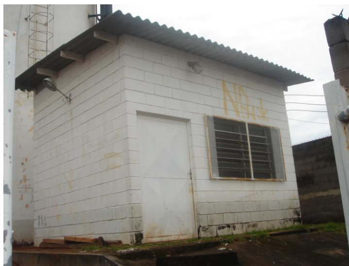
Figura 7.47: Vista externa de Estação Elevatória Almerinda Chaves (Arquivo Pessoal)
