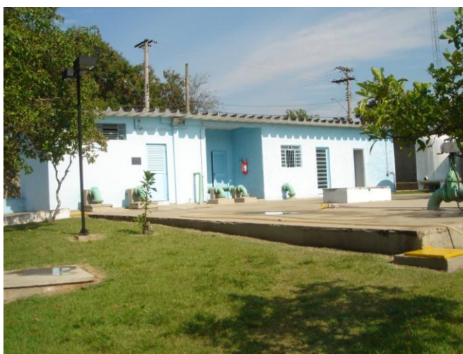
Figura 7.85: Vista externa de Estação Elevatória Eloy Chaves (Arquivo Pessoal)
