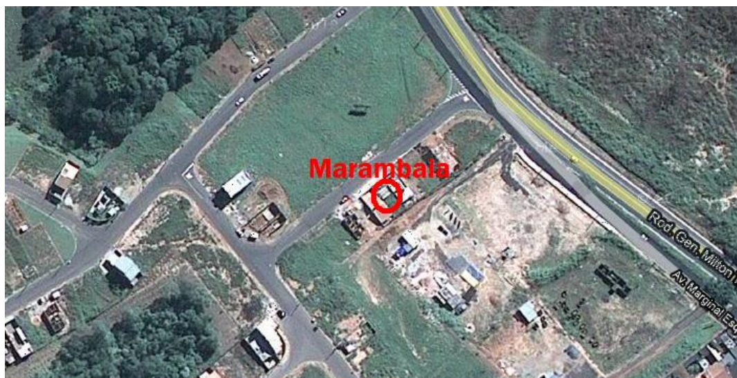
Figura 7.38: Foto aérea da Estação Elevatória Marambaia (Google Earth, acessado em março de 2010)
