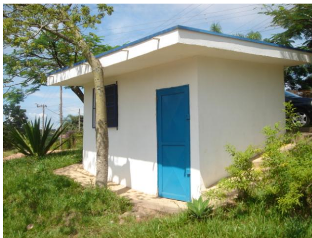
Figura 7.19: Vista externa de Estação Elevatória Recanto da Prata (Arquivo Pessoal)
