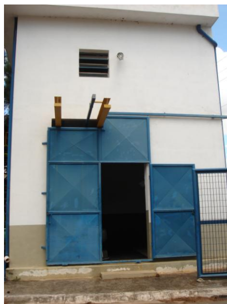
Figura 7.99: Vista externa de Estação Elevatória Vila Marlene (Arquivo Pessoal)
