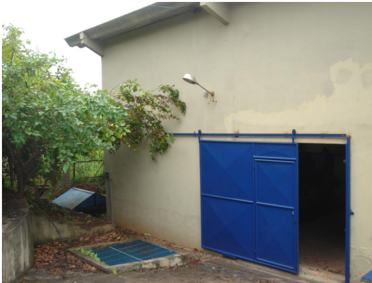
Figura 7.109: Vista externa de Estação Elevatória Vila Progresso (Arquivo Pessoal)
