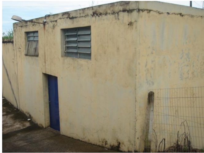
Figura 7.64: Vista externa de Estação Elevatória Califórnia (Arquivo Pessoal)
