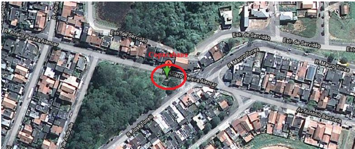
Figura 7.34: Foto aérea da Estação Elevatória Copacabana (Google Earth, acessado em março de 2010)
