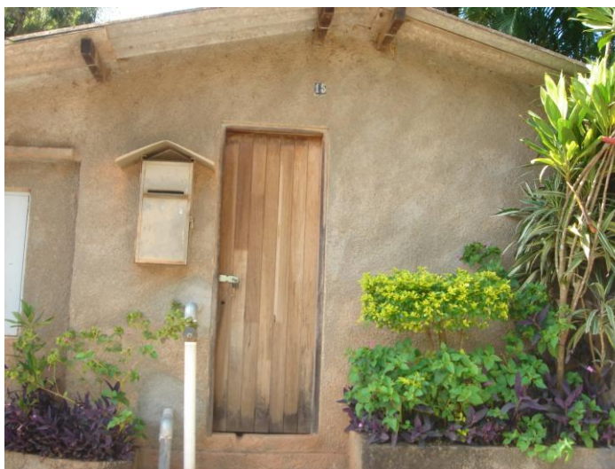
Figura 7.6: Vista externa de Estação Elevatória Pessoto (Arquivo Pessoal)
