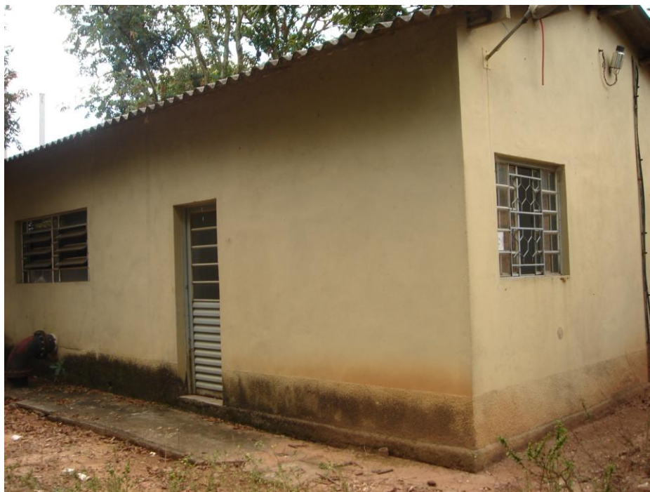
Figura 7.72: Vista externa de Estação Elevatória Água Fria (Arquivo Pessoal)
