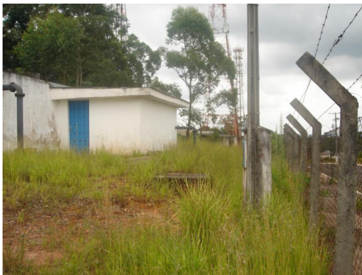
Figura 7.2: Vista externa de Estação Elevatória Portal da Colina (Arquivo Pessoal)
