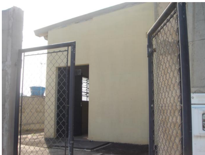
Figura 7.39: Vista externa de Estação Elevatória Marambaia (Arquivo Pessoal)
