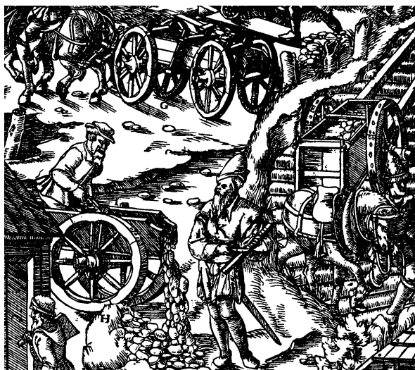
Figura 1.1. Fragmento de gravura do livro De re metallica (Agrícola, 1535) que ilustra um método de transporte de minério empregado na Europa durante o séc. XVI.
