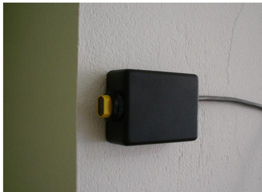
Fig. 6.12: Sensor fotoelétrico instalado no ambiente.
