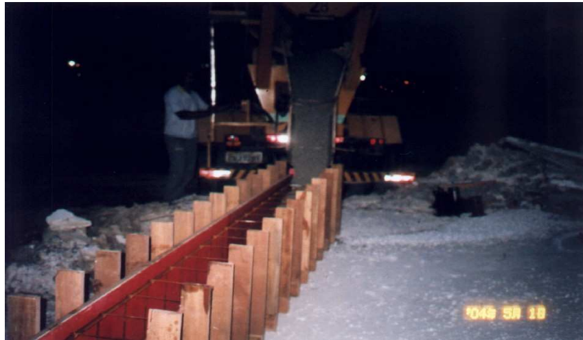
Figura 4.14 – Concretagem da Viga (0,30x0,40x4,00)m. Fonte: MC Bauchemie Brasil / Concrebase
