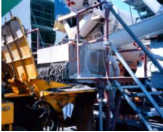
Figura 2.19- Foto do equipamento verificando a fluidez do CAA para descarga em campo.
