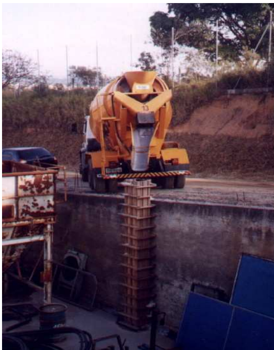
Figura 4.11 – Concretagem do pilar. Fonte: MC Bauchemie Brasil / Concrebase
