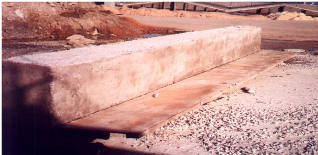
Figura 4.15 – Viga concretada após decimbramento. Fonte: MC Bauchemie Brasil / Concrebase
