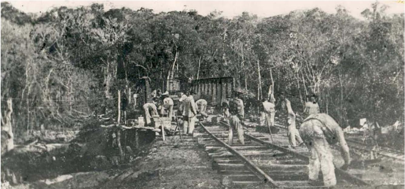
Foto 6. Assentamento da linha e construção de uma ponte sobre o rio Batalha (região de Bauru, 1905-1906).
