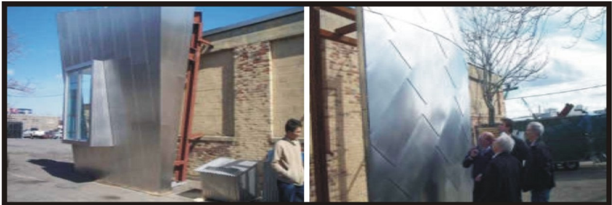
Figura 2.104: Utilização de protótipos em escala 1:1, Strata Center Fonte: Digital Design Fabrication Group, 2006 ( www.ddf.mit )
