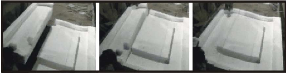
Figura 2.88: Seqüência de montagem de um painel de fachada, Projeto Der Neue Zollhof, Dusseldorf, Alemanha, Frank Gehry Fonte: Schmal (2001)
