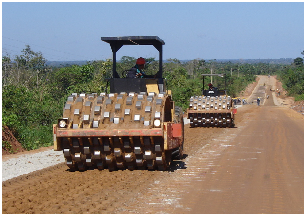
Figura 3.3 – Rolos pé-de-carneiro durante o processo de compactação de camadas viárias.
