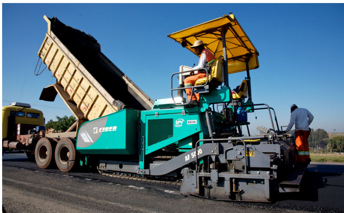
Figura 3.8 – Pavimentadora de esteiras colocando mistura asfáltica.
