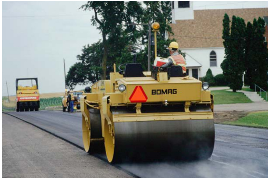
Figura 3.4 – Rolo liso tandem durante o processo de compactação de uma camada asfáltica.
