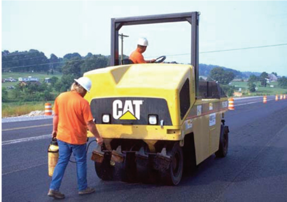
Figura 3.5 – Rolo pneumático durante o processo de compactação de uma camada asfáltica.
