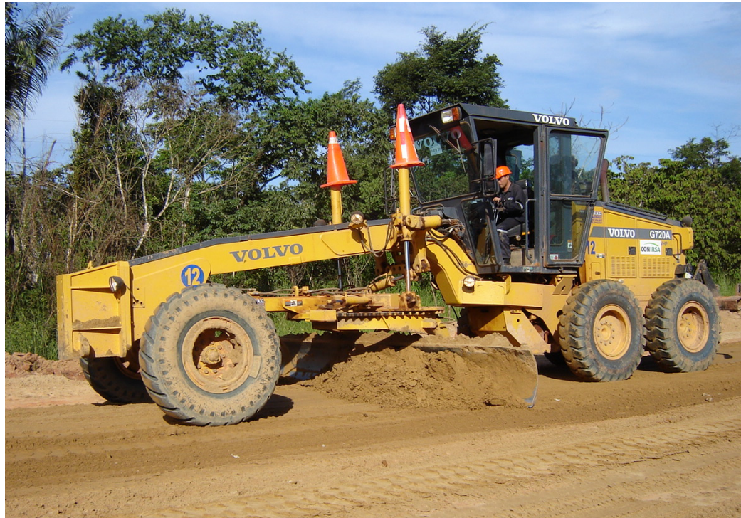
Figura 3.2 – Motoniveladora no trabalho de regularização de camadas do pavimento.
