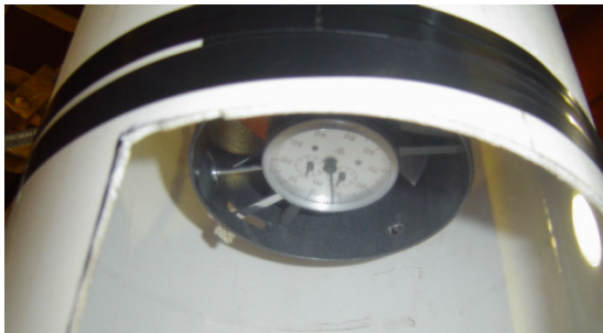
Foto 6.2 Anemômetro instalado na tubulação da campânula.
