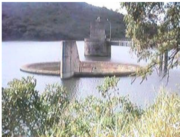
Foto 3.1 Vertedor da Usina de Caconde (SP), conforme Genovez (1997).
