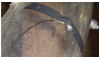
Foto 6.6 Acelerômetro instalado na curva.
