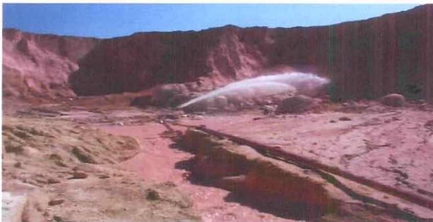
Figura 10 – Jato de água utilizado no desmorte hidráulico
