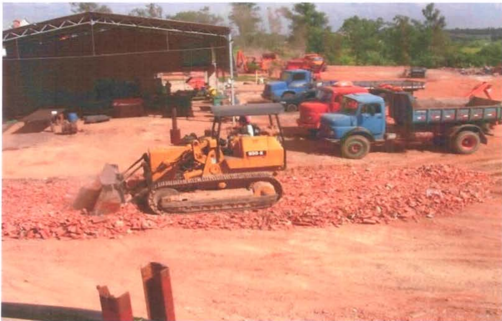
Figura 32 – Vista da disposição de material inerte no terreno em recuperação topográfica. Ao fundo, área já recuperada sendo utilizada para a atividade fim proposta.
