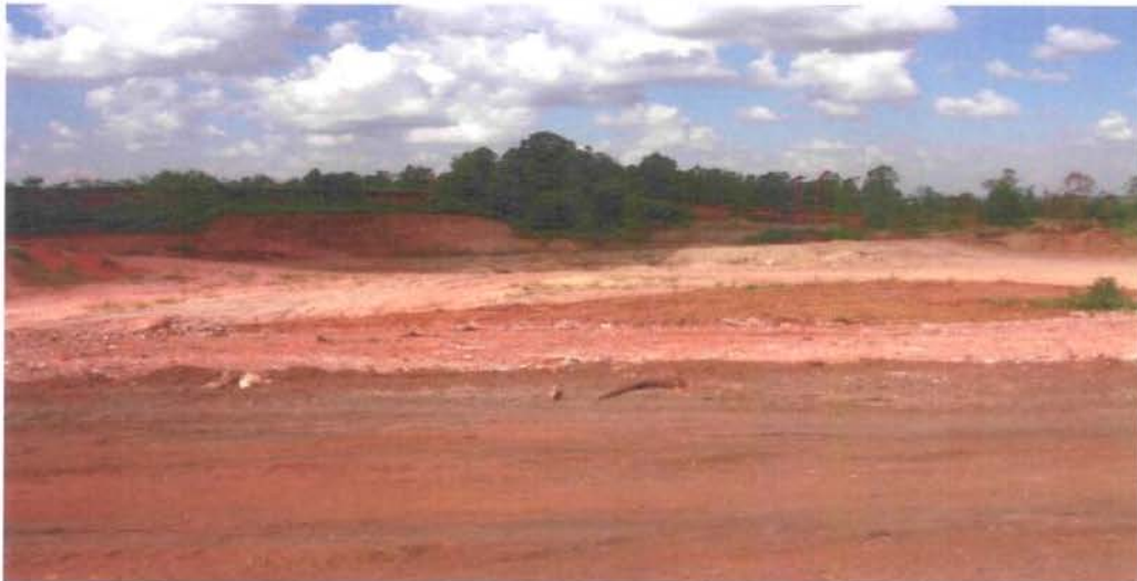
Figura 30 – Área aterrada com material inerte, recuperando topograficamente o terreno.
