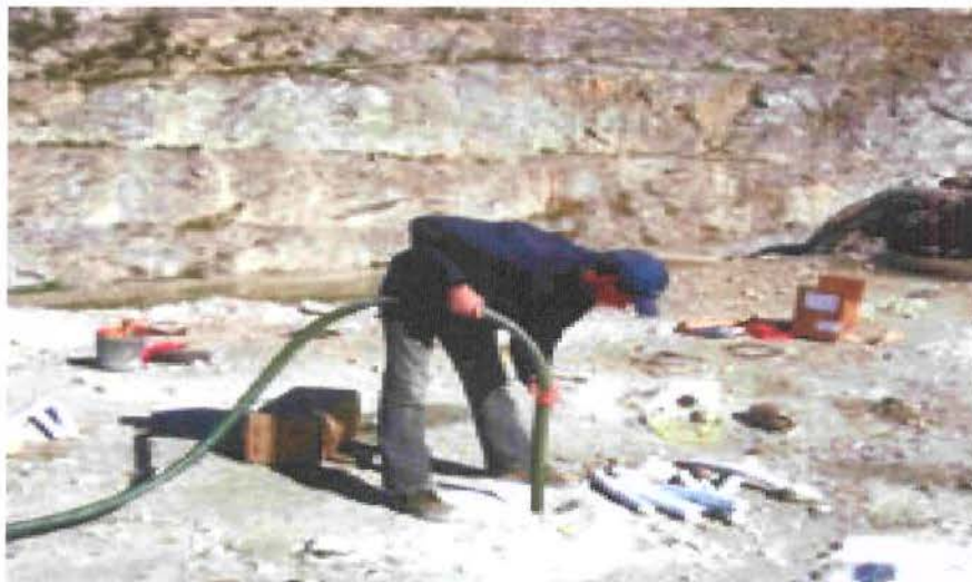
Figura 13 – Carregamento de explosivos nos furos feitos na rocha
