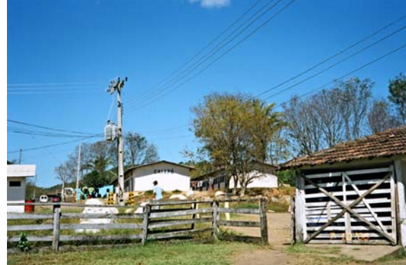
(5.9) Alojamentos montados no canteiro de obras da PCH Mosquitão
