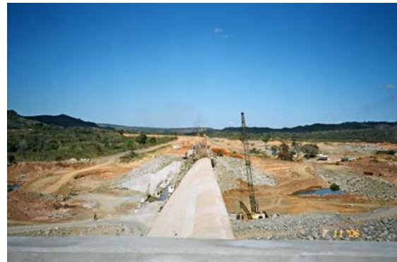
(5.2) Paredão da barragem da PCH Mosquitão
