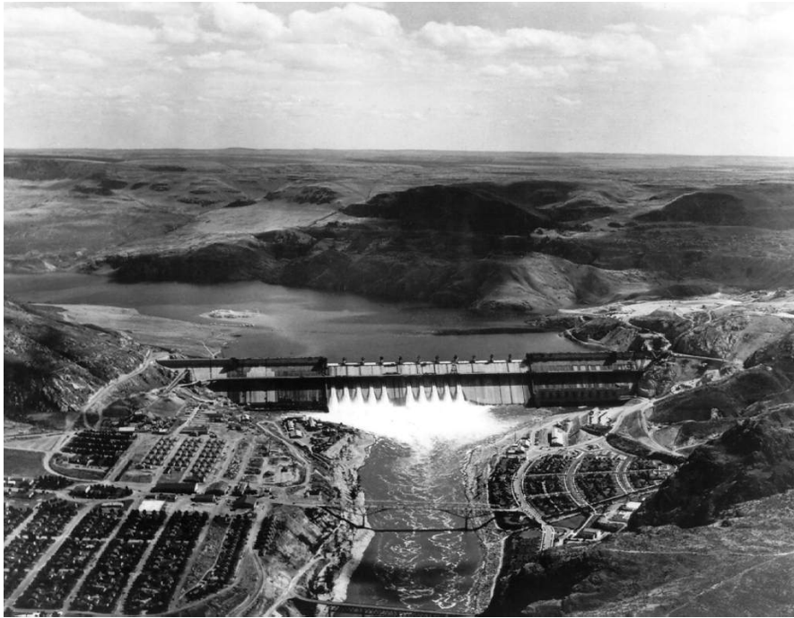
Foto da hidrelétrica de Grand Coulee, rio Columbia, EUA, quase completa. Junho, 1941.
