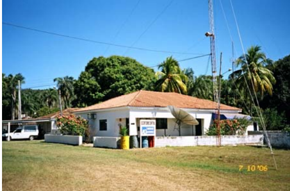
(5.8) Escritório da empresa Andrade Gutierrez no canteiro de obras da PCH Mosquitão
