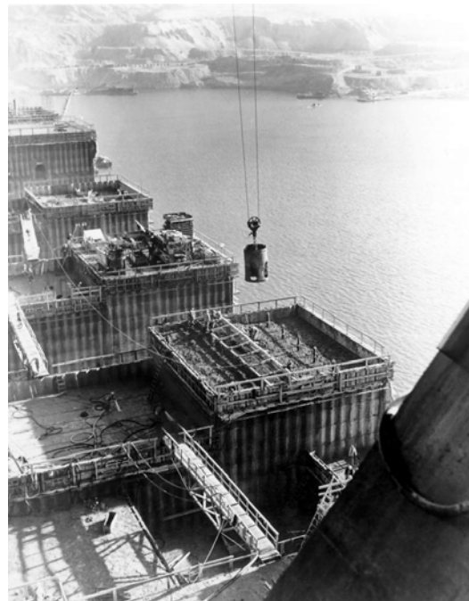
Construção de Grand Coulee. Novembro, 1939.
