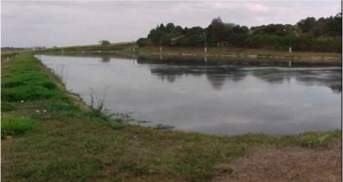
Figura 3.1 Lagoa de estabilização anaeróbia da ETE – Graminha (Limeira-SP)
