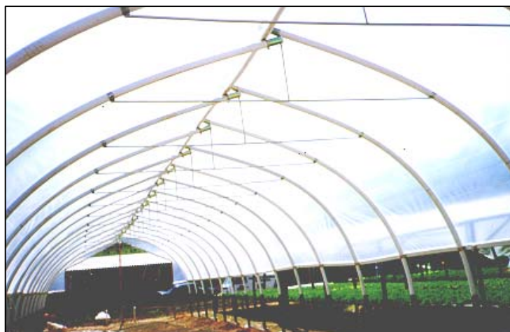
Figura 13. Estrutura comercialmente vendida, tipo túnel alto em formato gótico (Hidrogood®).
