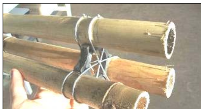
Figura 7. Método de amarração dos colmos no espaçador.
