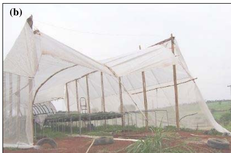
Figura 30. Vista da estrutura tipo tenda construída com bambu antes (a) e após a modificação na fixação do plástico de cobertura (b).
