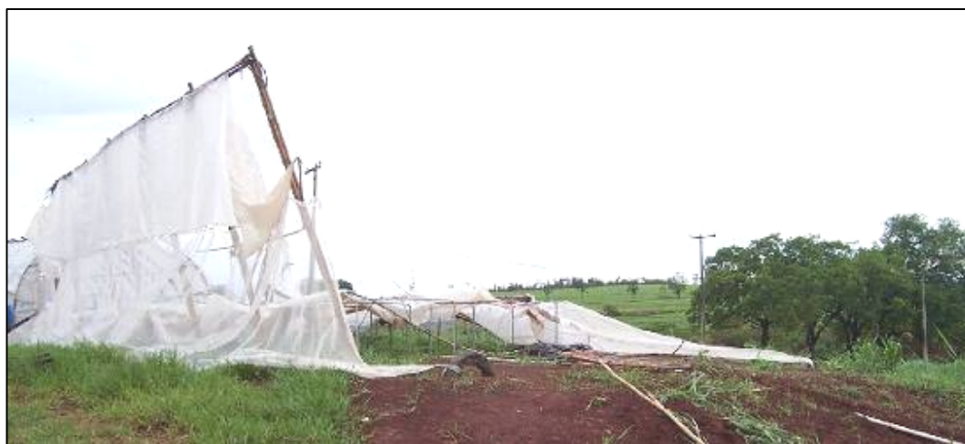
Figura 32. Vista da estrutura tipo tenda construída com bambu, após destruição ocorrida por ação de vento de 115,5 km/h.
