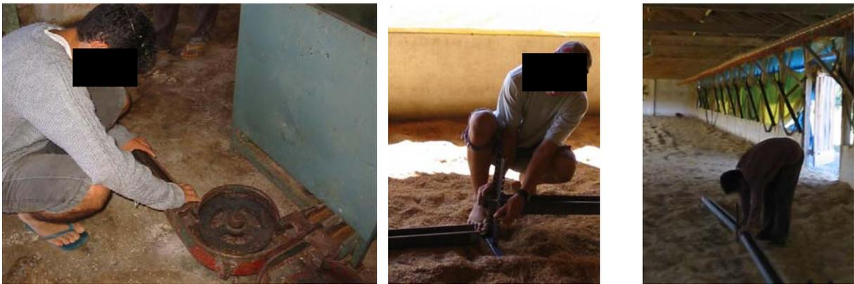
FIGURA 44. Subtarefa: Colocação e nivelamento dos equipamentos
