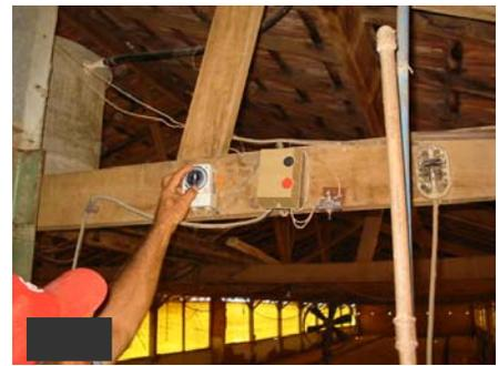
FIGURA 12. Subsistema 10: Controle de temperatura, umidade, luz e ventilação
