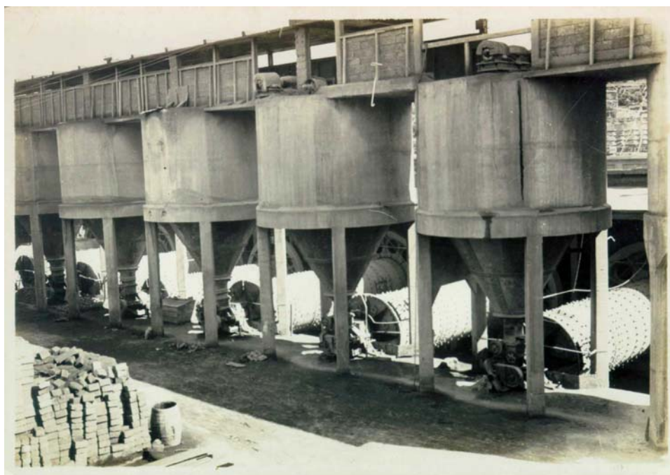
Silos que alimentam os moinhos cilíndricos, que aparecem na parte inferior (13)
