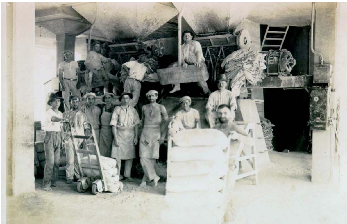
Aspecto do setor de sacaria da fábrica de cimento (15)
