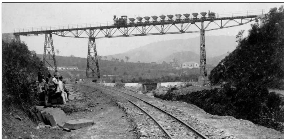
Composição da CBCPP em trecho da Estrada de Ferro Perus-Pirapora, na altura de Gato Preto (7).
