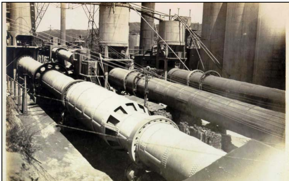
Esses três equipamentos compridos e cilíndricos são os fornos onde o cimento é calcinado (14)
