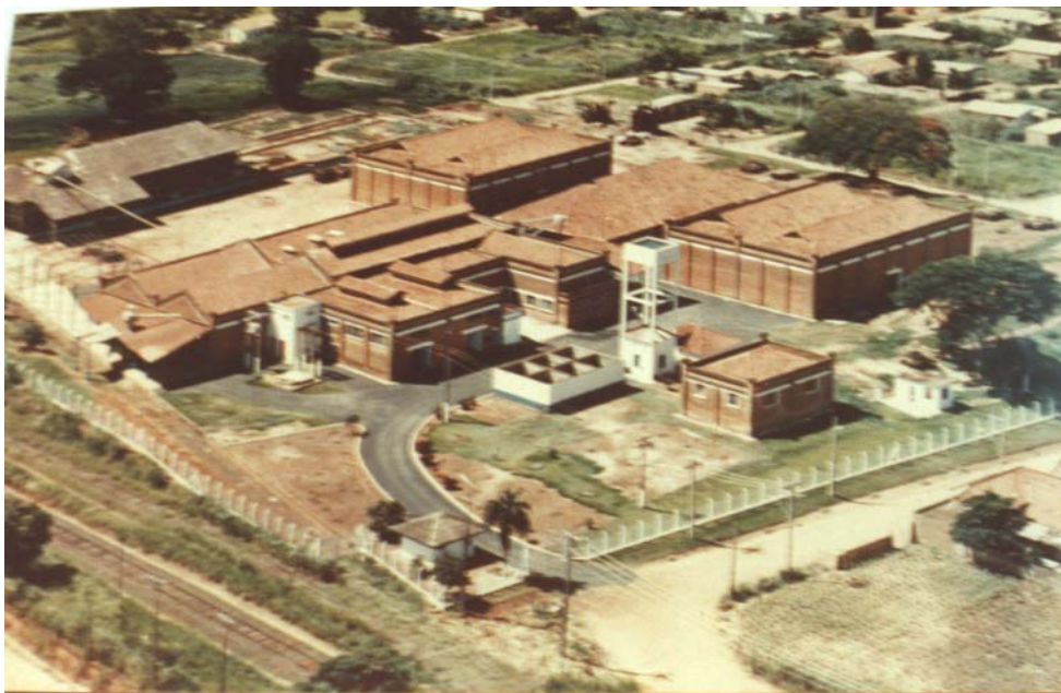
Foto aérea atual do núcleo industrial de algodão Matarazzo. Percebe-se que a maioria dos galpões permanecem conservados. Votuporanga, sem data. Fonte: Arquivo da indústria Universo Cotton Ltda.
