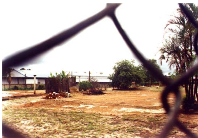
Antiga área da tecelagem Matarazzo, recentemente demolida. Bauru, novembro de 2003. Foto do autor.
