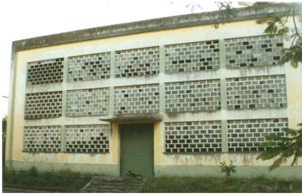
Fachada do edifício da caldeira, gerador, bombas e cabos elétricos. Campinas, abril 2002. Foto do autor.
