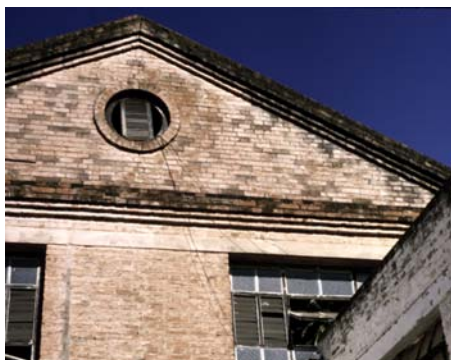
Detalhe da fachada posterior do Depósito de Algodão. Ribeirão Preto, 1985. Foto de Rita Fantini e Onésimo de Carvalho.
