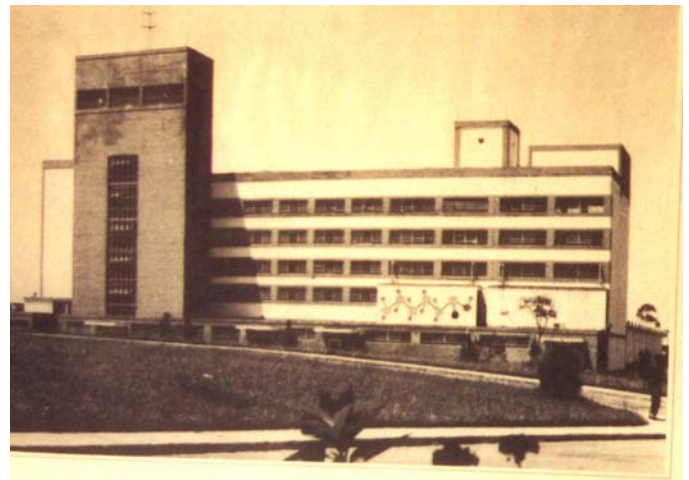
Edifício principal da Textilquímica , com um painel instalado na fachada. São José dos Campos, sem data. Fonte: (PENEDO, 1997:169).
