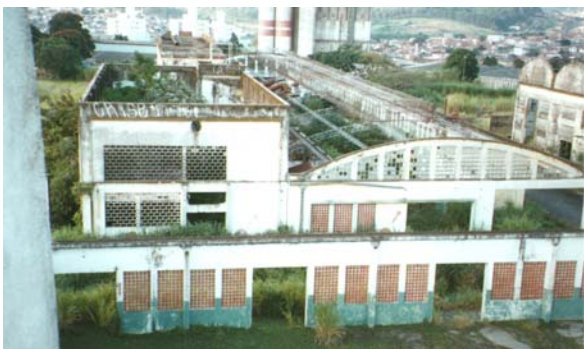
Vista aérea dos salões de linter, de óleo bruto e resíduo de pó. Campinas, abril 2002. Foto do autor.
