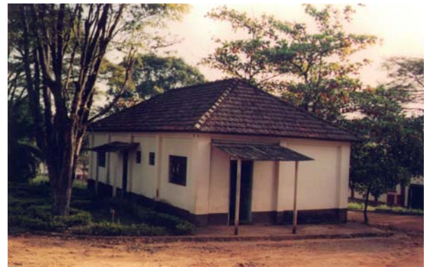
Edifício da administração da indústria Matarazzo. São João da Boa Vista, maio de 2002. Foto do autor.
