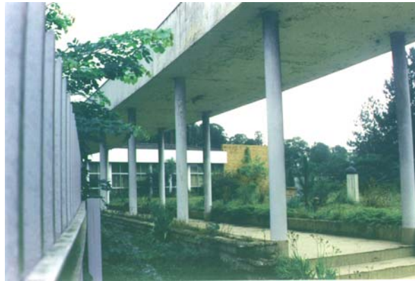
Via de pedestres, protegida por um passadiço de laje e pilotis, que liga a portaria ao escritório. São José dos Campos, maio 2002. Foto do autor.
