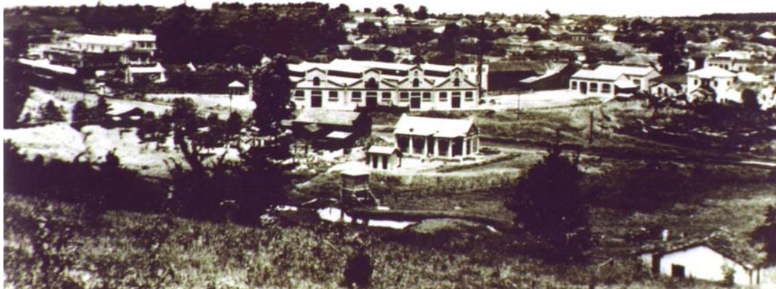
Vista dos quatro galpões e a caixa d'água, com a inscrição IRFM, da indústria de algodão Matarazzo. Avaré, sem data. Fonte: Arquivo Joaquim Negrão.
