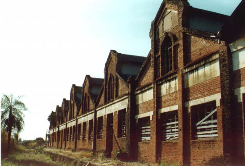
Primeiro pavilhão construído no núcleo fabril da tecelagem Matarazzo. Bauru, julho 2002. Foto do autor.
