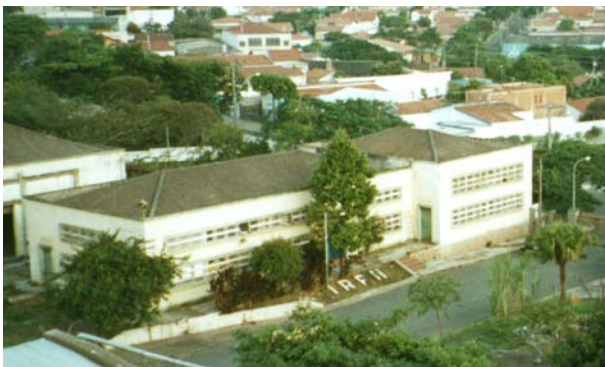
Edifício do escritório e ambulatório, com as linhas e planos horizontais, em relevo e bem marcados. Campinas, abril de 2002. Foto do autor.
