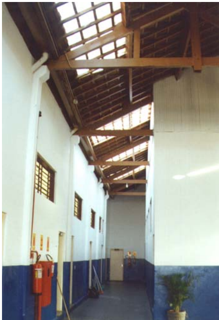
Corredor de distribuição das salas, com a estrutura da cobertura aparente. Avaré, maio de 2002. Foto do autor.
