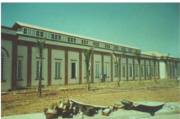
Edifício da administração, no período de conclusão das obras do shopping. A fachada foi conservada, bem como, o lanternim do edifício. Rio Claro, 1995. Fonte: Arquivo do Shopping Center Rio Claro.
