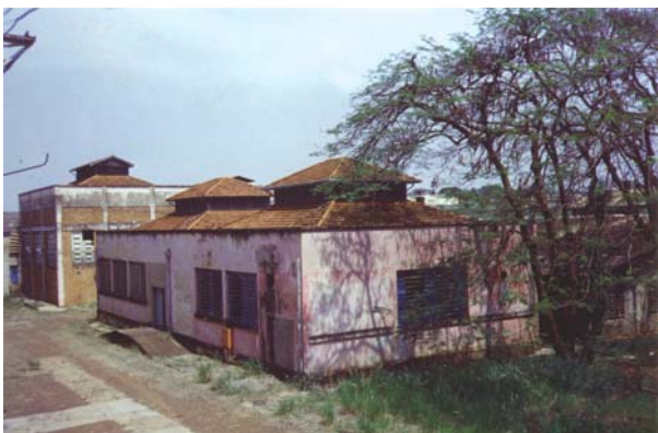
O pavilhão da tinturaria (em primeiro plano) e, atrás, a casa das caldeiras, sem a chaminé. Ribeirão Preto, 1998. Fonte: Yolanda Cipriano.
