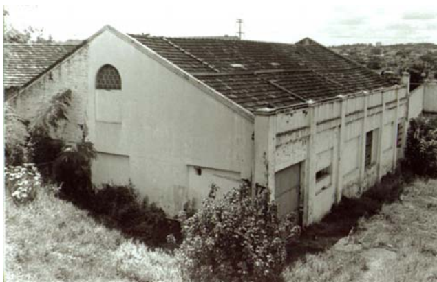
Fachada posterior do Depósito de Sal. Ribeirão Preto, novembro de 2000. Foto do autor.
