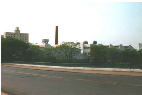
Edifícios remanescentes da indústria de seda Matarazzo. Campinas, outubro 2002. Foto do autor.
