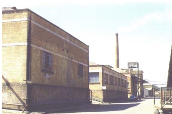
Da esquerda para a direita, o galpão dos deslintadores, das oficinas e escritório e da caldeira e turbinas. Rancharia, julho 2002. Foto do autor.
