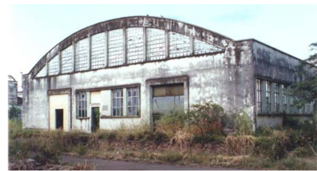
Fachada de outro depósito, que tem a mesma tipologia do depósito de farelo. Campinas, abril 2002. Foto do autor.
