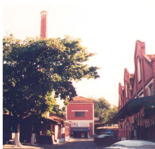
A casa das caldeiras, ao fundo da fábrica de óleo. Araçatuba, junho de 2002. Foto do autor.
