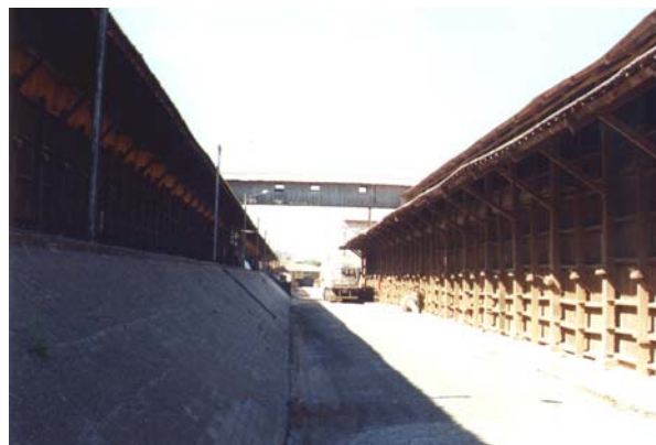
Os dois silos e a plataforma aérea de ligação. Rancharia, julho 2002. Foto do autor.
