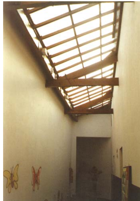
Corredor que permanece com a cobertura original do galpão. Avaré, maio de 2002. Foto do autor.
