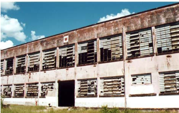
Fachada de trás do edifício de preparação da fiação. Ribeirão Preto, janeiro 2000. Foto do autor.
