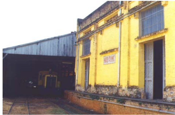
O início da plataforma coberta, junto ao almoxarifado e ao armazém. Rancharia, julho 2002. Foto do autor.
