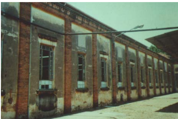
Antigo edifício da administração da fábrica Matarazzo. Rio Claro, foto tirada posteriormente à desativação da Cianê. Fonte: Arquivo do Shopping Center Rio Claro.
