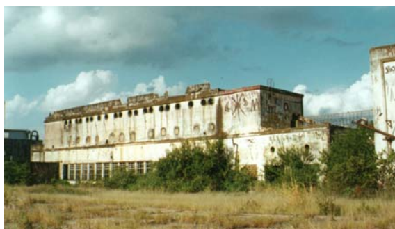
Lateral do salão de óleo bruto e resíduos de pó. Campinas, abril 2002. Foto do autor.
