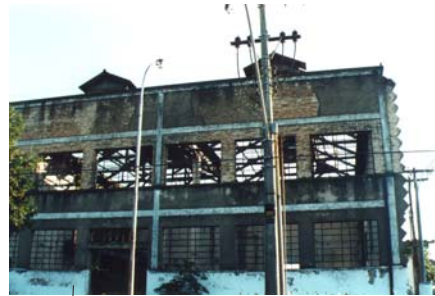
Casa das Caldeiras. Marília, julho 2002. Foto do autor.
