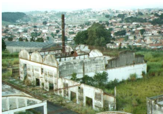
Vista aérea da usina termoeétrica. Campinas, abril 2002. Foto do autor.
