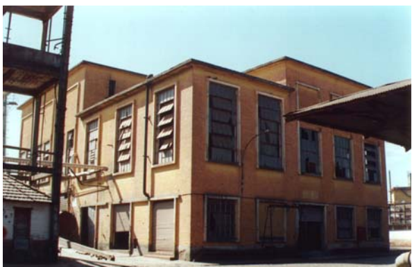
A casa das caldeiras, com algumas modificações no edifício. Rancharia, julho 2002. Foto do autor.
