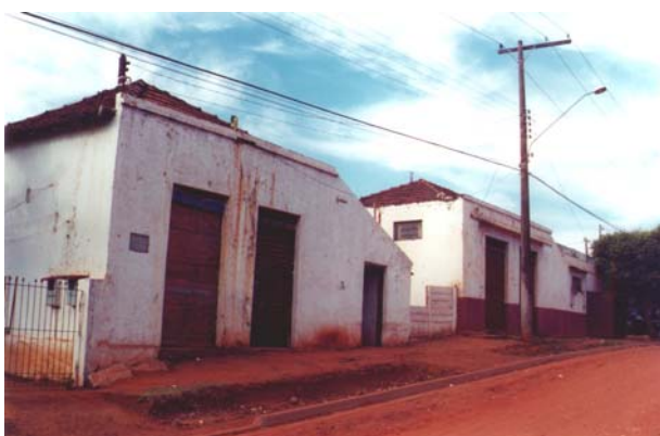
Possivelmente residências de operários, defronte à entrada da indústria Matarazzo. Votuporanga, julho 2002. Foto do autor.
