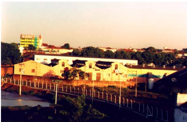
Galpões Matarazzo. São José do Rio Preto, julho de 2002. Foto do autor.
