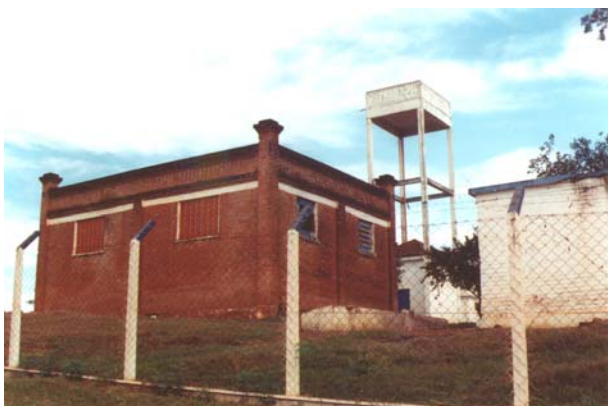
Galpão do núcleo industrial Matarazzo. Votuporanga, julho 2002. Foto do autor.
