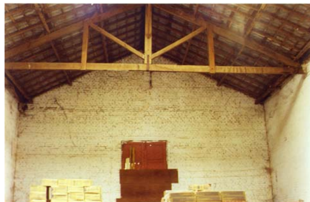
Detalhe de um outro modo de armação da tesoura. Itapetininga, novembro de 2003. Foto do autor.
