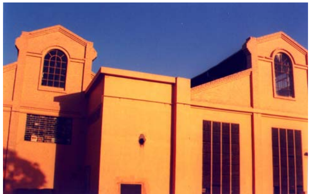
Detalhe dos galpões Matarazzo. São José do Rio Preto, julho de 2002. Foto do autor.
