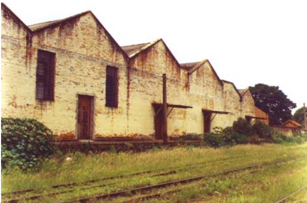
Parte dos galpões Matarazzo, à beira da linha férrea. Itapetininga, novembro de 2003. Foto do autor.
