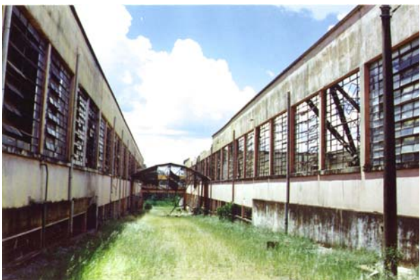
A esquerda, fiação; à direita, preparação da fiação, sem cobertura. Ribeirão Preto, janeiro 2001. Foto do autor.
