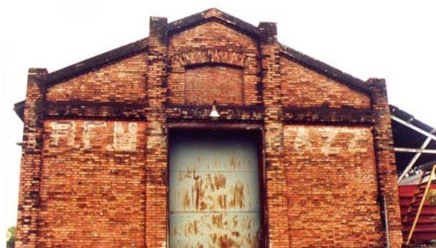
Fachada posterior do armazém Matarazzo. Bauru, novembro de 2003. Foto do autor.
