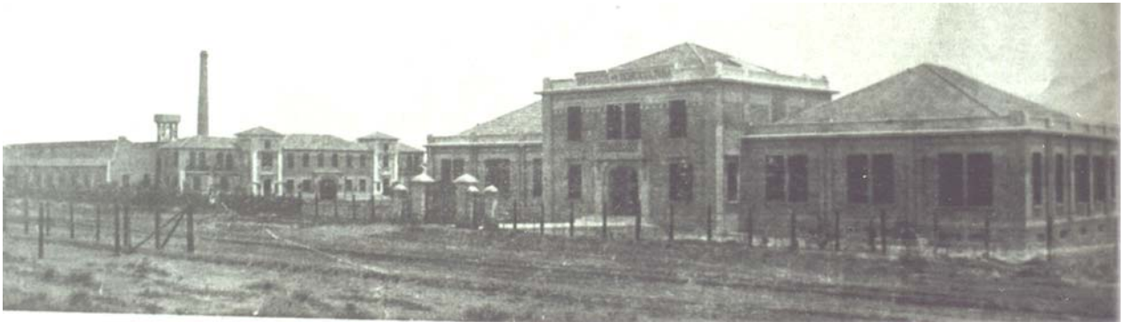
Vista geral das fábricas de seda nacional. À esquerda da foto, os edifícios e a chaminé, destinados às seções de fiação e torção. Campinas, sem data. Fonte: (GIANOLI, 1929:604).
