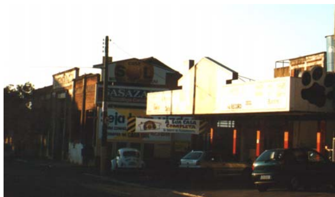
O "portal", já com as transformações no seu entorno. Marília, julho de 2002. Foto do autor.
