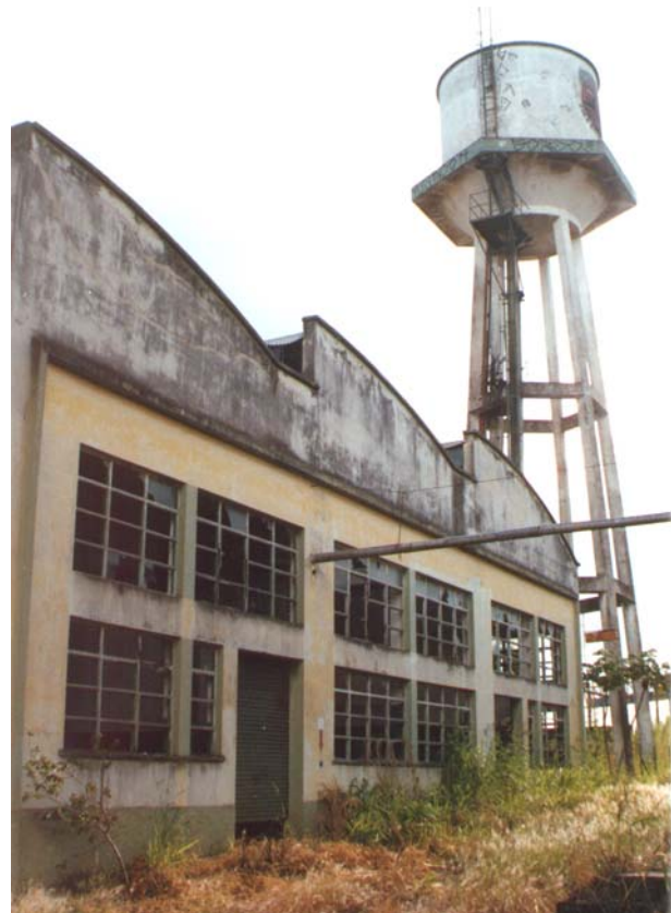
Lateral do edifício da caldeira e outros, com a presença dos sheds. Campinas, abril 2002. Foto do autor.
