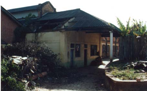
Edifícios da tecelagem Matarazzo, defronte a cerca de madeira. Bauru, julho 2002. Foto do autor.
