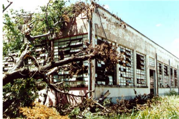
Edifício da tecelagem. Ribeirão Preto, janeiro 2001. Foto do autor.
