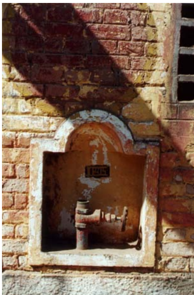
Detalhe do trabalho em tijolo para o abrigo do hidrante. Rancharia, julho 2002. Foto do autor.
