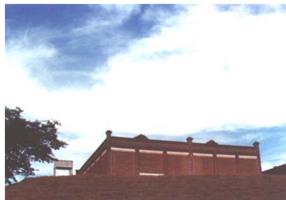
Galpão do núcleo industrial Matarazzo. Votuporanga, julho 2002. Foto do autor.
