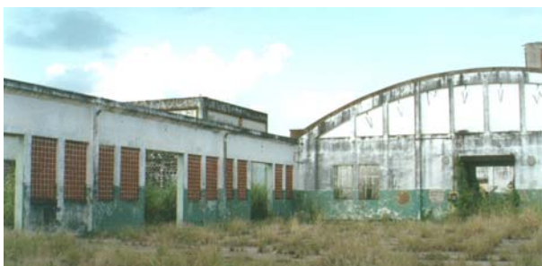
Vista interna do depósito, almoxarifado e carpintaria. Campinas, abril 2002. Foto do autor.
