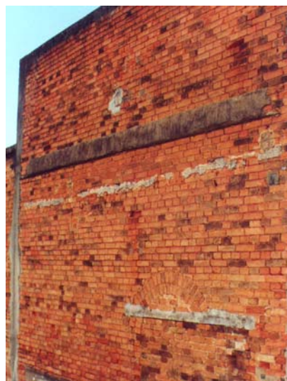
Detalhe do arco abatido de tijolos, embutido na parede de um galpão. Itapetininga, novembro de 2003. Foto do autor.
