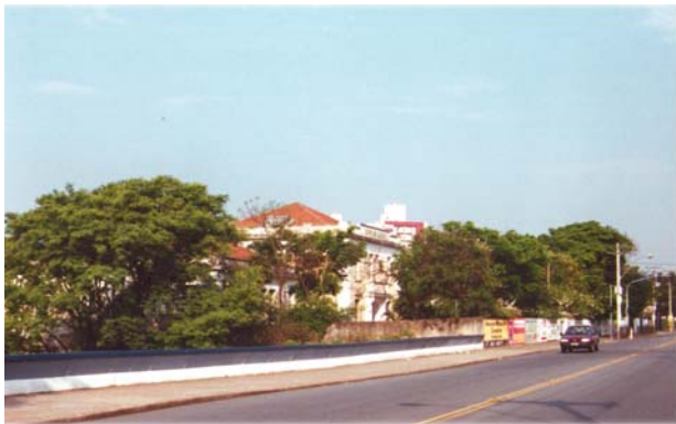
Vista do eixo que liga a Escola Estadual Dom Barreto aos outros edifícios remanescentes da indústria de seda Matarazzo. Campinas, outubro 2002. Foto do autor.
