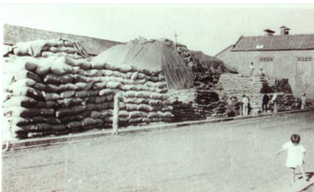
Vista do local de armazenamento do algodão, na indústria Matarazzo de beneficiar algodão. Bernardino de Campos, sem data. Foto de João G. Matiello.
