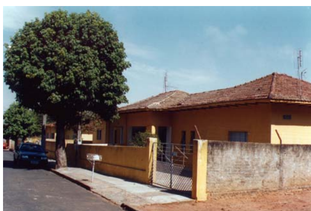
Residências dos engenheiros, que estão pintadas com a mesma cor do Hotel e das outras residências operárias. Rancharia, julho 2002. Foto do autor.
