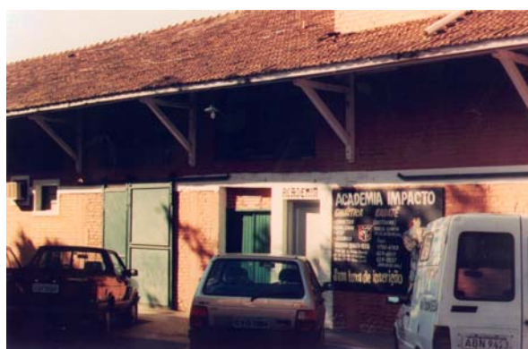
Na lateral desse galpão, funciona uma academia de ginástica e Karatê. Foram conservados o beiral do telhado, as suas tesouras em madeira e as portas de correr, também em madeira, da época de sua construção. Araçatuba, junho 2002. Foto do autor.
