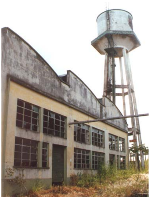
Lateral do edifício da caldeira, com linhas horizontais, marcadas pelas aberturas e os sheds, desenhados em curva. Campinas, abril de 2002. Foto do autor.
