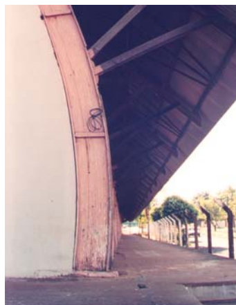
Detalhe do arco de sustentação, em madeira, do depósito da Matarazzo. Araçatuba, junho 2002. Foto do autor.
