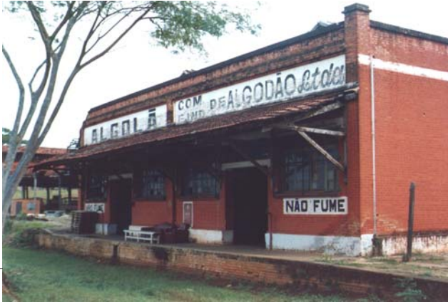
Esse edifício foi o Depósito de Fardos, e é elevado, para facilitar o carregamento dos vagões, que chegavam ao desvio dos trilhos à sua frente. Presidente Venceslau, agosto 2002. Foto do autor.
