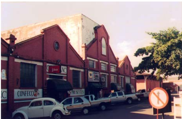
Pavilhão da indústria de beneficiamento do algodão. Araçatuba, junho de 2002. Foto do autor.
