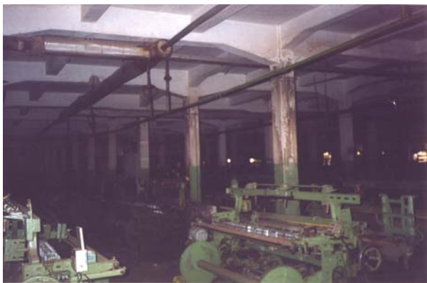
Máquinas do primeiro subsolo do galpão da tecelagem. Ribeirão Preto, setembro 1998. Foto do autor.
