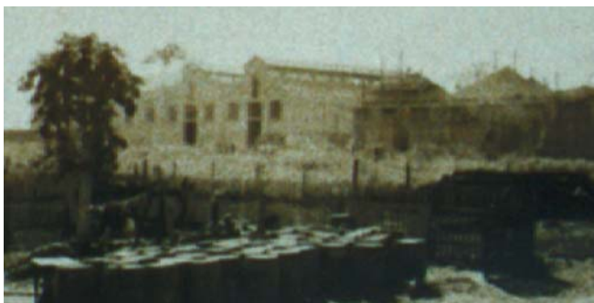
Galpões em construção da Matarazzo. Rancharia, anos 30. Foto de Tiaki Zoriki.
