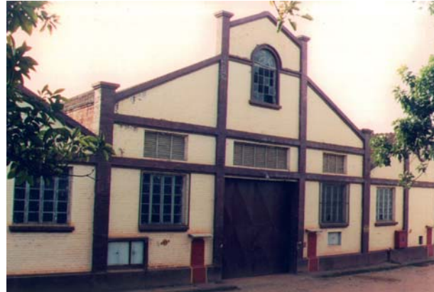
O armazém mais alto, no meio dos cinco, sem o óculo, com aberturas envidraçadas nas laterais; no alto do frontão, uma janela em arco pleno e, abaixo, o portão. São João da Boa Vista, maio de 2002. Foto do autor.
