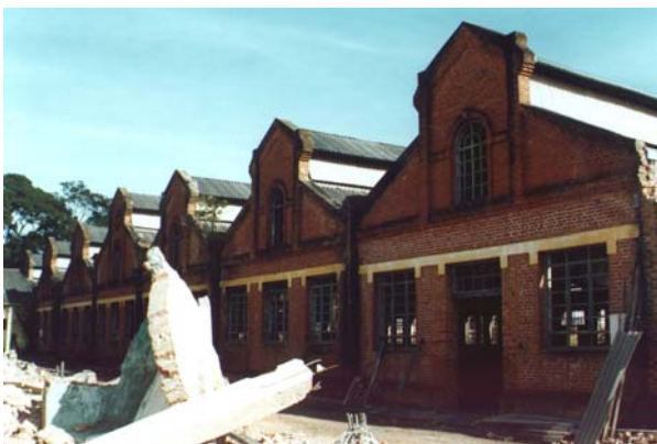
O pavilhão principal da tecelagem Matarazzo. Bauru, julho 2002. Foto do autor.
