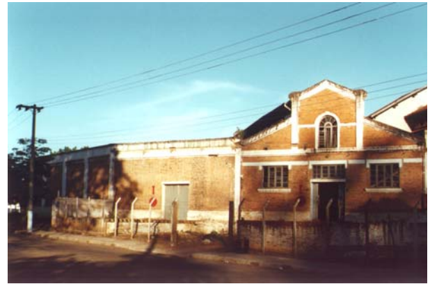
Início da fachada dos quatro galpões principais da indústria Matarazzo. Avaré, maio de 2002. Foto do autor.
