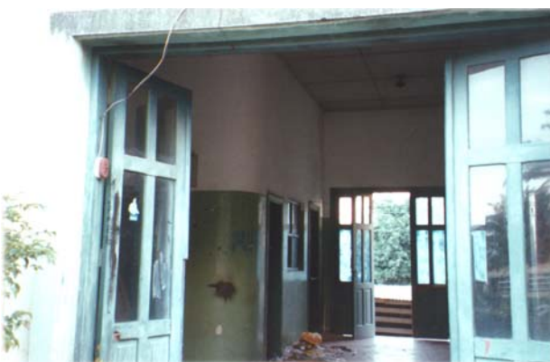
Vista interna do vestiário. Campinas, abril 2002. Foto do autor.
