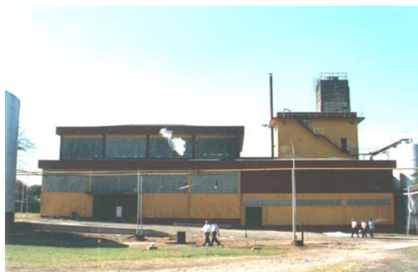
Galpão, possivelmente dos anos 50, para a refinação do óleo. Rancharia, julho 2002. Foto do autor.
