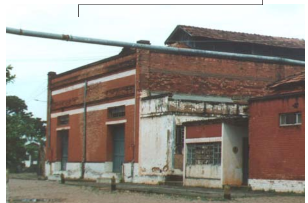
Fachada do Depósito de Fitas de Aço e Sacos e Depósito de Veneno. Presidente Venceslau, agosto 2002. Foto do autor.
