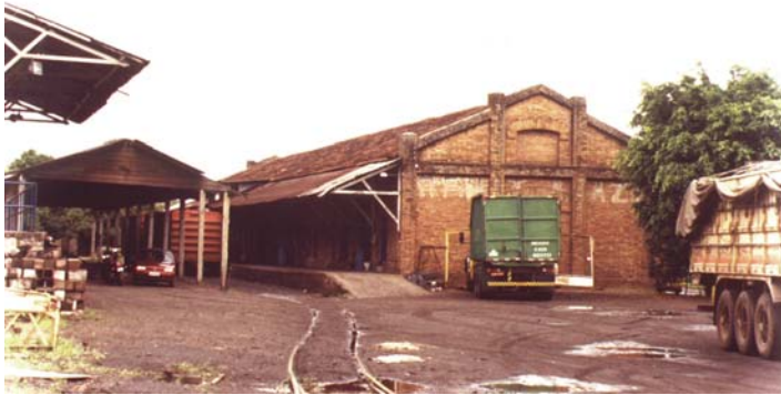
Fachada principal do armazém Matarazzo. Bauru, novembro de 2003. Foto do autor.
