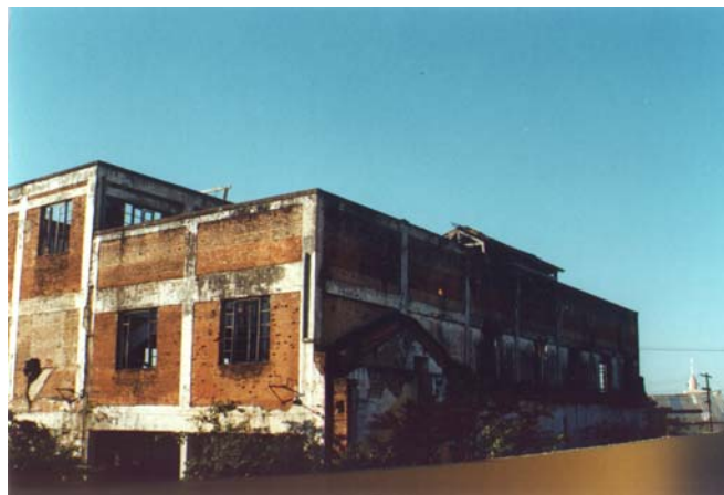
A casa das caldeiras. Marília, julho de 2002. Foto do autor.
