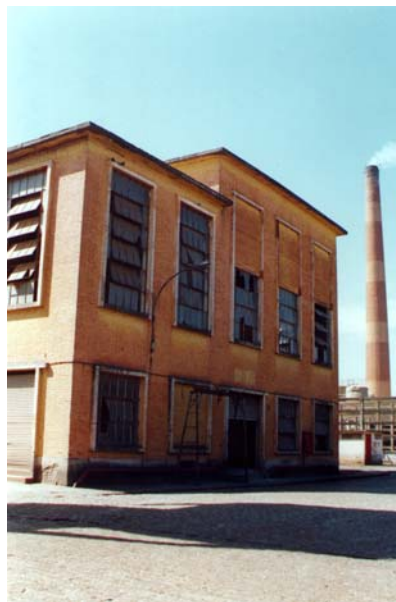
Fachada da casa das caldeiras. Rancharia, julho 2002. Foto do autor.
