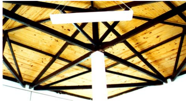
Detalhe da estrutura em madeira de sustentação da biblioteca. Avaré, maio de 2002. Foto do autor.
