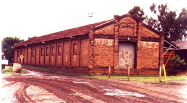
Fachada posterior do armazém Matarazzo. Bauru, novembro de 2003. Foto do autor.
