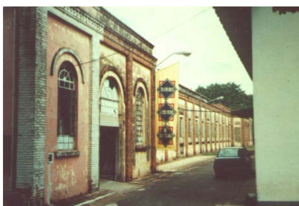
Edifício da administração da fiação e tecelagem Matarazzo. Rio Claro, anos 90. Fonte: Arquivo do Shopping Center Rio Claro.
