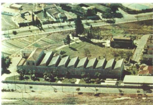
Vista aérea do galpão de teares de seda da fábrica Matarazzo. Rio Claro, anos 80. Fonte: Arquivo do Shopping Center Rio Claro.
