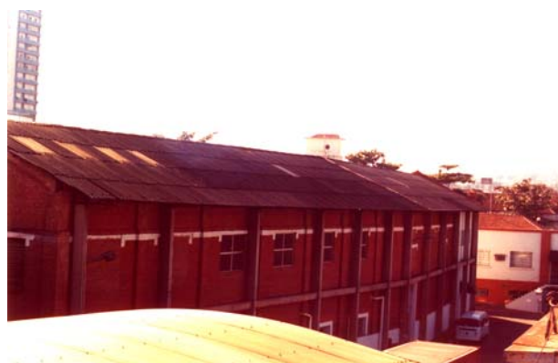
O depósito de algodão, reforçado com pilares e vigas de concreto armado. Catanduva, junho 2002. Foto do autor.
