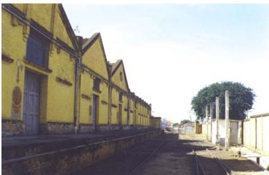
Os primeiros edifícios de beneficiamento do algodão. Rancharia, julho 2002. Foto do autor.
