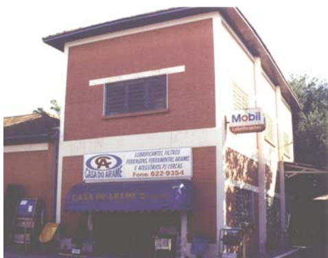
Casa das caldeiras, transformada em comércio. Araçatuba, junho 2002. Foto do autor.
