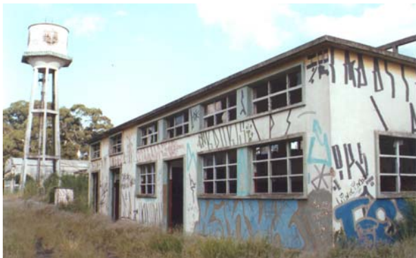
Edifício de extração de óleo e solvente. Campinas, abril 2002. Foto do autor.
