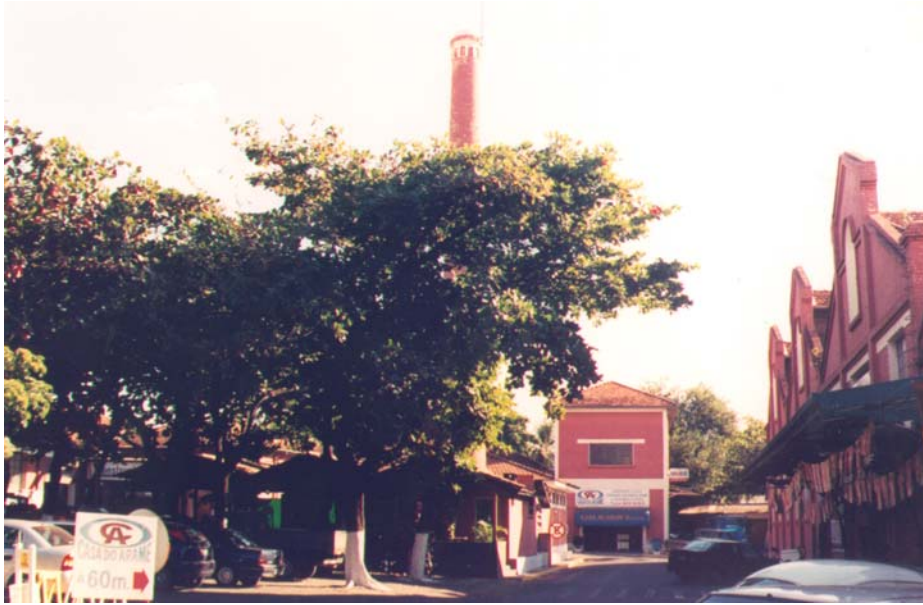
Casa das caldeiras no fundo e, à direita, o pavilhão do benefício do algodão, também transformado em comércio. Araçatuba, junho 2002. Foto do autor.
