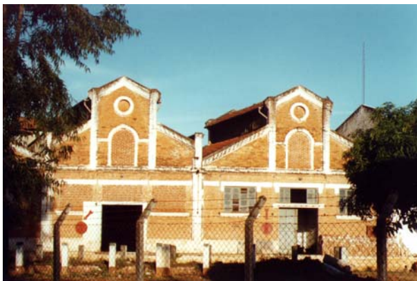
Detalhe dos dois galpões mais altos. Avaré, maio de 2002. Foto do autor.
