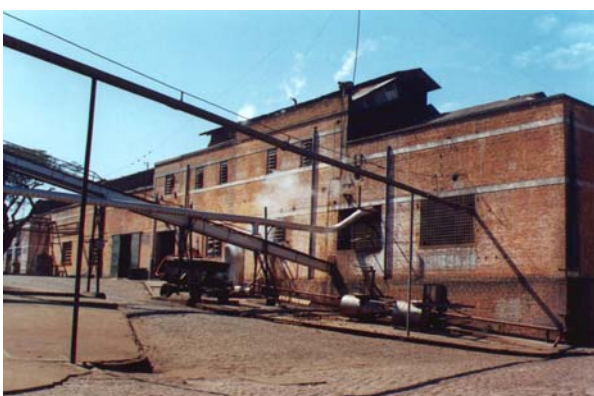
Lateral do galpão dos deslintadores. Rancharia, julho 2002. Foto do autor.
