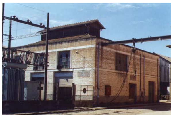
O galpão secador do amendoim. Rancharia, julho 2002. Foto do autor.
