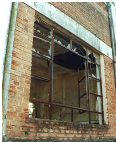
A casa das caldeiras. Marília, julho de 2002. Foto do autor.
