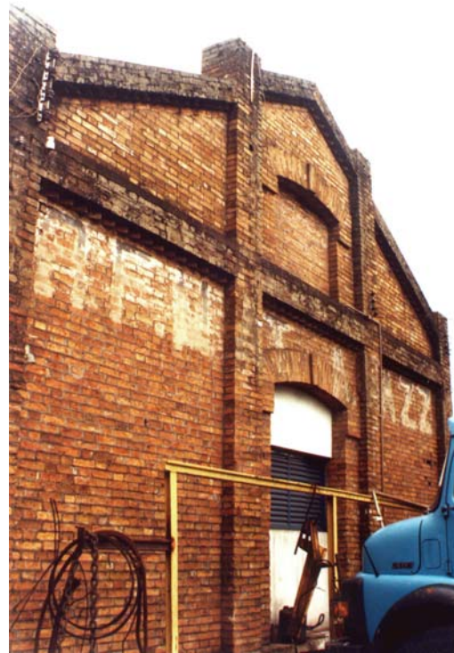
Fachada principal do armazém Matarazzo. Bauru, novembro de 2003. Foto do autor.
