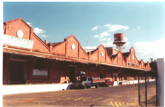
Pavilhão de beneficiamento do algodão de Araçatuba, junho de 2002. Foto do autor.
