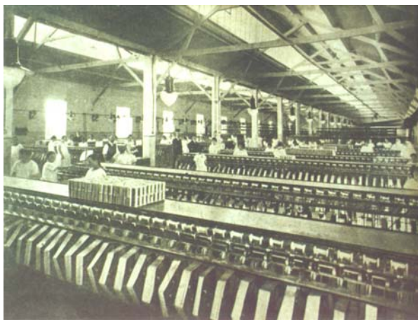
Operárias da indústria de Seda Nacional de Campinas, trabalhando na seção de torção do fio de seda. Percebe-se que esse edifício já contempla lanternins, além de possuir luz elétrica. Fonte: (GIANOLI, 1929:604).
