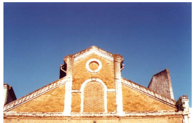
Detalhe de um dos galpões mais altos do conjunto, pela presença do óculo, acima da janela em arco pleno, totalmente vedada. Avaré, maio de 2002. Foto do autor.
