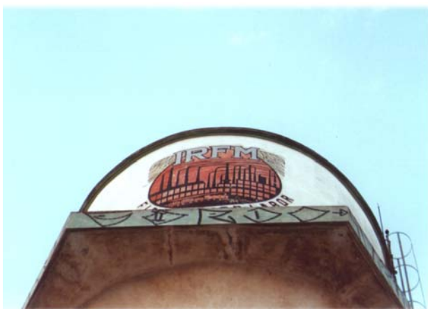
Caixa d'água da fábrica de óleo Matarazzo. Campinas, abril 2002. Foto do autor.
