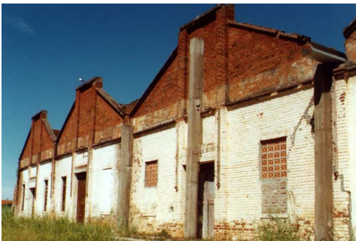
O mesmo edifício Matarazzo das fotos anteriores, visto dos fundos. Na porta do primeiro galpão, vemos, paralelas a ela, até encostar no beiral do frontão, duas tiras de madeira, onde era apoiada a cobertura existente antigamente, como está no detalhe ao lado. Bernardino de Campos, maio 2002. Foto do autor.
