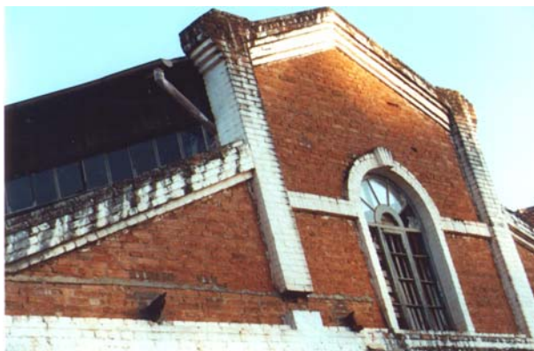
O único galpão com a janela original, em madeira. O shed (abertura para a passagem de ar e luz) do edifício ainda conserva os vidros e o madeiramento. Avaré, maio de 2002. Foto do autor.
