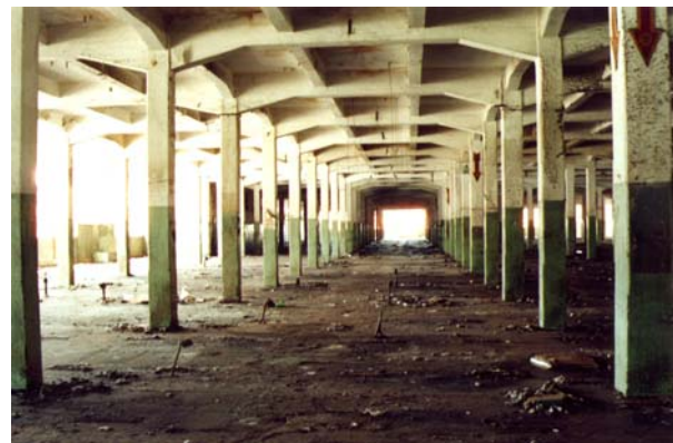
Primeiro subsolo do galpão da tecelagem, sem máquinas. Ribeirão Preto, janeiro 2000. Foto do autor.
