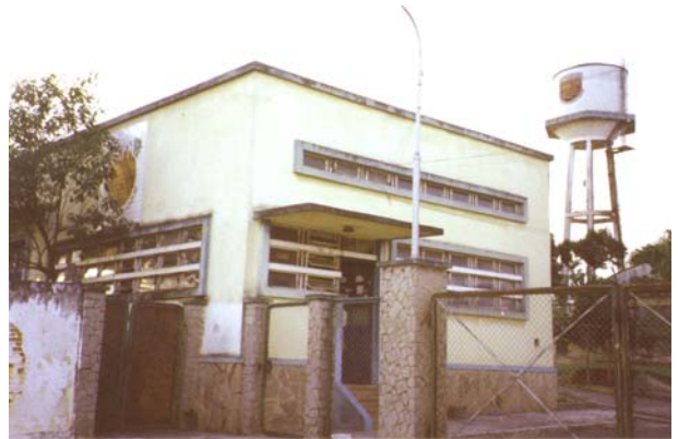
A entrada da fábrica e o refeitório e vestiário; hoje, a portaria. Campinas, abril 2002. Foto do autor.
