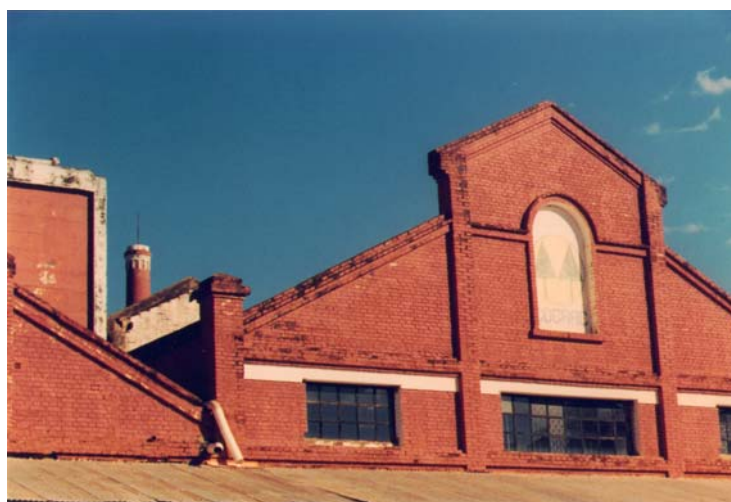
Um dos galpões da parte de trás do edifício fabril Matarazzo, com a sua janela em arco pleno vedada com alvenaria. No canto, a chaminé, construída posteriormente, na implantação da fábrica de óleo. Araçatuba, junho 2002. Foto do autor.
