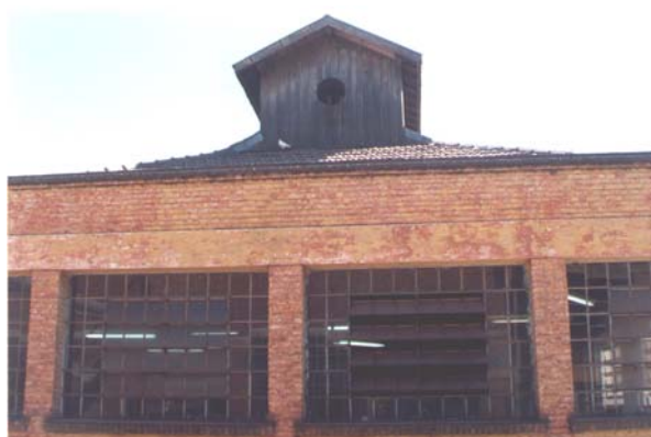
Detalhe do lanternim em madeira do galpão das oficinas, que ainda conserva as telhas originais tipo "marselha". Rancharia, julho 2002. Foto do autor.
