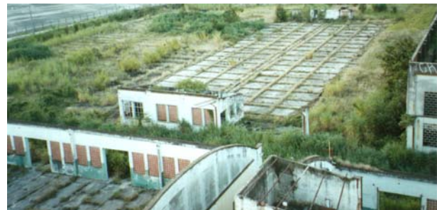
Vista aérea dos depósitos e do não mais existente silo metálico. Campinas, abril 2002. Foto do autor.
