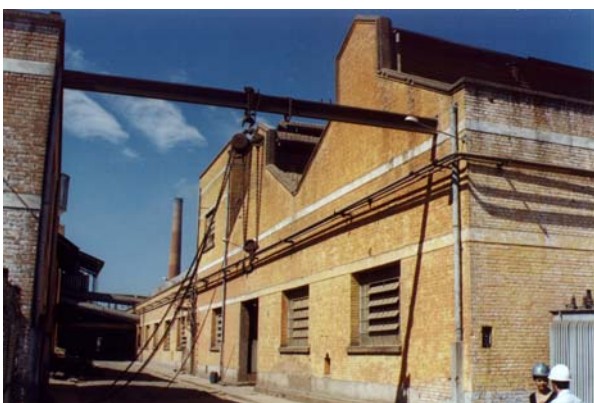
Fachada posterior do galpão dos deslintadores. Rancharia, julho 2002. Foto do autor.
