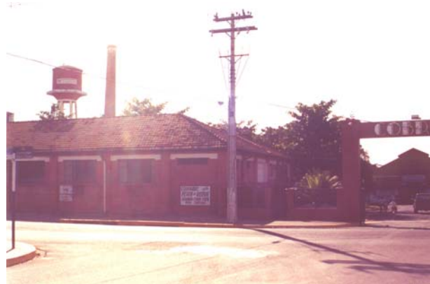
O edifício que abrigava o escritório, em alvenaria de tijolos, como os outros, que inicialmente eram aparentes. Araçatuba, junho 2002. Foto do autor.
