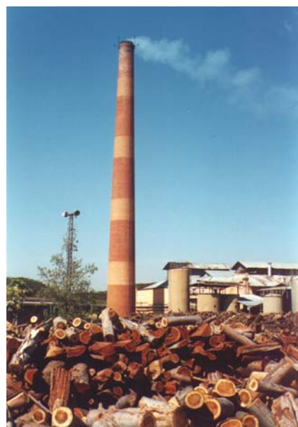
A chaminé e, ao lado, os primeiros edifícios da fábrica de óleo. Rancharia, julho 2002. Foto do autor.
