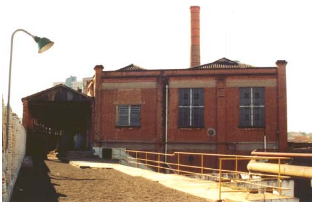
Fachada lateral do salão de linters e da saída da plataforma, Catanduva, junho 2002. Foto do autor.
