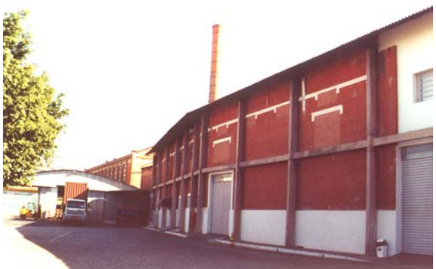
O depósito de algodão (em primeiro plano) e, nos fundos, o salão de linters. Catanduva, junho 2002. Foto do autor.
