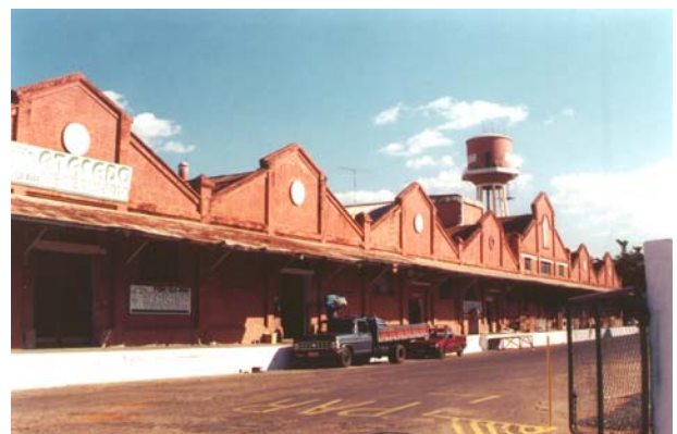
Os fundos do pavilhão de algodão, onde a fachada é diferente da frontal. O edifício é elevado em relação ao chão, servindo como plataforma. Araçatuba, junho 2002. Foto do autor
