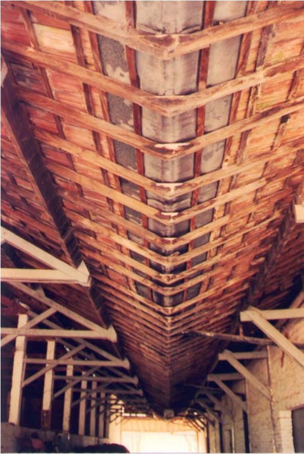
Detalhe da cobertura do silo unida com a do armazém, formando uma calha. São João da Boa Vista, maio de 2002. Foto do autor.
