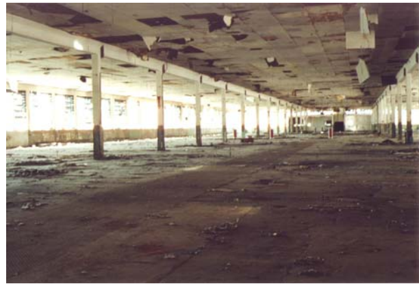
Vista do interior do pavilhão da tecelagem. Ribeirão Preto, janeiro de 2000. Foto do autor.
