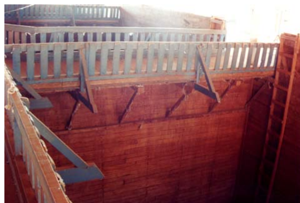
Interior da tulha, revestido de madeira. Votuporanga, julho 2002. Foto do autor.
