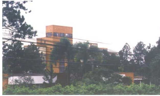
Edifício principal da Textilquímica . São José dos Campos, maio 2002. Foto do autor.
