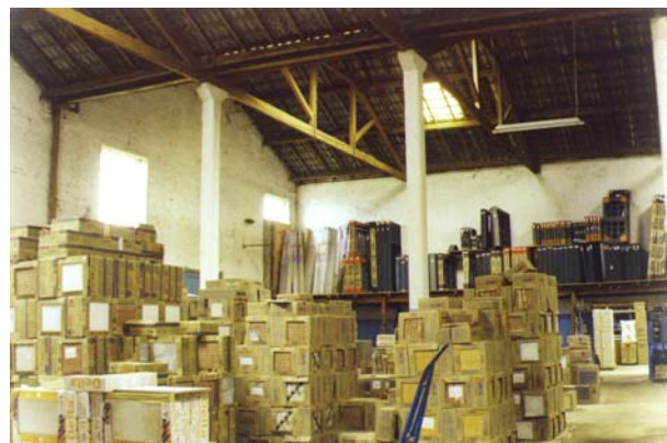
Galpão com pilares de concreto e tesouras em madeira. Itapetininga, novembro de 2003. Foto do autor.
