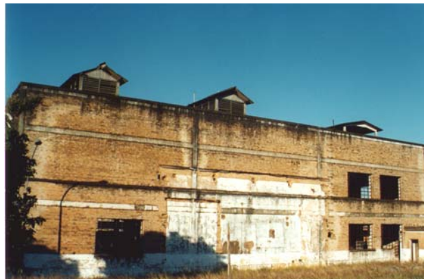
Fachada posterior da casa das caldeiras, onde aparecem os lanternins. Marília, julho 2002. Foto do autor.
