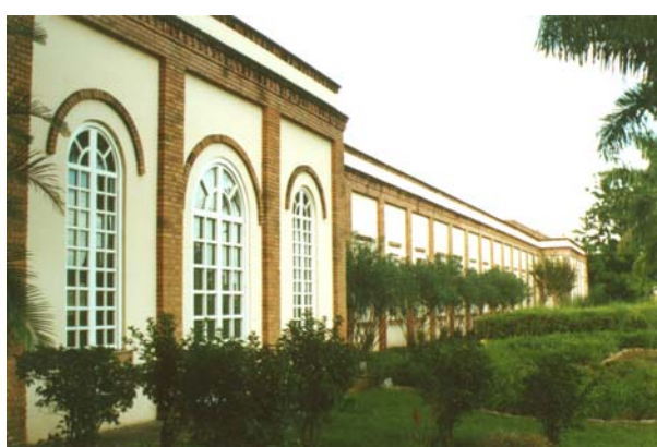
Edifício da administração da fiação e tecelagem Matarazzo. Rio Claro, abril 2002. Foto do autor.
