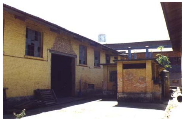
A casa da bomba d'água e de ar, entre os armazéns. Rancharia, julho 2002. Foto do autor.
