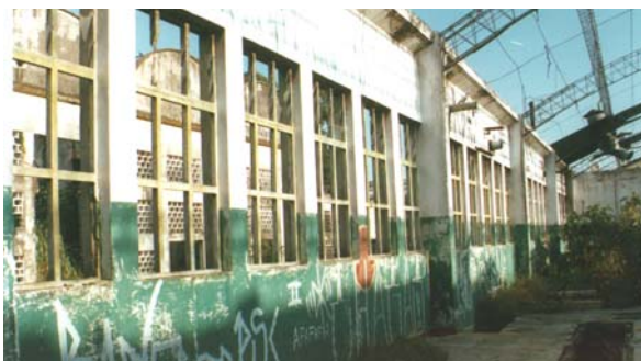
Detalhe das esquadrias pré-fabricadas em concreto. Campinas, abril 2002. Foto do autor.
