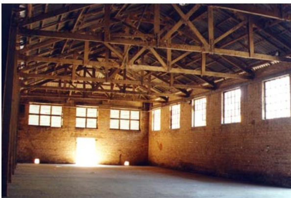
Vista interna de um armazém em alvenaria de tijolos e tesouras em madeira. Rancharia, julho 2002. Foto do autor.
