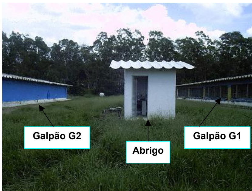
Figura 1 – Abrigo para computador e equipamentos de aquisição de dados.
