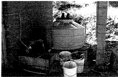
Foto 37 – Aerador feito com caixa de água
