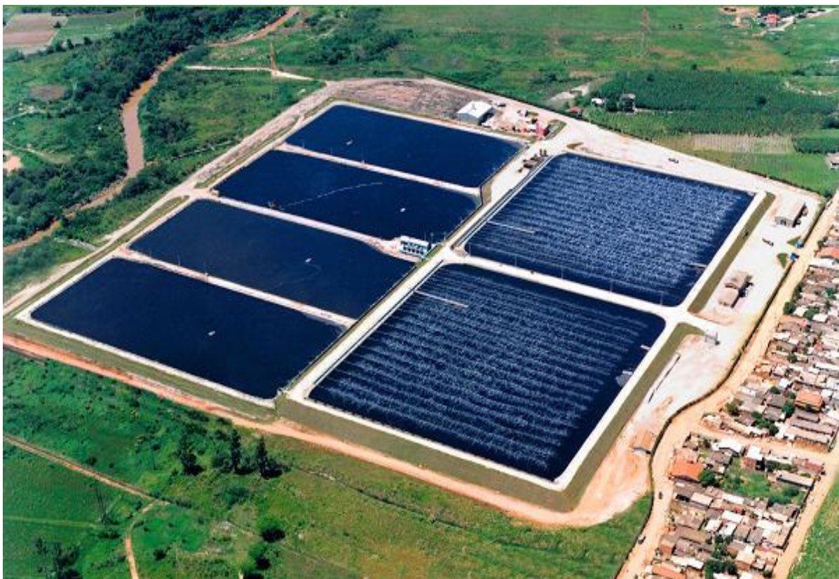
Figura 4.3 - Vista aérea da Estação de Tratamento de Esgotos Jundiaí
