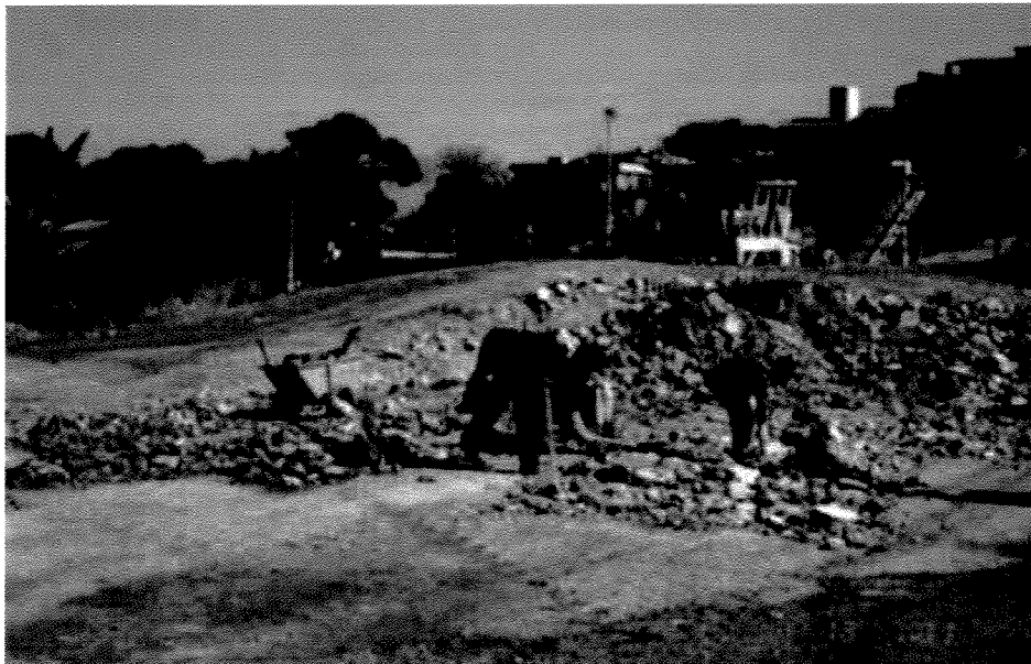
Foto 2.16 - Separação dos materiais que irão para o aterro sanitário (2ª etapa)
