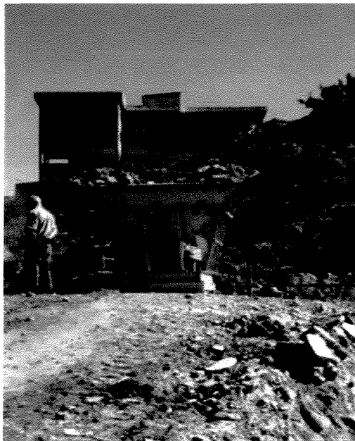
Foto 2.18 - Moagem do entulho
