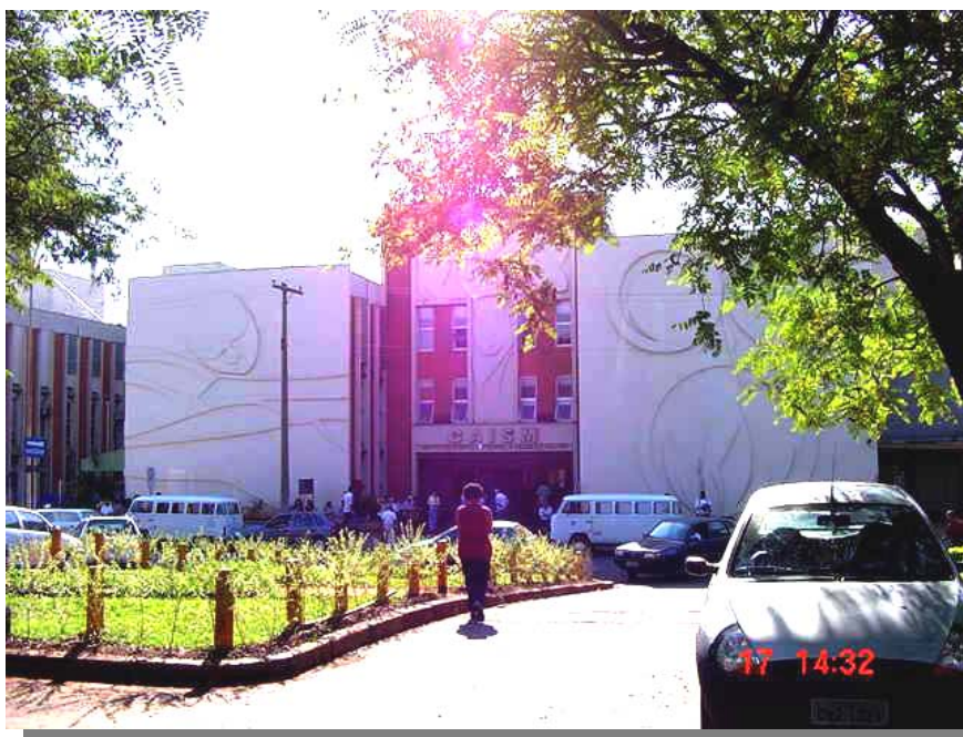
Fachada principal do CAIS/AIG/Unicamp
