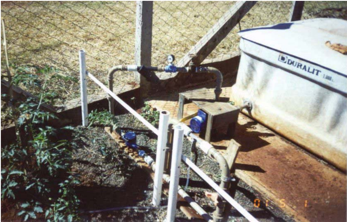
FIGURA 7: Cabeçal de controle do sistema de irrigação.
