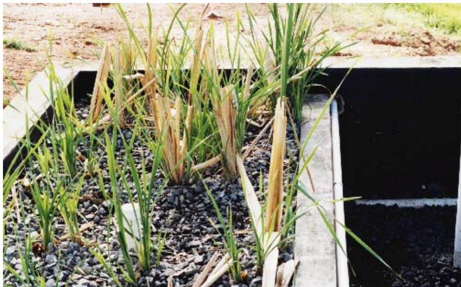
Figura 5. Ilustra as mudas de taboa do primeiro leito de macrófitas e a instalação do segundo leito.
