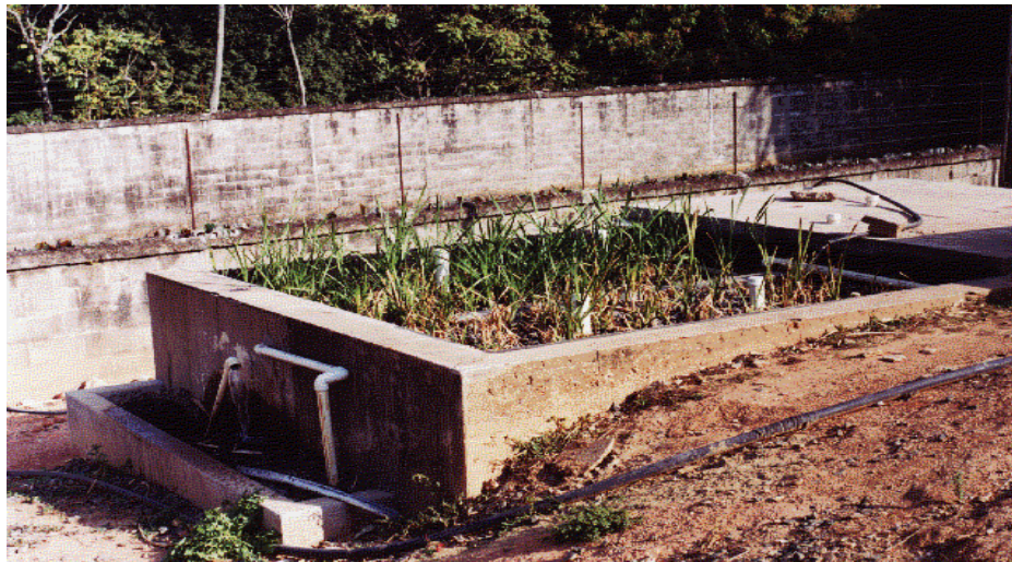
Figura 7. Ilustra os leitos e o reator anaeróbio compartimentado, tubulação de escoamento em forma de “cachimbo” para o escoamento do líquido após tratamento.
