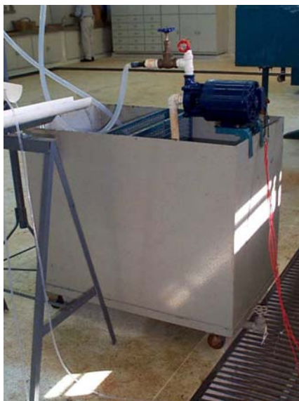
Figura 11. Moto bomba e reservatório de abastecimento.
