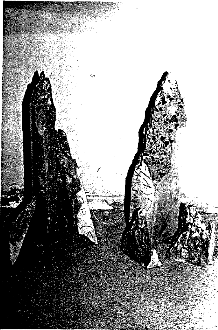
Fig. 11 - Pilares P1SA-CAR e P2SA-CAR rompidos.
