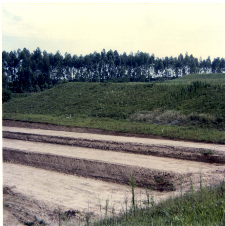
Figura 8. Vista geral das rampas já construídas, verificando-se a diferença de cota existente entre elas
