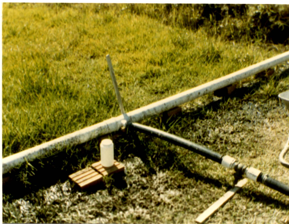
Figuras 13. Tubulação de distribuição sobre tijolos.
