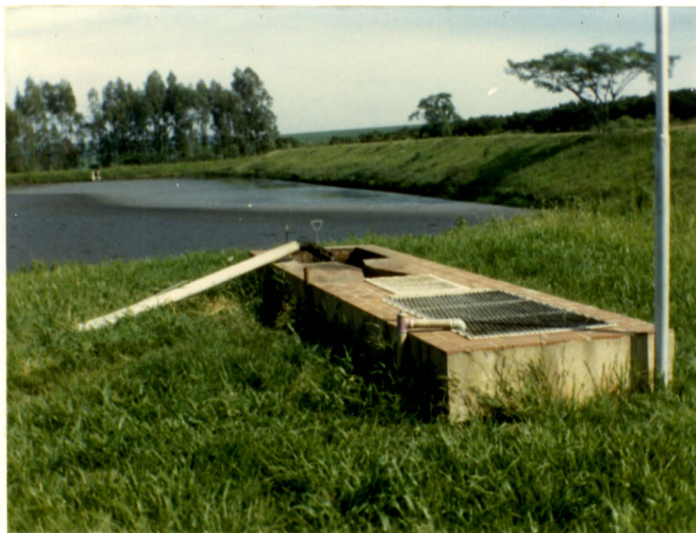
Figura 10. Sifão de coleta de efluente bruto, tendo-se ao fundo a primeira lagoa anaeróbia
