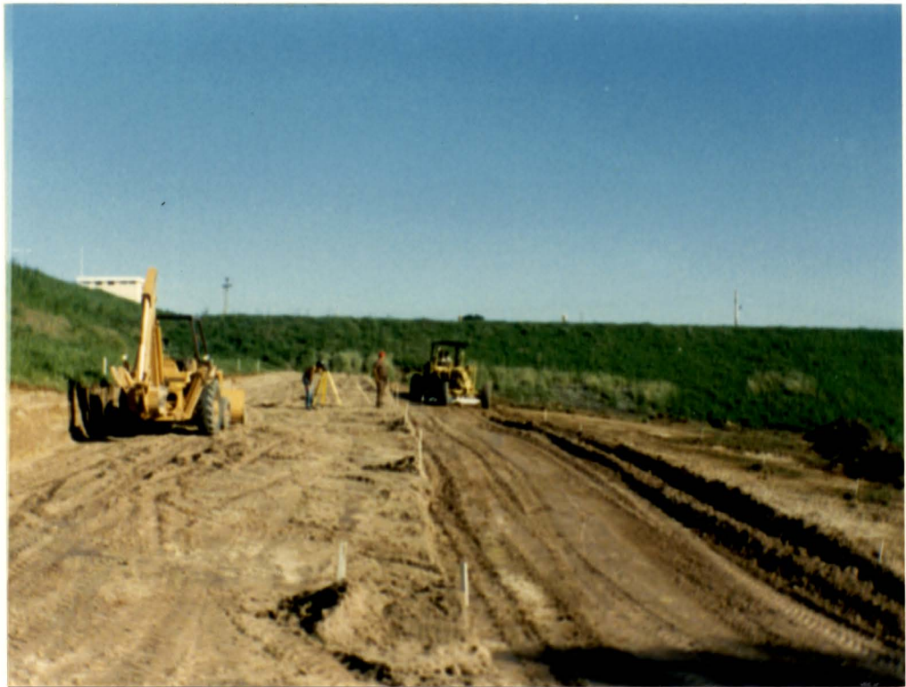
Figura 6. Construção da rampa 2, tendo-se ao fundo o talude das lagoas aeradas.
