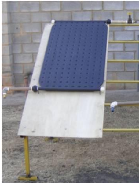
FIGURA 1. Fixação do coletor solar na estrutura metálica. Attaching the solar collector on the metallic structure.
