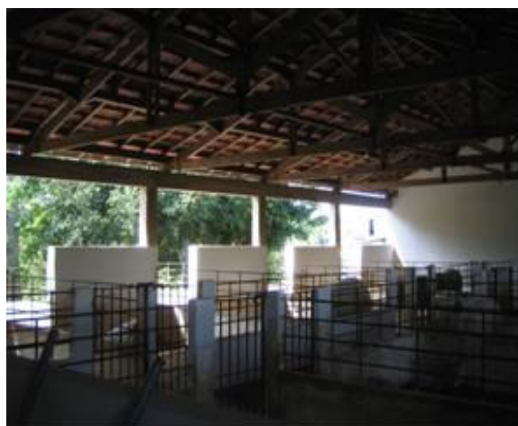
FIGURA 1. Vista interna da instalação de cachaço estudada. Internal view of the studied boar housing.
