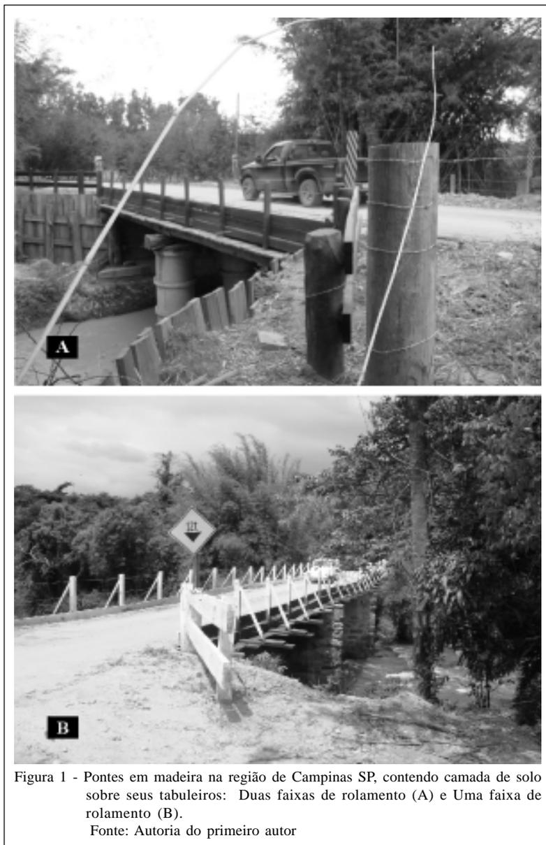
Figura 1 - Pontes em madeira na região de Campinas SP, contendo camada de solo sobre seus tabuleiros: Duas faixas de rolamento (A) e Uma faixa de rolamento (B).
