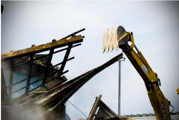
Foto 01: Cena do início da demolição.
