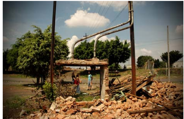
Foto 04: Cena da demolição presenciada pelos alunos.
