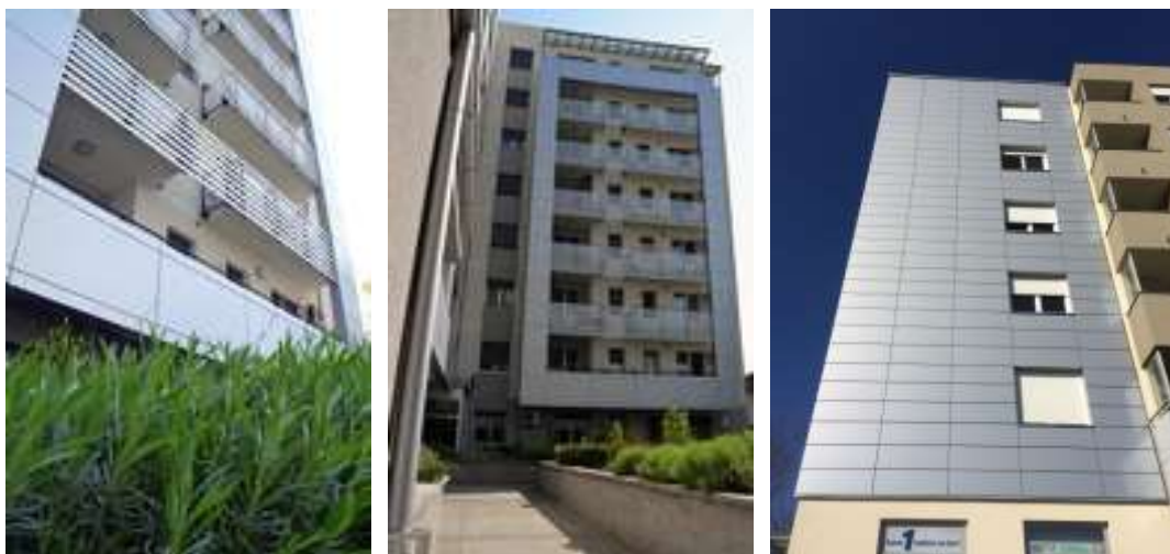
Сл. 5.45 – Примена алуминијума на фасадама у улици Боре Марковића и улици Браће Радовановића. Извор: фотографије аутора
