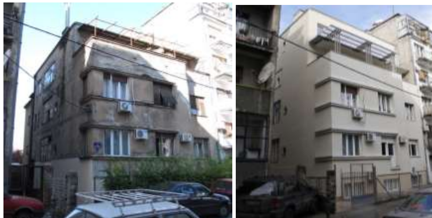
Сл. 4.64 – Надградња стамбеног објекта у ул.Чеде Мијатовића бр.1 Извор: фотографије аутора
