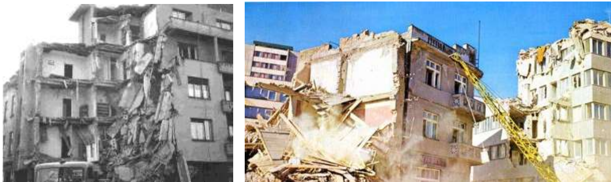
Сл. 3.2 – Оштећења зграда услед дејства земљотреса Извор: б)
