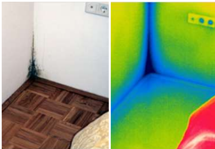
Сл. 5.6 – Термографски снимак зида где је велика разлика у површинским температурама споља и унутра изазвала интензиван развој буђи. Извор: https://www.kaliner.si/pleskanje/zidna-plesen-v-stanovanju
