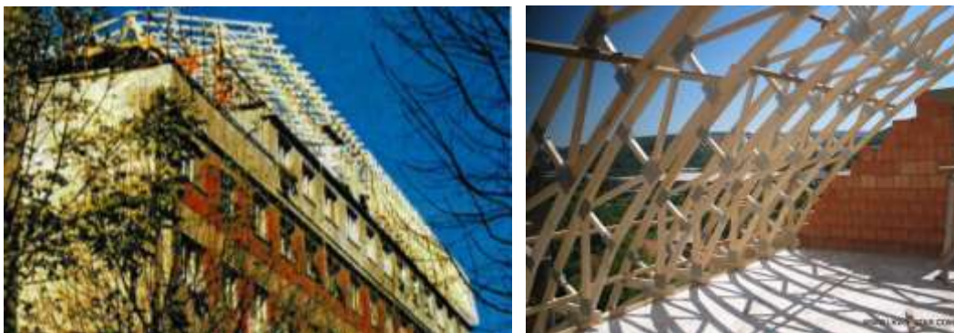
Сл. 4.52 – Примена ЛКВ носача при извођењу кровне конструкције.
