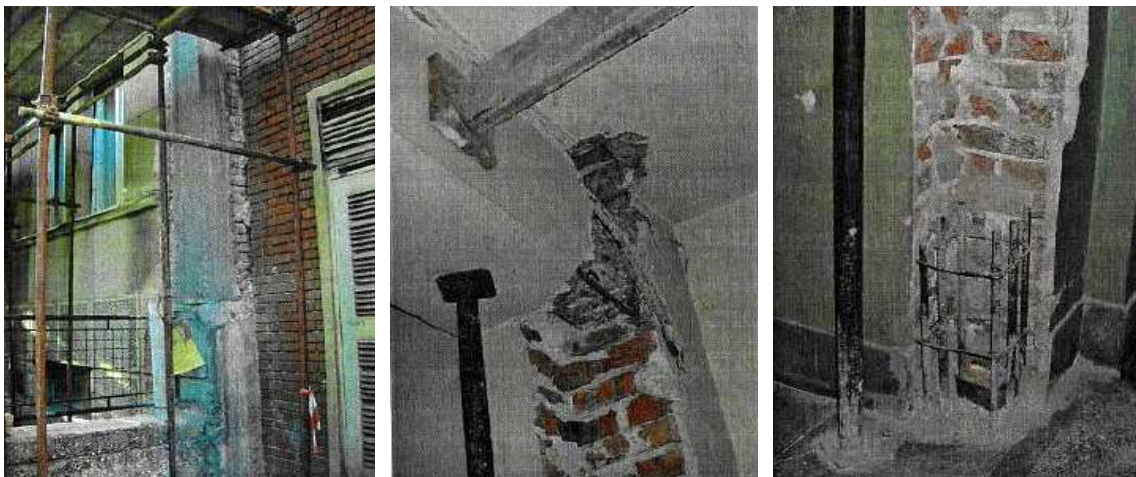
Сл. 4.21 – Накнадно извођење вертикалних серклажа на зградама са постојећим хоризонталним серклажима. Извор:
