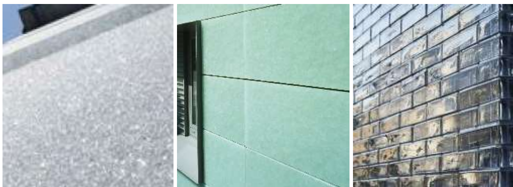
Сл. 5.41 – Текстура, боја и транспарентност рециклираног стакла.
