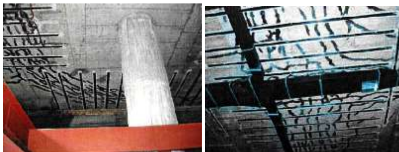
Сл. 4.37 – Ојачање међуспратних конструкција карбонским ламинатима. Извор: http://www.gradjevinarstvo.rs
