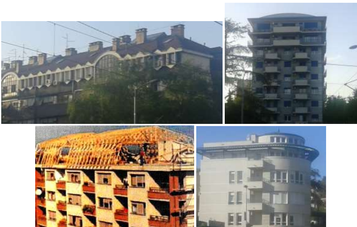
Сл. 4.60 – Примери надградње равног крова у Пожешкој, Устаничкој и улици Благоја Паровића. Извор: фотографије аутора
