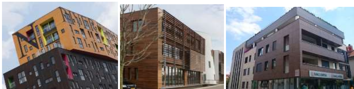
Сл. 5.32 – Примена дрвених – Треспа панела код стамбених објеката.
