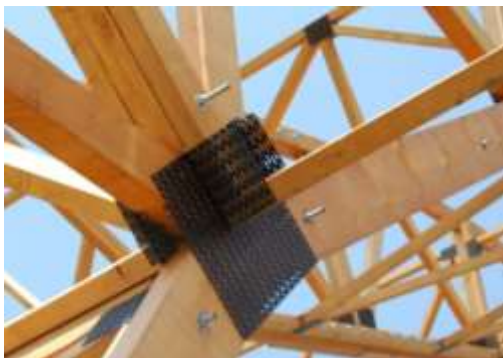
Сл. 4.49 – Детаљи чворних веза изведени металним конектерима. Извор: http://lkvcentar.com
