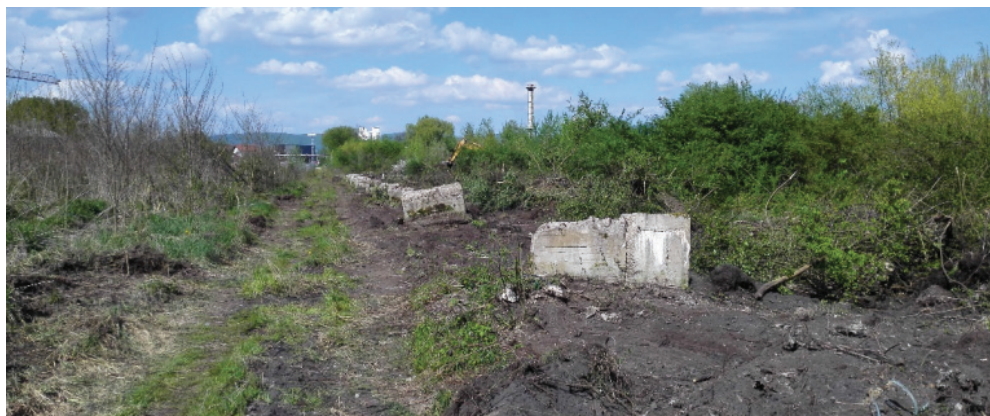
Slika 13 – Izgled parcele pre početka izvođenja radova
