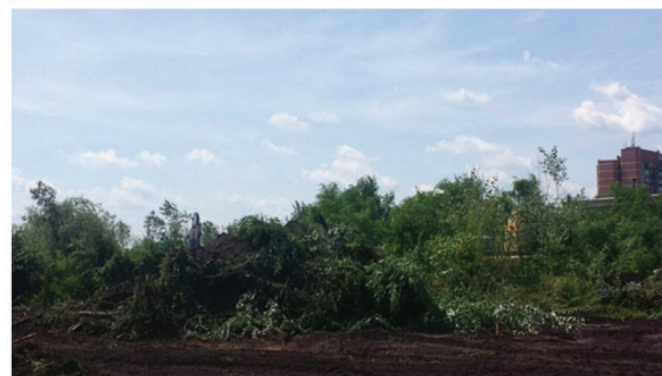
Slika 24 – Početak radova, jul 2015.
