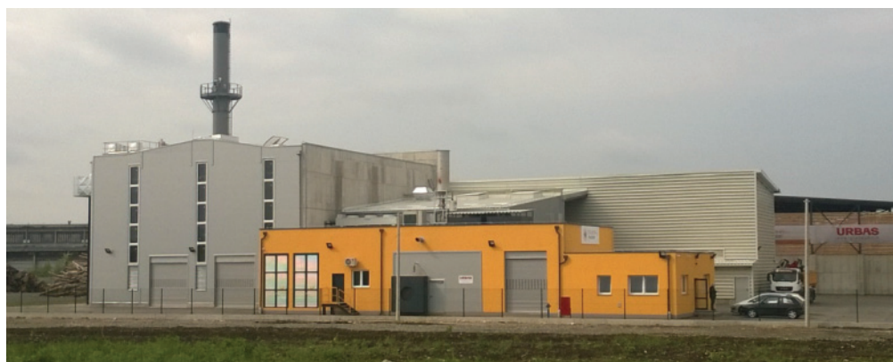
Slika 14 – Izgled parcele i gotovog objekta nakon završetka svih radova
