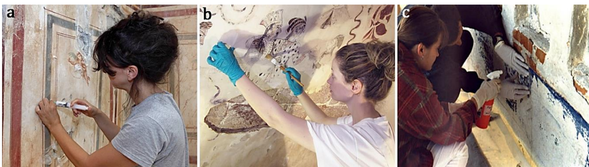
Slika 12. Tehnike nanošenja biocida tokom konzervatorskih tretmana zidnih slika i malterne podloge: a. ubrizgavanje; b. premazivanje; c. prskanje
