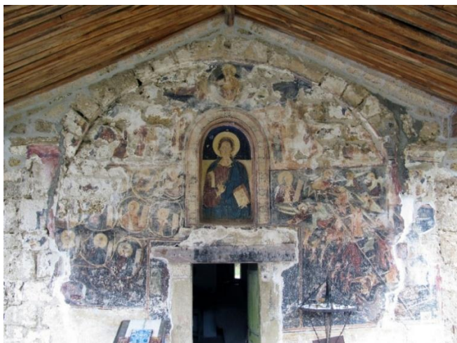
Slika 38. Narušeno stanje zidnih slika zapadne fasade egzonarteksa
