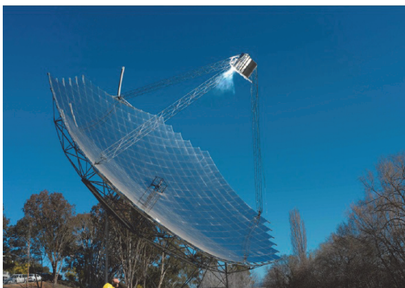
Слика 2.23. SG4” прототип површине 500\text{m}^2 Соларни параболични концентришући пријемник - лево и соларни цевни апсорбер у кавитету- десно [19]
