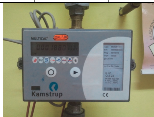
Слика 7.10. ТА-STAD мерни балансни вентил Tour & Andersson и калориметар Kamstrup Multical 66CDE
