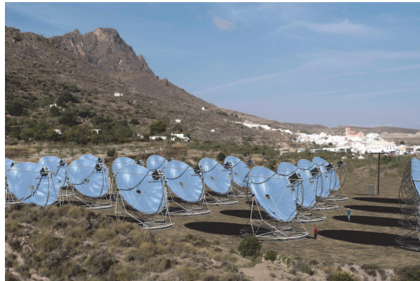
Слика 2.13. Соларни парк састављен од соларних концентратора EURODISH- Немачка
