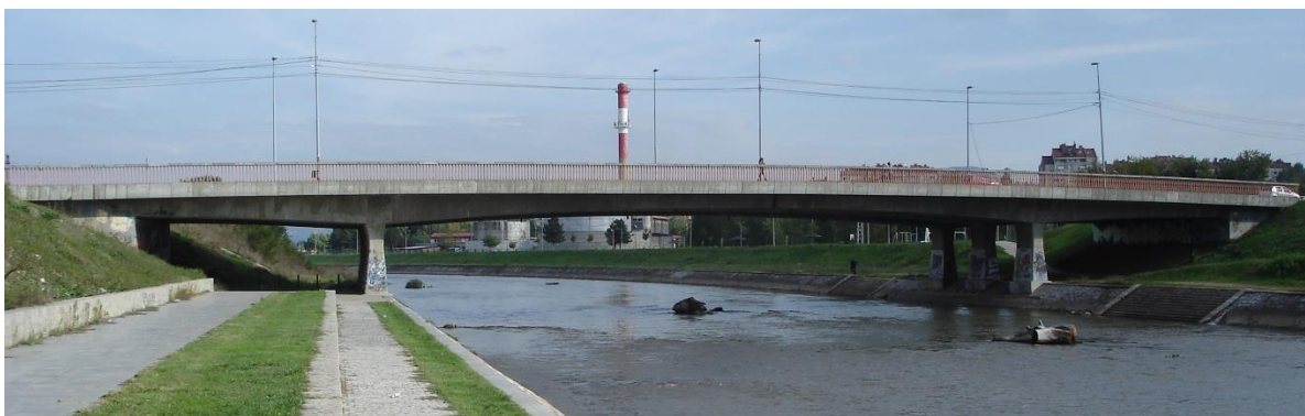
Slika A.4. Izgled mosta
