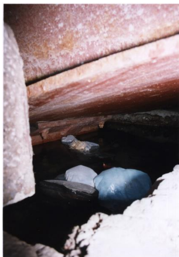
Slika A.2.1. Nepokretno ležište
