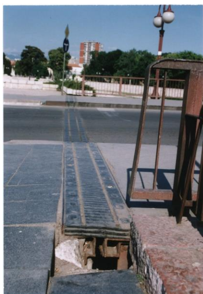
Slika A.2.5. Dilatacione sprave
