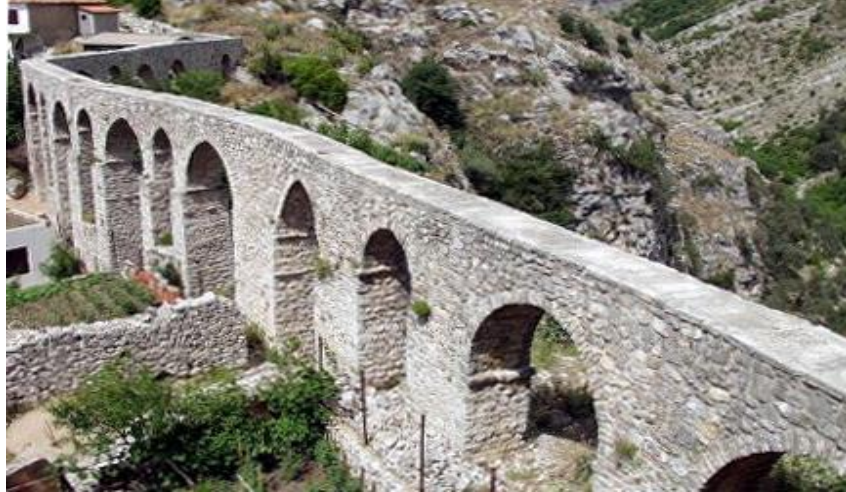
Slika 25. Akvadukt starog grada Bara
