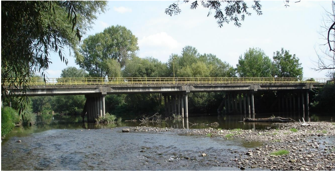
Slika A.7. Izgled mosta
