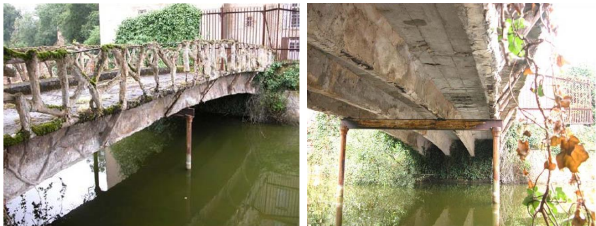
Slika 17. Armiranobetonski most u parku zamka Chazelet
