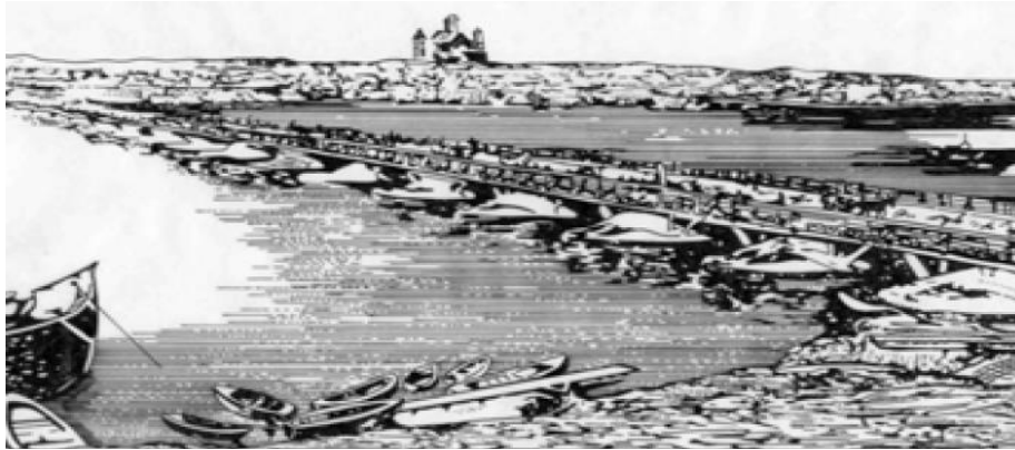
Slika 4. Graditelj Herpal koristio je više od 300 lađa povezanih drvenim mostom
