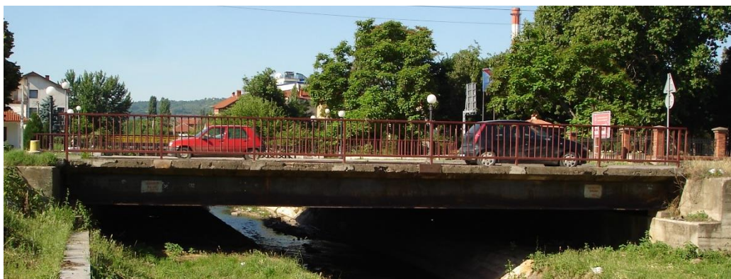
Slika A.8. Izgled mosta
