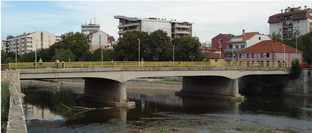
Slika A.1. Izgled mosta
