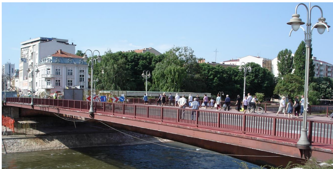
Slika A.2. Izgled mosta
