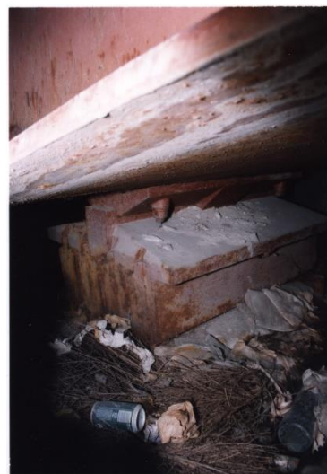
Slika A.2.2. Pokretno ležište
