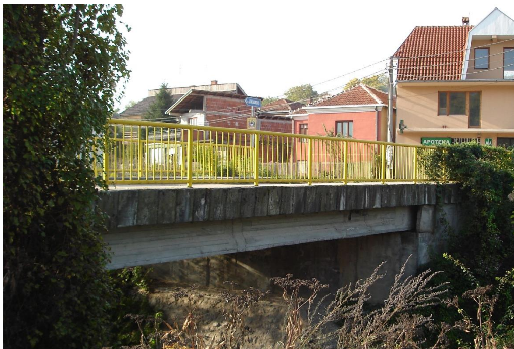
Slika A.15. Izgled mosta
