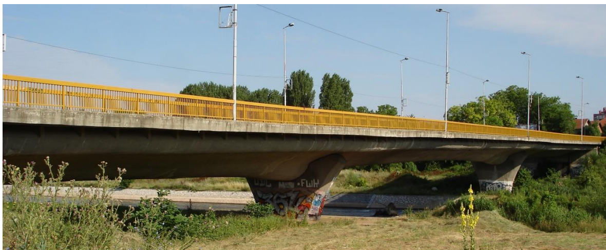
Slika A.5. Izgled mosta
