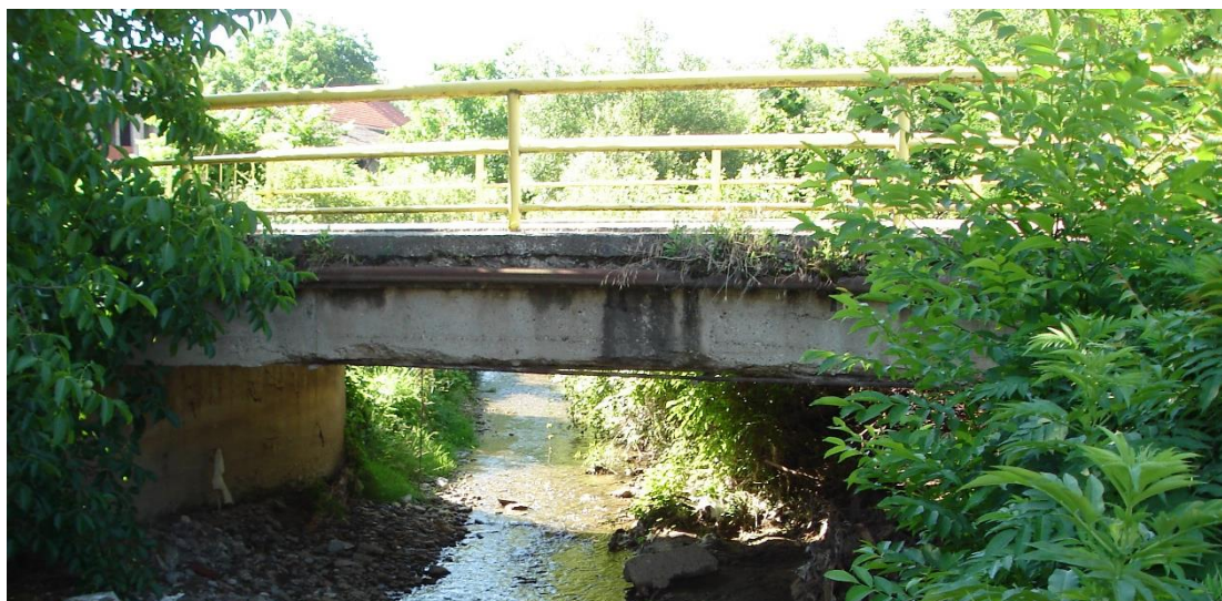
Slika A.14. Izgled mosta
