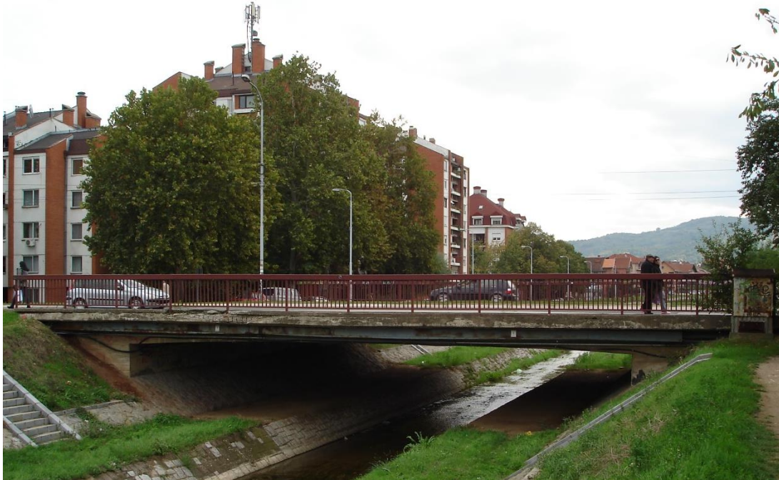
Slika A.10. Izgled mosta
