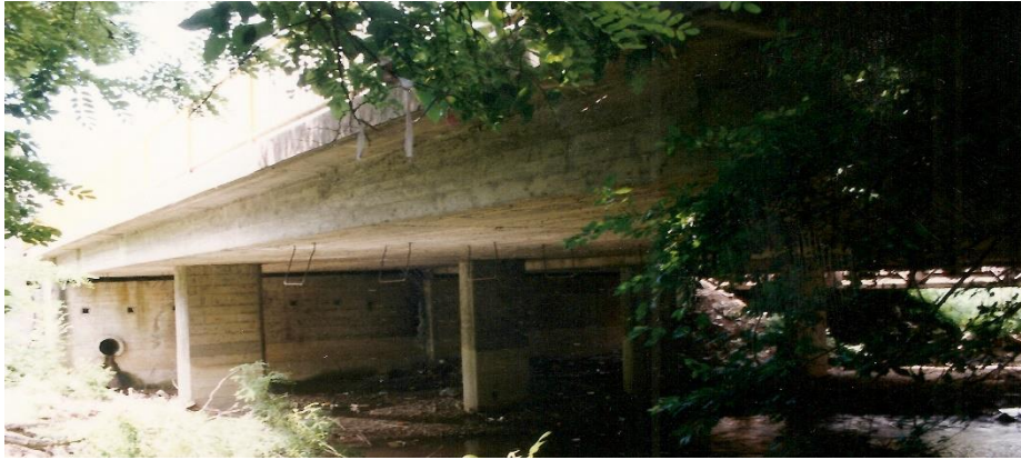
Slika A.11. Izgled mosta
