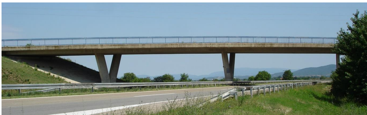
Slika A.2. Izgled mosta
