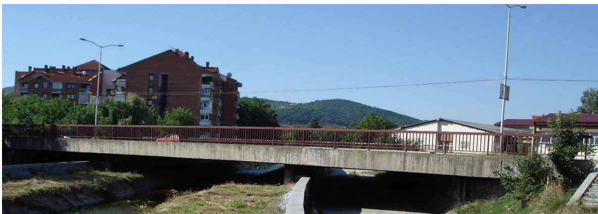
Slika A.9. Izgled mosta
