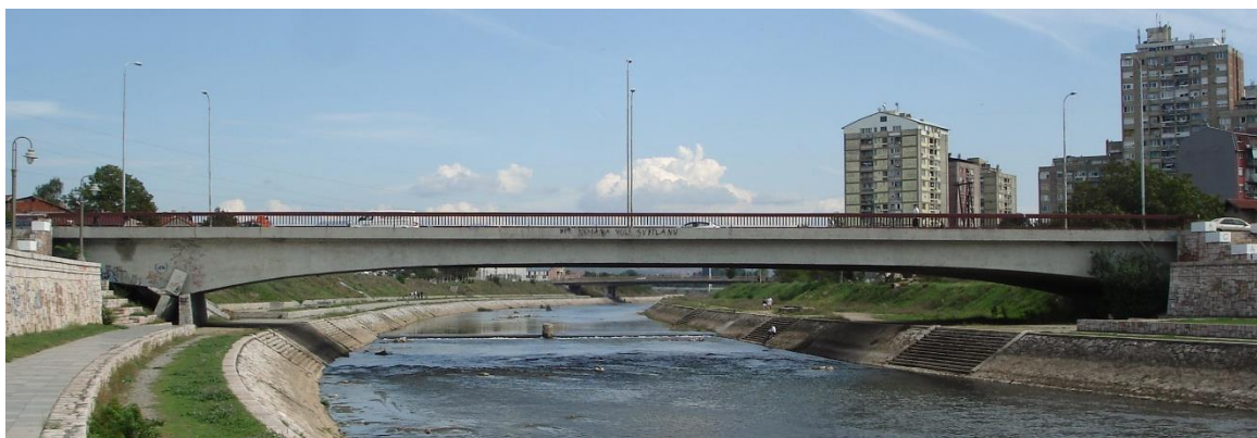
Slika A.3. Izgled mosta
