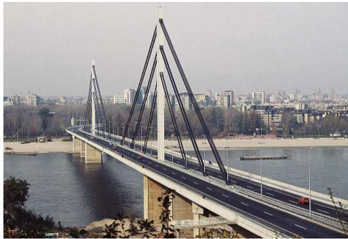
Slika 30. Most Slobode u Novom Sadu
