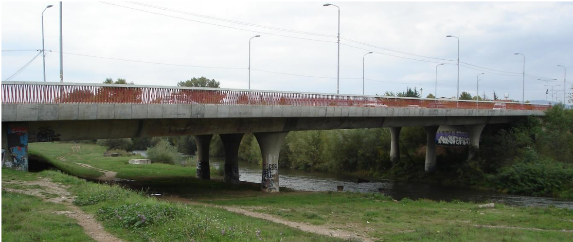
Slika A.6. Izgled mosta
