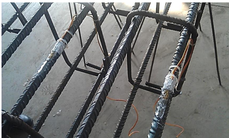
Слика 4.12 – Заштита мерних трака од физичких оштећења током бетонирања
