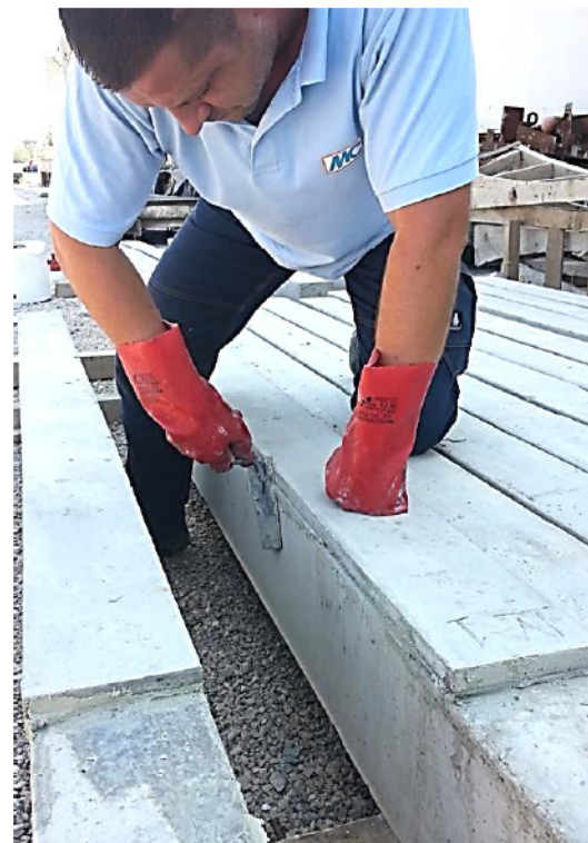
Слика 4.79 – Одстрањивање вишка епокси-малтера у спојници
