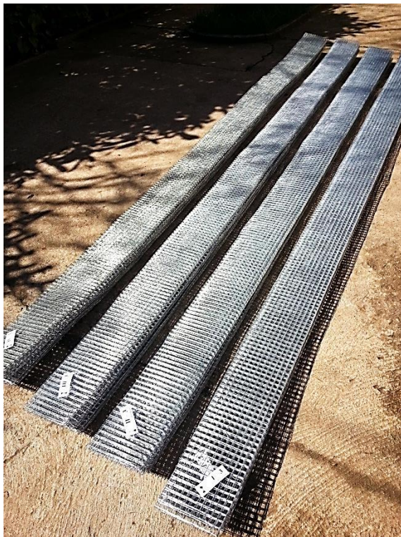
Слика 4.23 – Припрема микроарматуре
