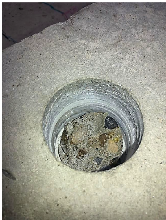
Слика 4.71 – Изглед ојачаног носача на месту чупања узорка
