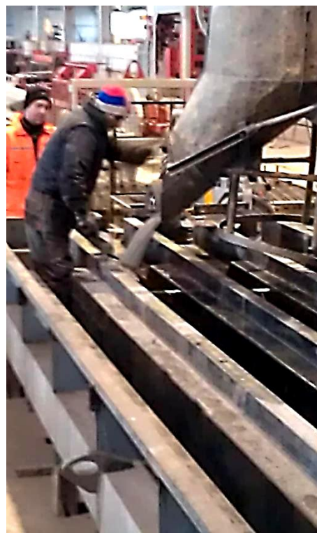
Слика 4.18 – Процес уградње бетона
