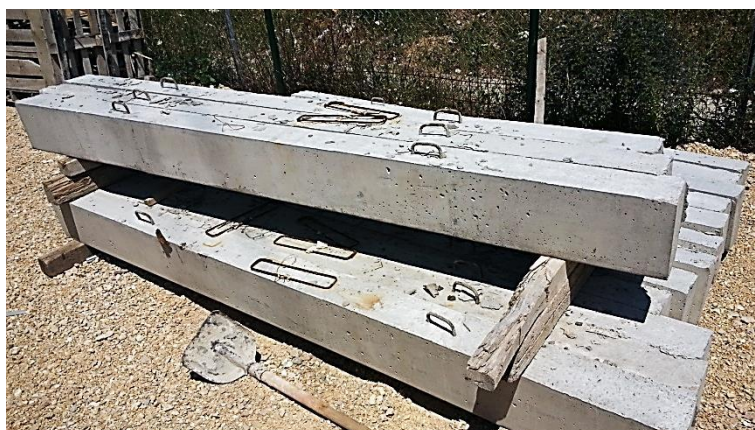
Слика 4.22 – Коначни изглед греда ван оплате
