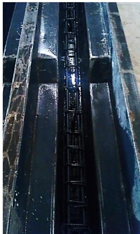
Слика 4.14 – Постављање арматуре у оплату пред уградњу бетона
