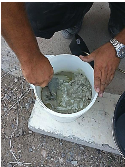
Слика 4.74 – Справљање епокси-малтера
