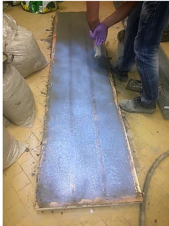
Слика 4.34 – Заштита горње површине фероцемента у оплати од испаривања
