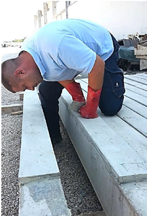
Слика 4.78 – Спајање АБ носача и фeroцементне траке
