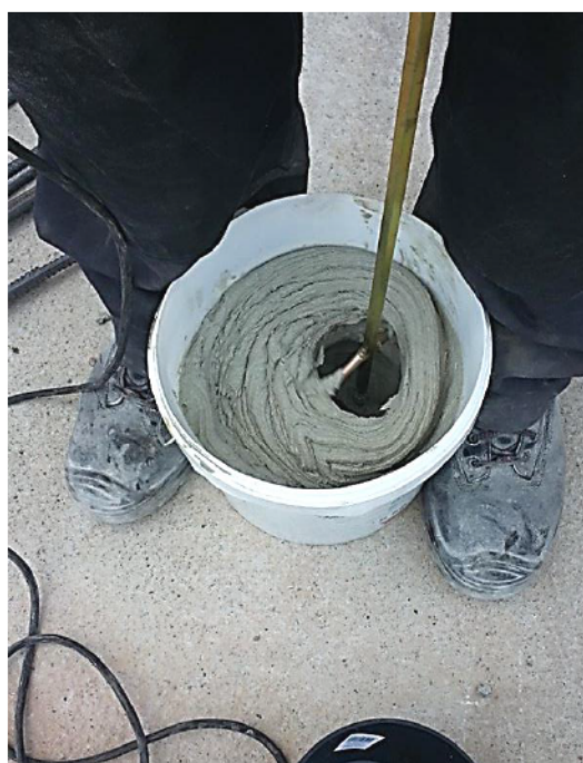
Слика 4.75 – Справљање епокси-малтера
