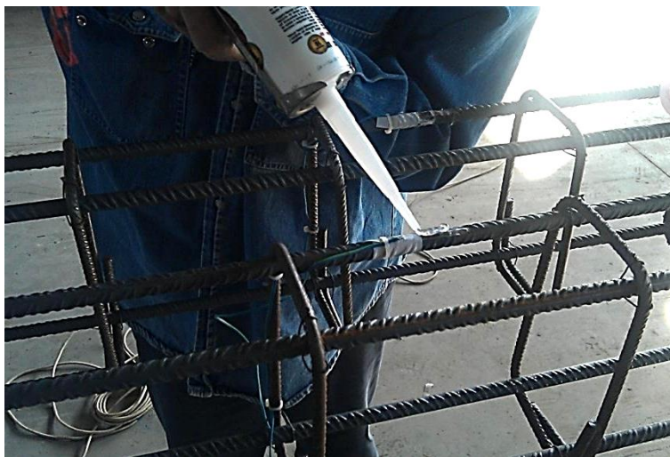
Слика 4.87 – Заштита мерних трака и извода за каблове на конвенционалној арматури од евентуалних оштећења у току бетонирања носача
