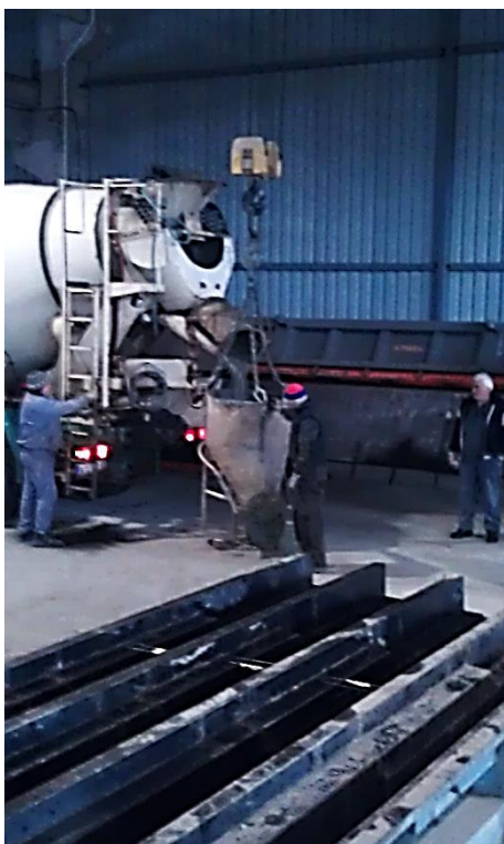
Слика 4.17 – Процес уградње бетона
