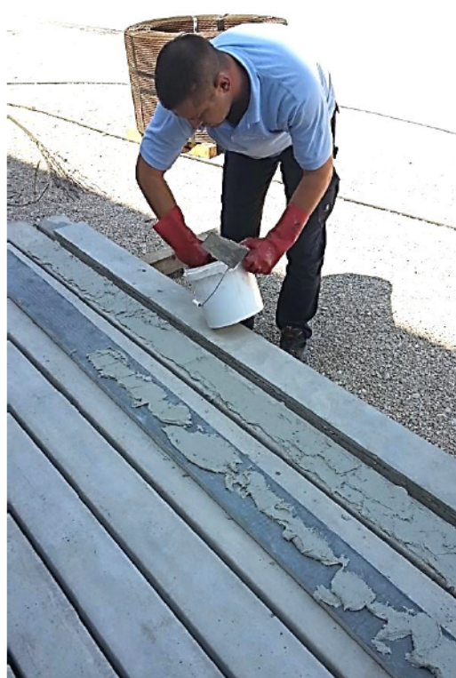
Слика 4.77 – Наношење епокси-малтера на фeroцементну траку
