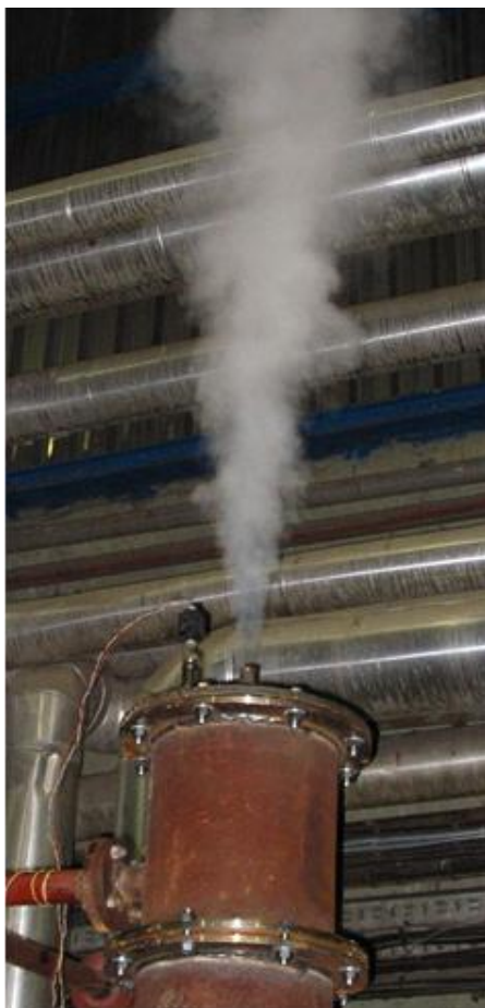
Слика 4.4 Дегазациона колоне при нестабилном раду
