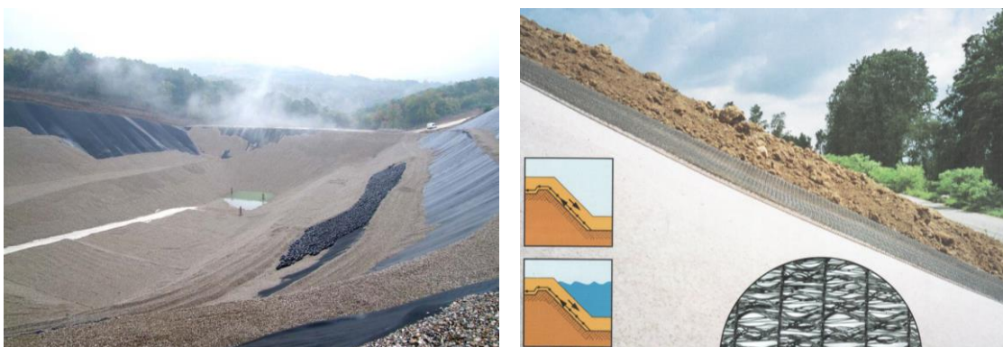
Slika 4.1 Deponija „Gigoš“ u fazi izgradnje (levo); Primena geomreže „Fortrac 3D“ (desno)
