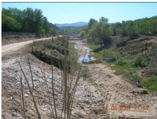
Slika 7.1. Biološki regulacioni radovi - traverze od pletera
