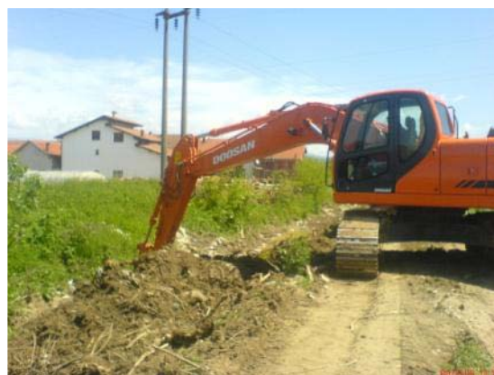
Slika 7.7. Čišćenje rečnog korita od rastinja
