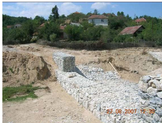
Slika 7.2. Izgradnja pregrade od gabiona
