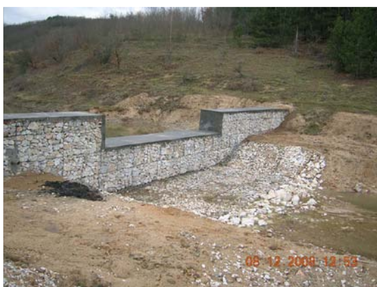
Slika 7.3. Pregrada od gabiona
