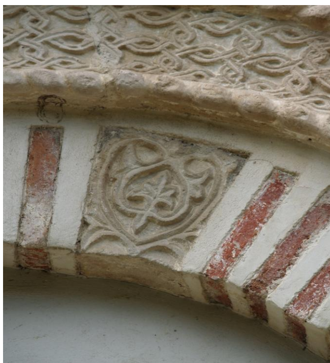
/33, 33а/ Изглед западног портала и детаљ архиволте, Велуће, фото: Ј. С. Тирић
