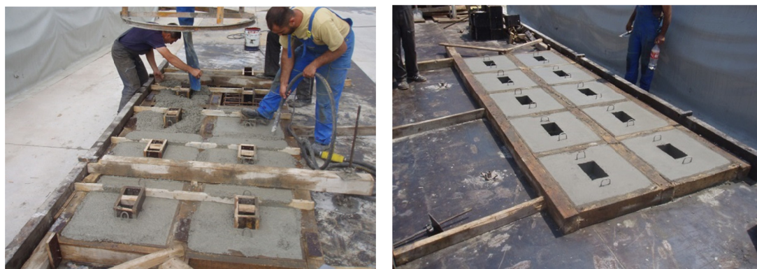
Slika 2.7: Montažne ploče tokom i neposredno nakon betoniranja
