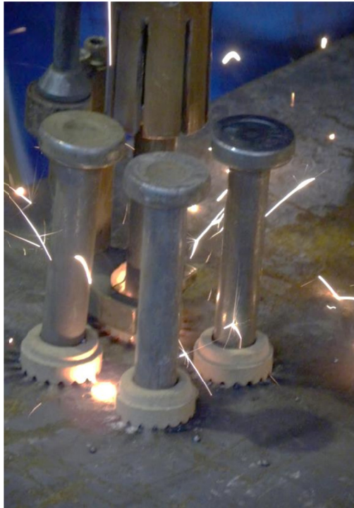
Slika 2.2: Elektrolučno zavarivanje moždanika
