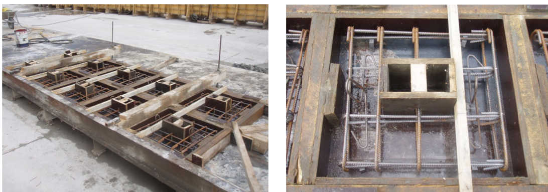
Slika 2.6: Priprema za betoniranje, detalj armature u montažnoj AB ploči
