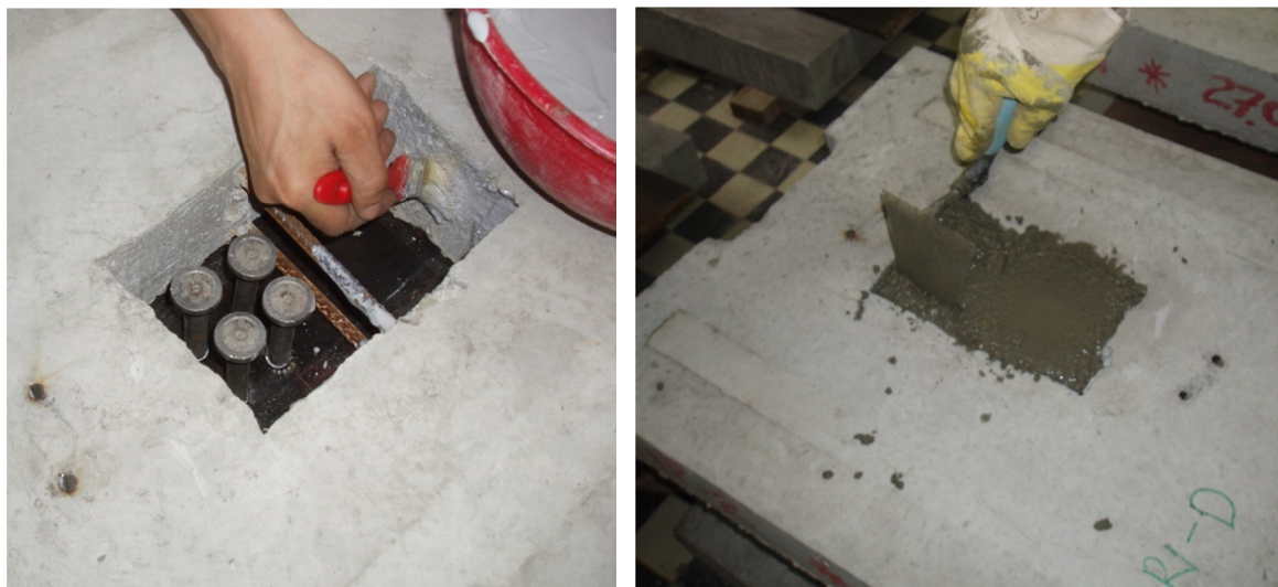
Slika 2.21: Nanošenje premaza za kontakt starog i novog betona, betoniranje uzorka
