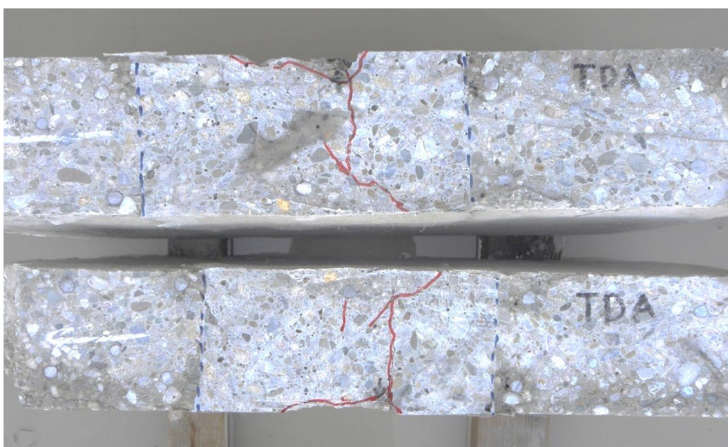
Slika 8.2: Poprečni presek armiranobetonske ploče uzorka TDA nakon ispitivanja
