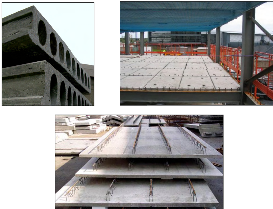
Slika 1.2: Prefabrikovani armiranobetonski elementi za montažne spregnute grede, slike preuzete iz [48]
