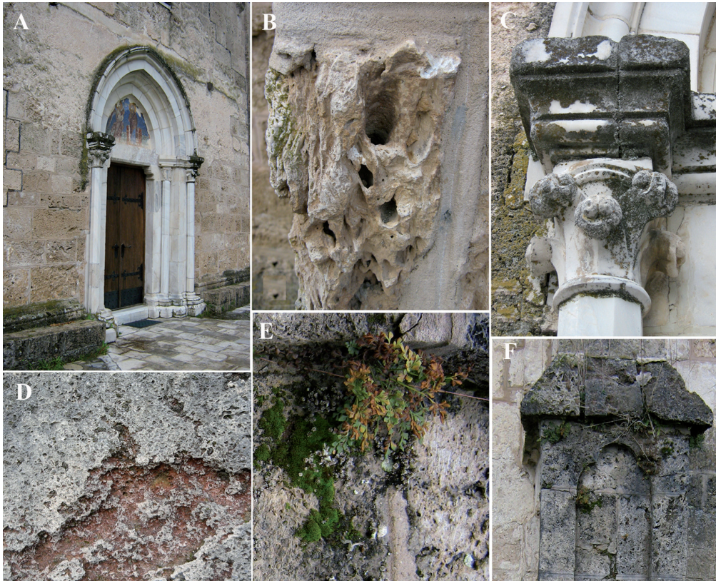
Slika 24. Simptomi biodeterioracije fasade Crkve Svete Bogorodice manastira Gradac: A. biopatina na fasadi i ulaznim vratima crkve; B. promene u teksturi i pukotine na fasadi; C. crna biopatina na mermernom stubu; D. crveno obojena biopatina na oštećenoj površini maltera; E. mahovine i paprati na oštećenoj površini kamena; F. biljke cvetnice u pukotinama devastiranog stuba
