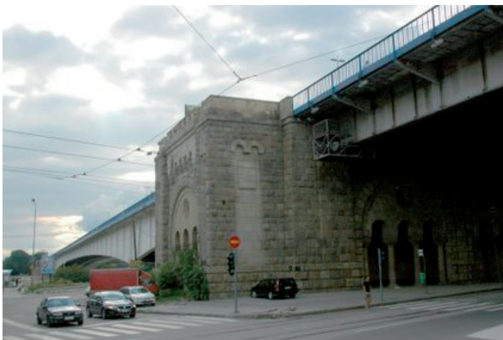
Slika 17. Centralni stub Brankovog mosta – starobeogradska strana
