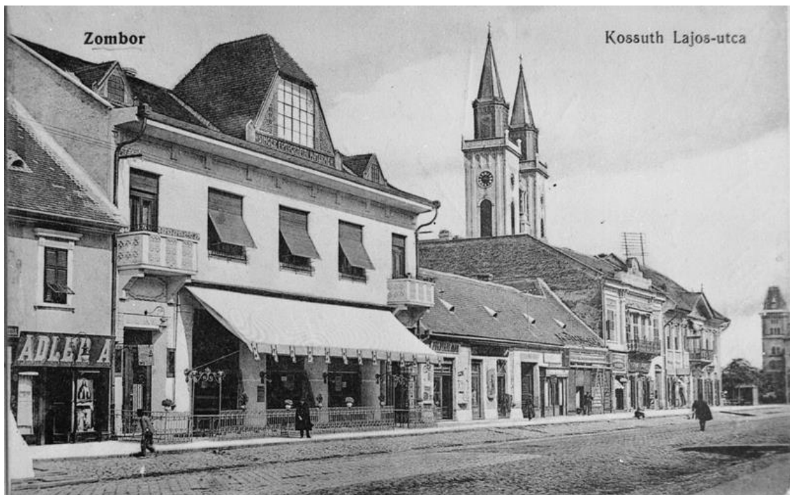
Слика 43. На разгледници се види положај Сингерове палате (у првом плану лево) на главној улици у Сомбору. У позадини се виде торњеви кармелићанске цркве, а сасвим десно зграда Бачко-бодрошке жупаније (Извор: Документација Покрајинског завода за заштиту споменика културе, Петроварадин)
