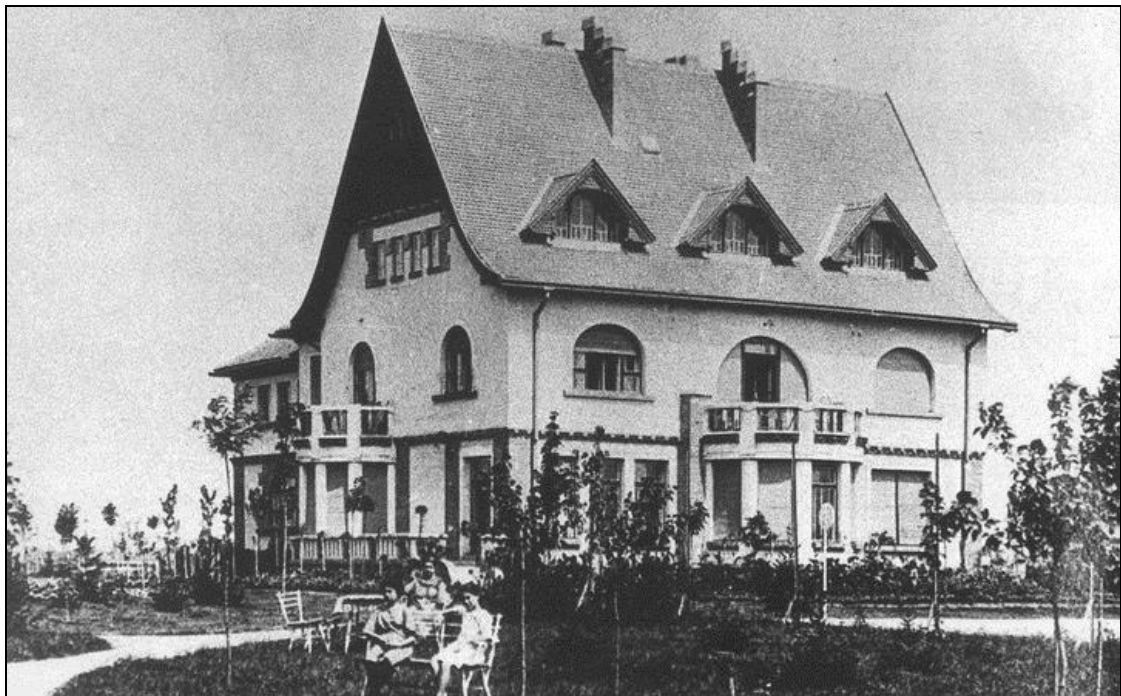
Слика 85. Елекова вила, Зрењанин, 1911, Виктор Бенеш, снимљено након завршетка градње (Извор: Документација Завода за заштиту споменика културе Зрењанин, Фотодокументација)
