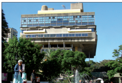
Edificio de la Biblioteca Nacional Argentina, Buenos Aires
