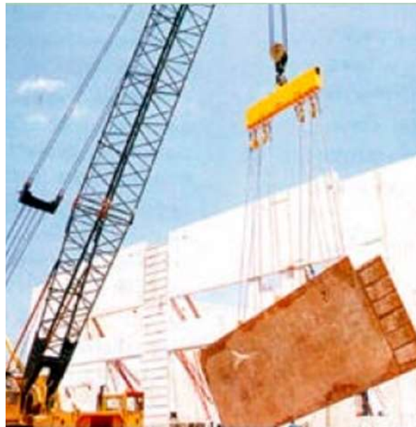
Fig. 1.72- Tecnologia tilt up Fonte: ASSOCIAÇÃO BRASILEIRA DAS EMPRESAS DE SERVIÇOS DE CONCRETAGEM (ABESC, 2005)
