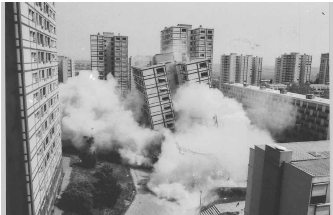
Fig. 1.17 – Demolição de um edifício no Minguettes em Lyon Fonte: LYON (1983)
