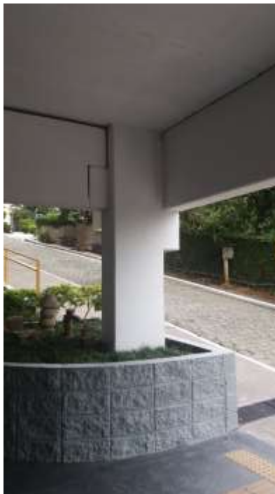
Fig. 1.59- Pilar e viga pré-fabricados no edifício da UnG Fonte: Acervo próprio (2018)
