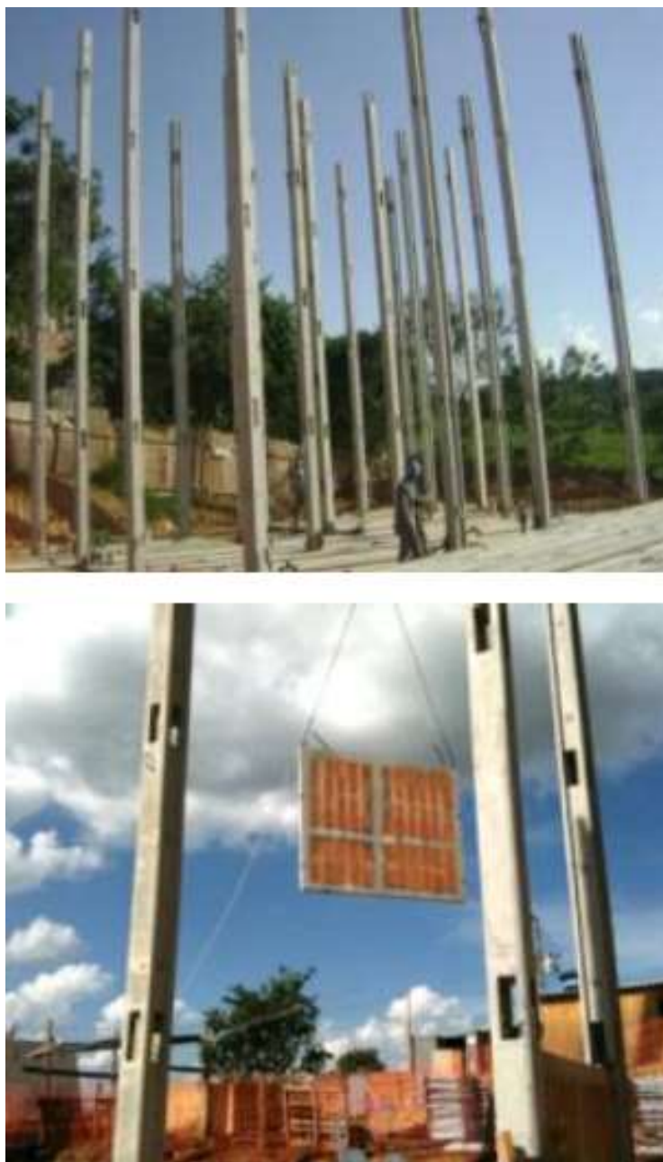
Fig. 2.27 – Canteiro de Obras da Empresa B Fonte: IFB (2017, p. 9)
