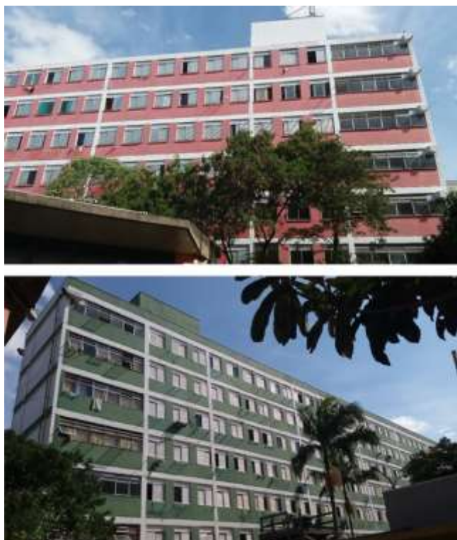
Fig. 1.25- Fachadas dos bloco D e E Fonte: Acervo próprio (2017)
