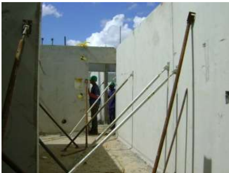
Fig. 2.26 – Escoramento de Painéis da Empresa A Fonte: IPT (2014, p. 10)
