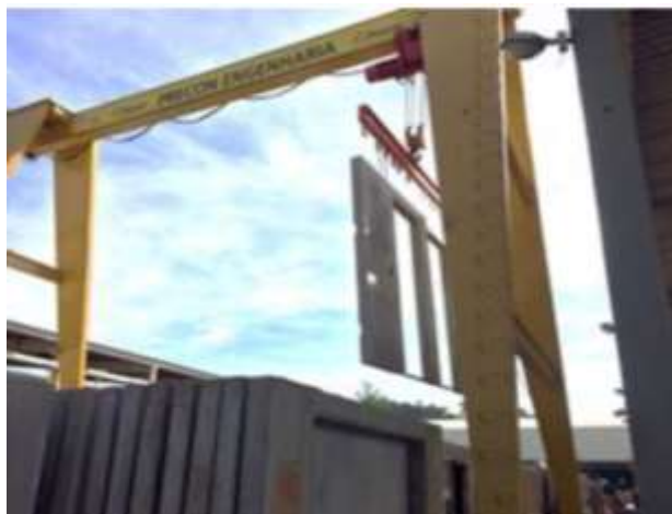
Fig. 2.43 – Içamento de Painéis da Empresa B Fonte: IFB (2017, p. 10)
