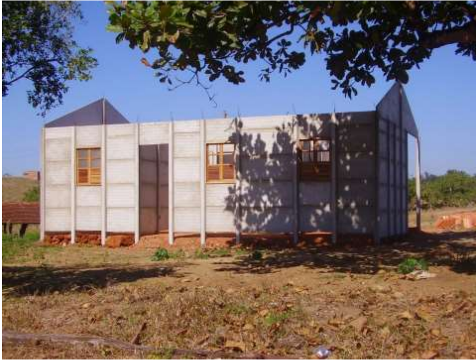
Fig. 2.14 – Casa em Construção com Mourão de Concreto Armado Fonte: CONSTRU-TEC PRÉ-MOLDADOS (2010)
