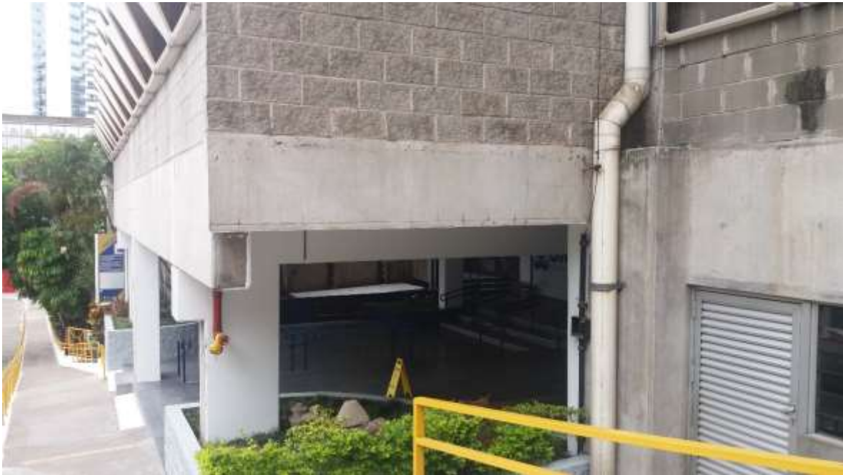
Fig. 1.62- Térreo do edifício Fonte: Acervo próprio (2018)
