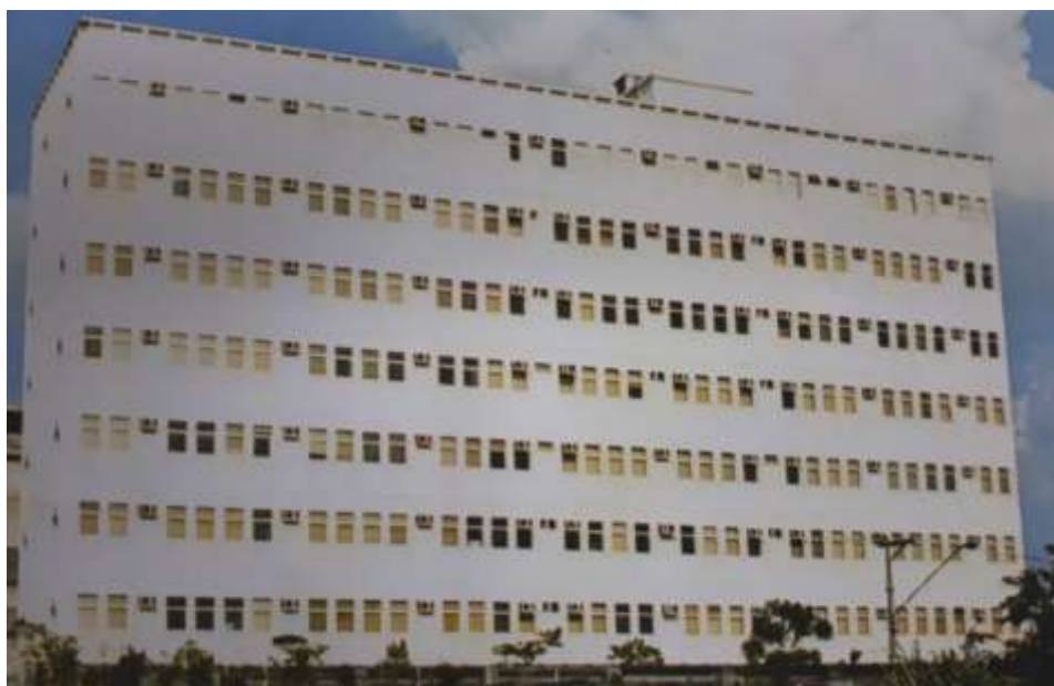
Fig. 1.56- Edifício administrativo da empresa MAFERSA em São Paulo Fonte: VASCONCELOS (2002, p.57)
