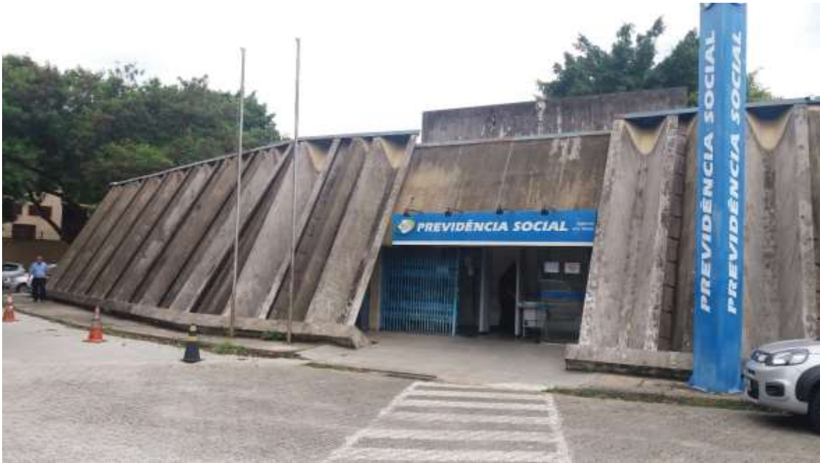
Fig. 1.51- Paredes externas pré-fabricadas Fonte: Acervo próprio (2018)
