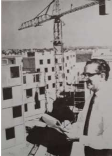
Fig. 1.30- Eng. Carlos Silva no canteiro de obras do Conjunto Parque Novo Irajá Fonte: VASCONCELOS (2002, p. 48)
