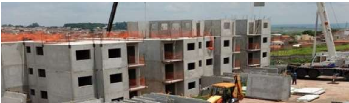
Fig. 2.25 – Canteiro de Obras da Empresa A Fonte: EMPRESA A (2017, n.p.)
