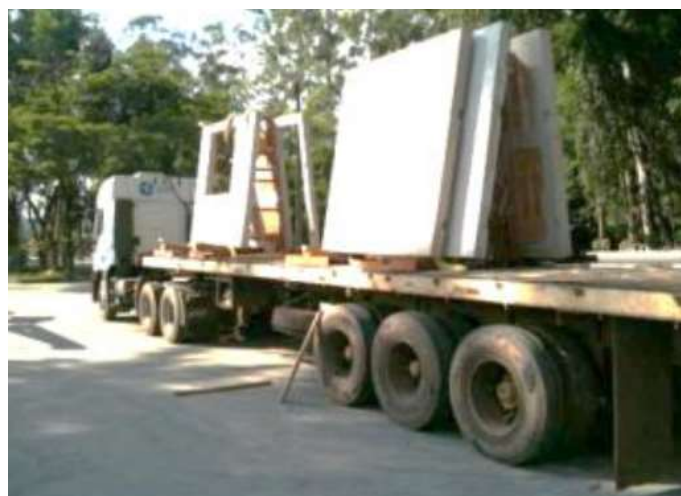
Fig. 2.45 – Transporte das Peças pela Empresa B Fonte: IFB (2017, p. 8)
