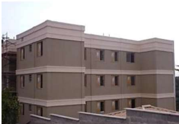
Fig. 2.33 – Edifício com o Sistema Construtivo Desenvolvido pela Empresa B Fonte: IFB (2017, p.10)
