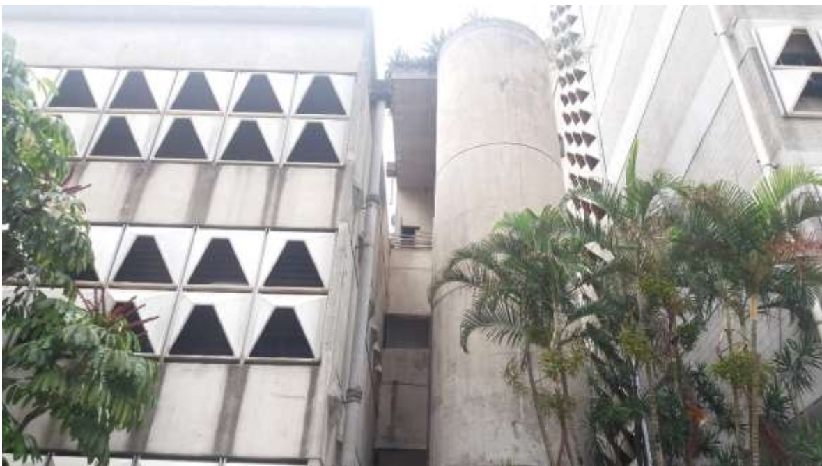
Fig. 1.63- Escadas e torre de banheiros Fonte: Acervo próprio (2018)
