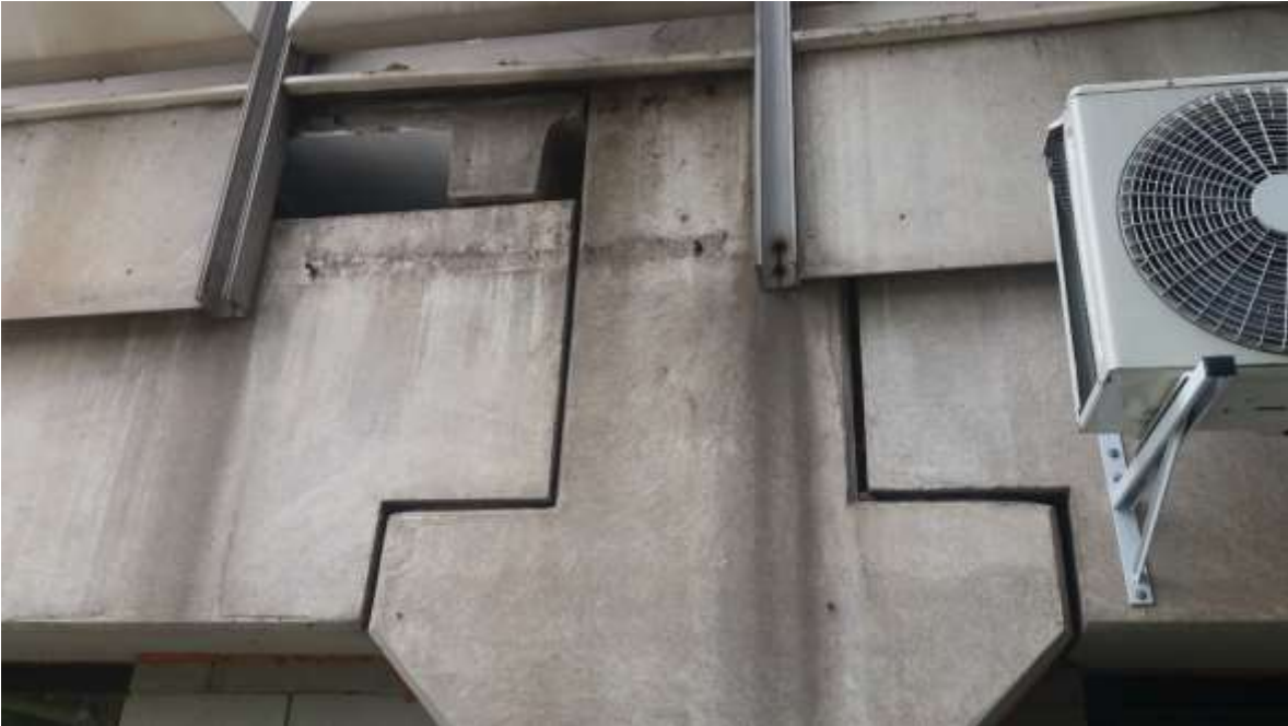
Fig. 1.60- Encaixe da peças pré-fabricadas no edifício da UnG Fonte: Acervo próprio (2018)
