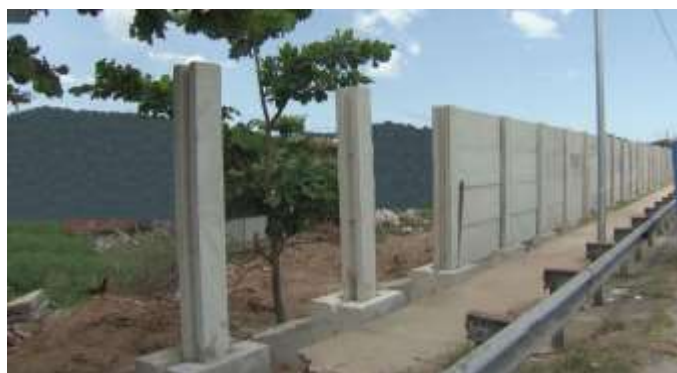
Fig. 2.13 – Muro Pré-moldado de Concreto Armado Fonte: CMARC CONSTRUTORA (2014)
