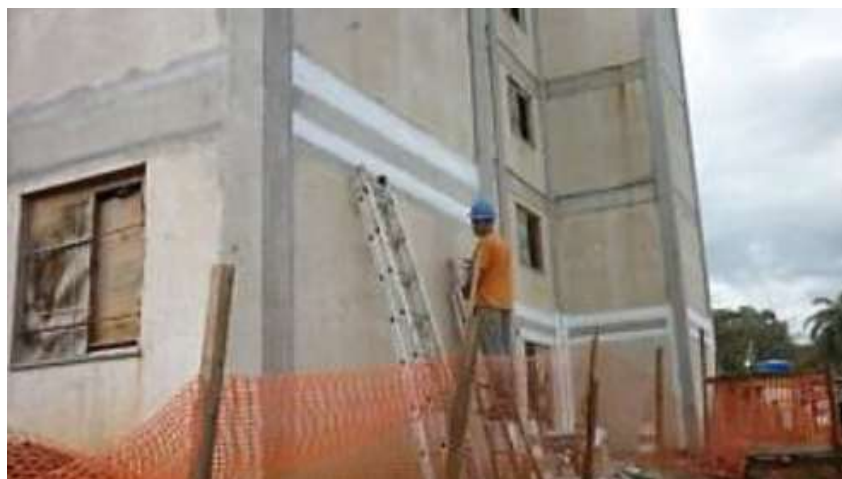
Fig. 2.39 – Encontro entre Painéis de Vedação e Estrutura da Empresa B Fonte: IFB (2017, p. 10)
