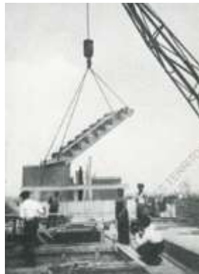
Fig. 1.13 – Içamento de peças pré-fabricadas Fonte: L'ARCHITECTURE D'AUJOURD'HUI (1952, p. 04) in: CERCEAU (2013, p. 75)
