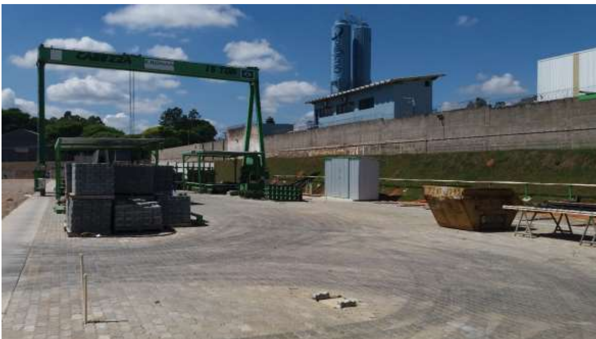
Fig. 3.3 – Fábrica da Kronan em Itupeva Fonte: Acervo próprio (2017)
