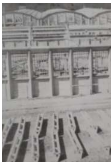
Fig. 1.21- Estocagem de pilares no galpão do Cortume Franco-Brasileiro Fonte: VASCONCELOS (2002, p. 13)
