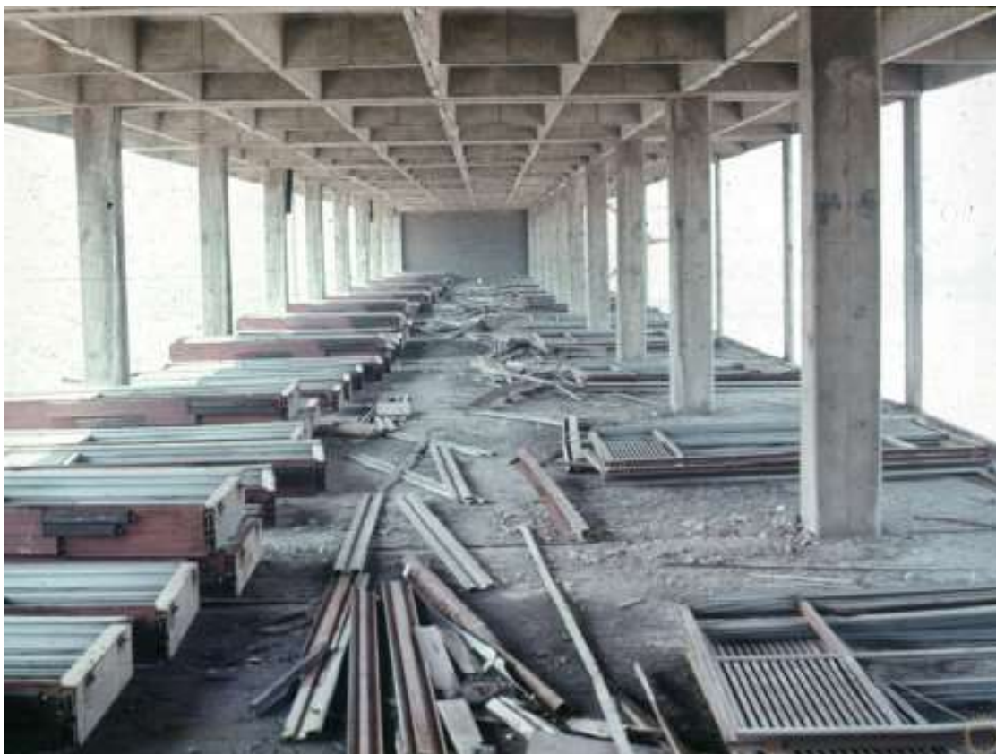
Fig. 3.1 – Peças da montagem do CRUSP Fonte: FAUUSP (in: MONTENEGRO, 2012, p. 188)
