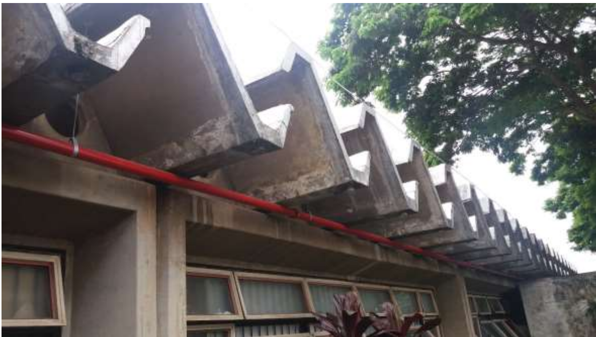
Fig. 1.50- Vigas de cobertura pré-fabricadas Fonte: Acervo próprio (2018)
