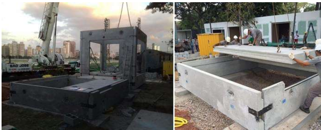
Fig. 3.5 – Montagem da Casa AQUA 2016 Fonte: E-CONSTRUMARKET (2016, n.p.)
