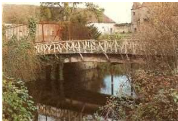
Fig. 1.1 – Primeira Ponte de Concreto Armado Fonte: MARREY(2010, n.p.)
