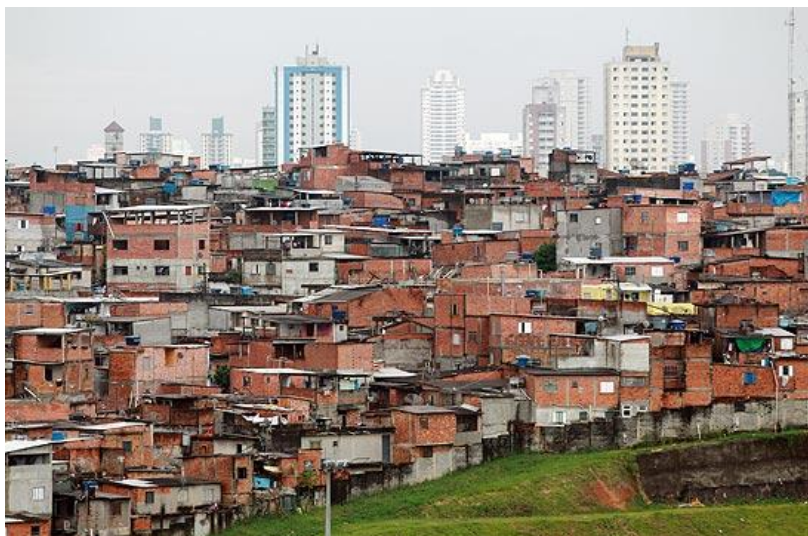
Figura 2.2 - Casas da favela de Heliópolis em fruto da autoconstrução em alvenaria de blocos
