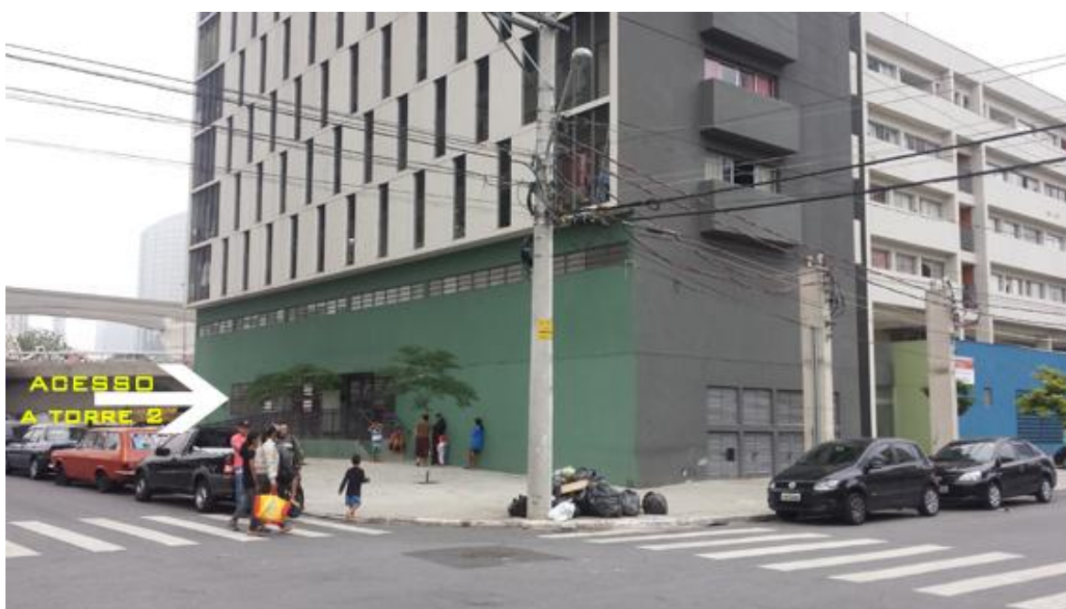
Figura 3.11 - Foto acesso a Torre 02 lote 01. Fonte: Acervo do Autor [2014]
