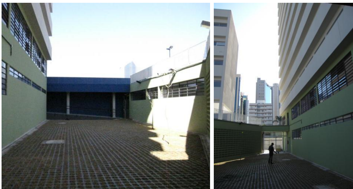
Figura 3.50 - Acesso a UBS. Fonte: Acervo do Autor [2014].
