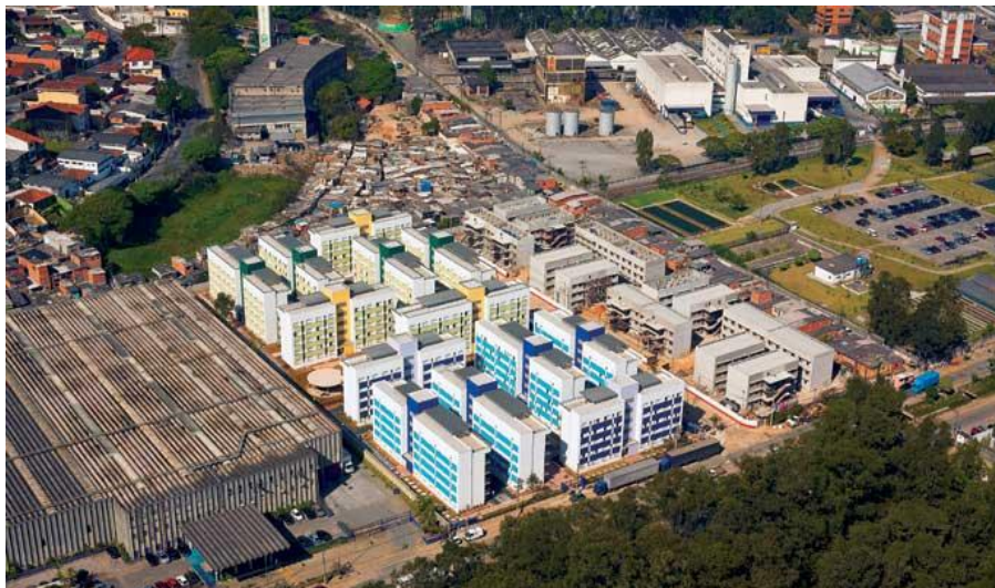
Figura 2.8 Foto aérea do conjunto habitacional.
