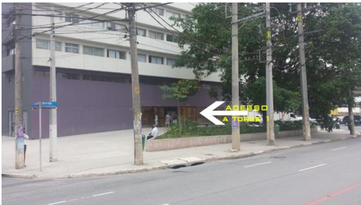
Figura 3.10 - Foto acesso a Torre 01 lote 01. Fonte: Acervo do Autor [2014]
