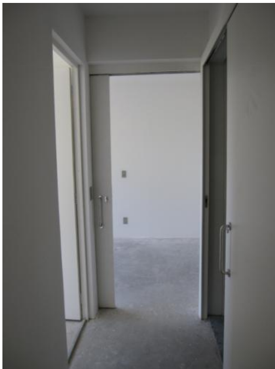
Figura 3.40 - Vista para o acesso aos quartos e ao banheiro demonstrando as portas de correr. Fonte: Acervo do Autor [2014].
