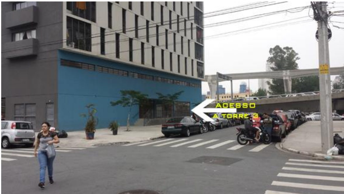
Figura 3.12 - Foto acesso a Torre 3 lote 2. Fonte: Acervo do Autor [2014]
