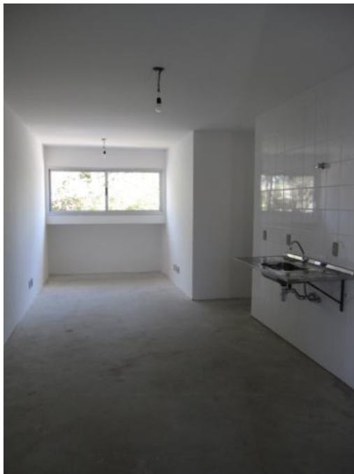
Figura 3.38 - Vista da sala e cozinha. Fonte: Acervo do Autor [2014].
