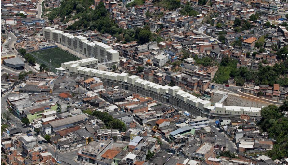
Figura 2.11 Imagem aérea do conjunto habitacional Parque Novo Santo Amaro.
