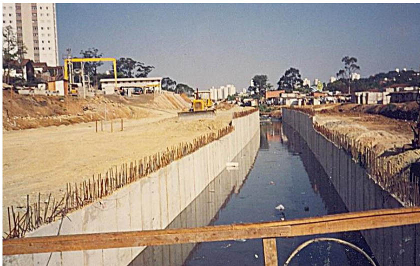
Figura 1.17 Obra de retificação do Córrego Águas Espaiadas.
