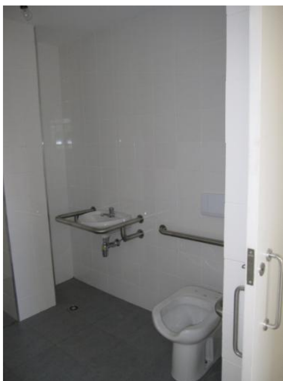
Figura 3.43 - Banheiro adaptado. Fonte: Acervo do Autor [2014].
