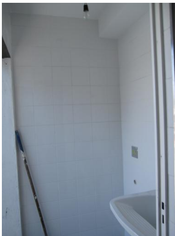
Figura 3.37 - Área de Serviço. Fonte: Acervo do Autor [2014].
