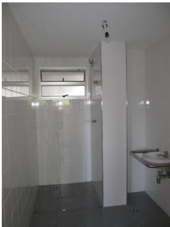
Figura 3.42 - Banheiro adaptado. Fonte: Acervo do Autor [2014].
