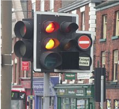
Gambar 1. Lampu Lalu Lintas
