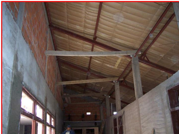
*Figura 7: Vista de la futura cámara ventilada donde se dispondrán los tanques de acumulación del sistema de agua caliente solar y de la aislación térmica bajo la cubierta metálica.*
