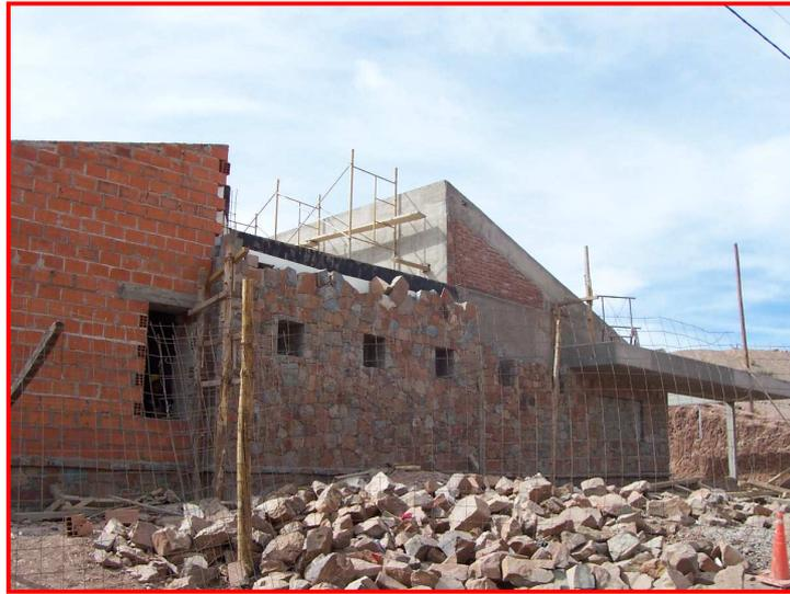
*Figura 5: Vista de la Fachada Oeste; se aprecia el doble muro de piedra en un sector y de bloque cerámico y piedra en otro.*
