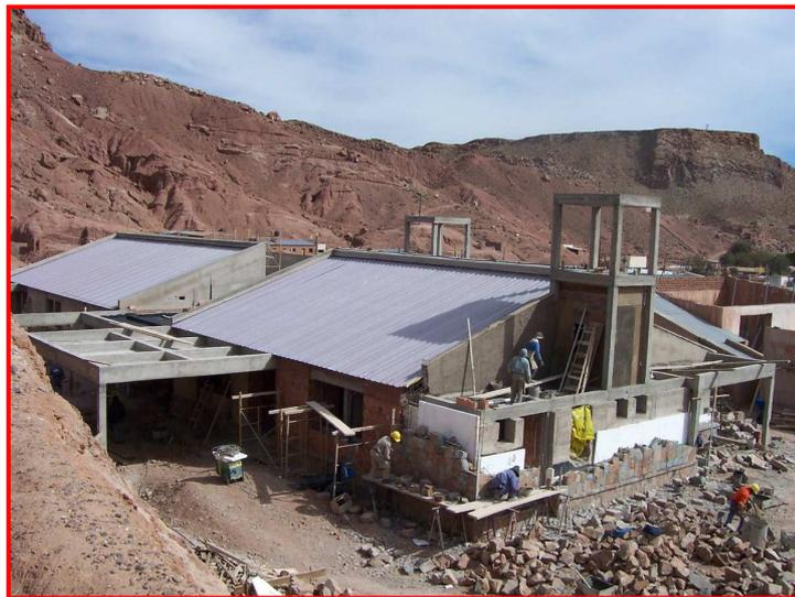
*Figura 6: Vista de las fachadas Este y Sur donde se aprecia el doble muro con la aislación térmica en su interior.*
