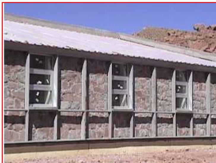
Figura 4: Vista de la fachada Norte con el Trombe de cuarcita en construcción, las ventanas y la aislación perimetral.
