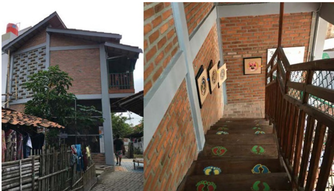
Gambar 4. Kondisi gedung PAUD yang baru dibangun (Sumber: Gumulya, 2016)
