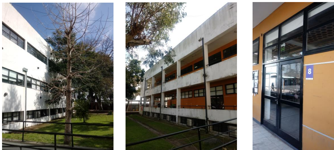
Figura 3: Bloque de aulas analizado. Fuente: elaboración propia.
