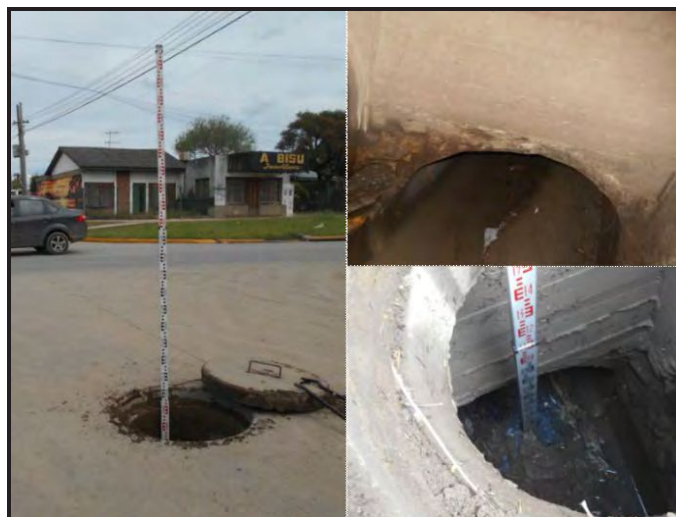
Figura 3.- Fotografías de relevamientos de los desagües
